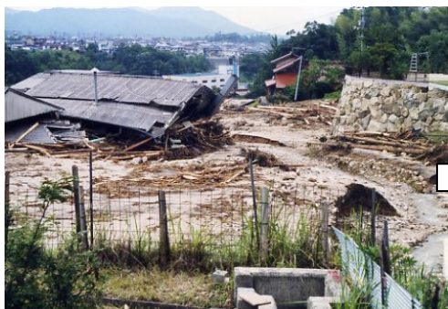
土石流で埋まった中道川沿いの工場
