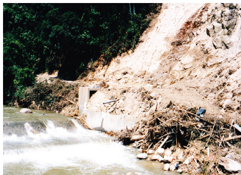
原田橋下流(門前井手に土石・流木が堆積)
