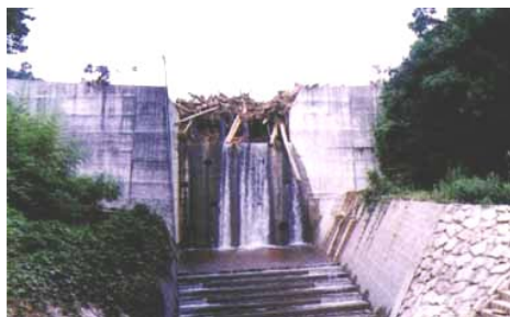
荒谷砂防ダムに山程堆積した土砂・流石・流木
