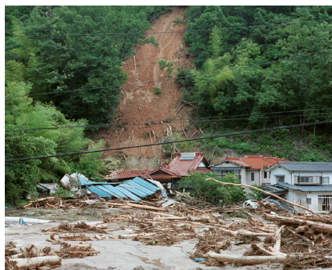
荒谷川の土石流と丹田宅裏山崩れ
