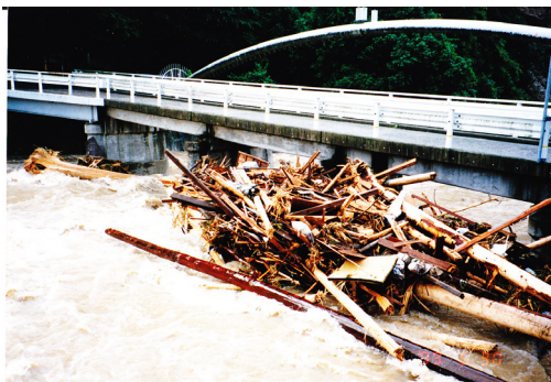
原田橋の橋桁近くまで流木堆積
