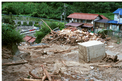
宮ヶ原トンネル手前の県道より旧高木宅をみる
