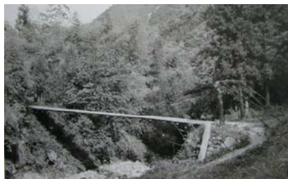
写真は白川の吊橋
