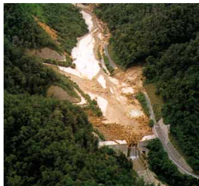
荒谷砂防ダムに山程堆積した土砂・流石・流木
