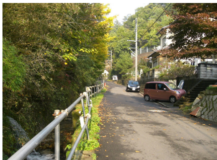
荒谷川や道路の復旧が進まない所
