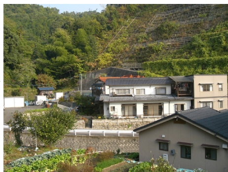
丹田宅裏の山崩れは急傾斜地を のりわくこうほう 「法枠工法」で復旧
