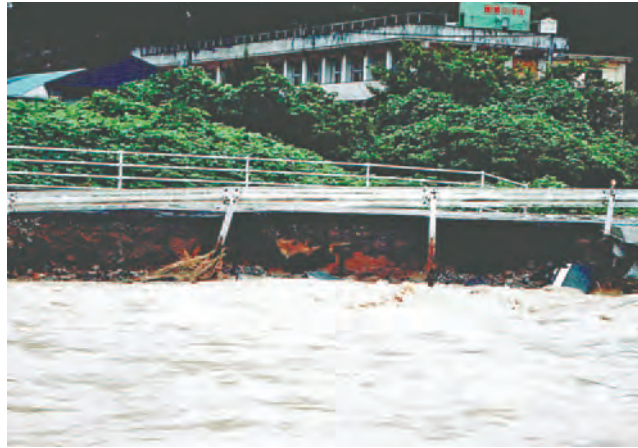
国道 482 号線が約 50 m にわたり陥没
