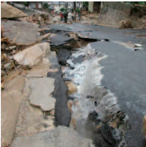
アスファルトがはがれて水が流れ落ちさらに土を削る。
