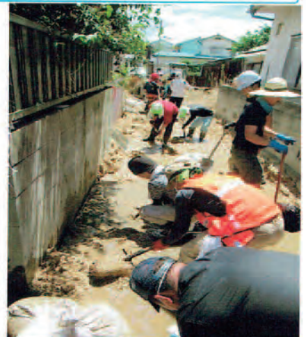
7月22日待望のユンボ$ ダンプ京都からリースして到着!! 50cm土砂の下の側溝を探して開口、流水を止める ↑
