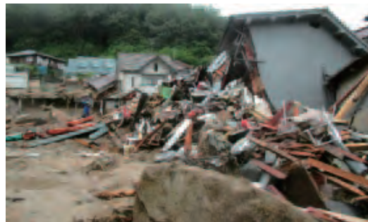
土石流により破壊された住宅。地震などによる倒壊とは異なる破損状況を見せる。
