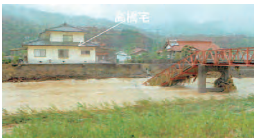
大寺橋上流右岸市道崩落・護岸崩落
