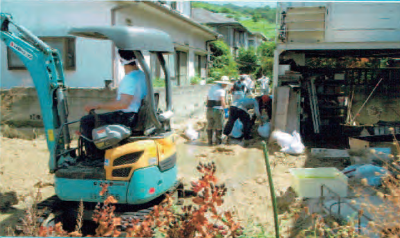
7月22日待望のユンボ$ ダンプ京都からリースして到着!! 50cm土砂の下の側溝を探して開口、流水を止める ↑
