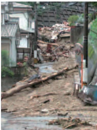
梅河団地の状況。治山ダムを突破した土石流が道路を駆け抜けた。
