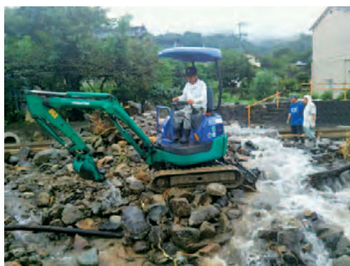
鳴川の土石流で芸備線を遮断・水は駅構内や民家の床下へ／ボランティアによる緊急除斥作業
