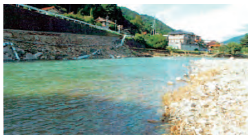
大寺橋上流右岸市道崩落・護岸崩落（7月9日）
