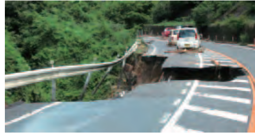
県道 34 号線。土砂流出により路面が崩落。
