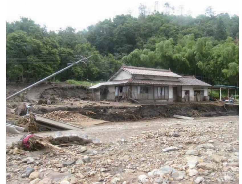
②土石流による護岸と家屋の被害
