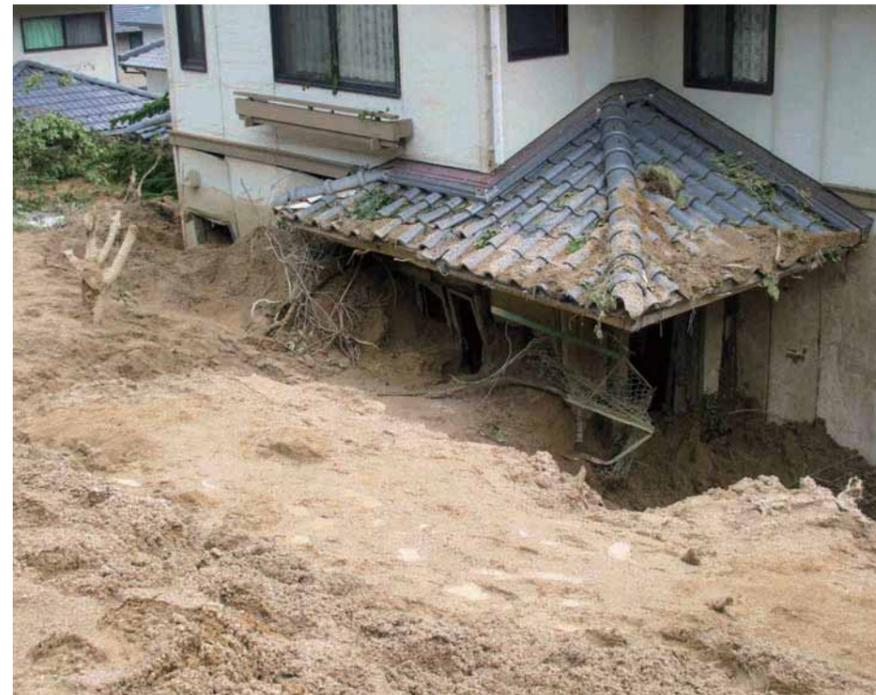
土石流による家屋の被害
