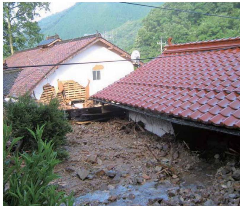
④大量の土石で損壊した民家（写真奥）と倉庫（写真手前）
