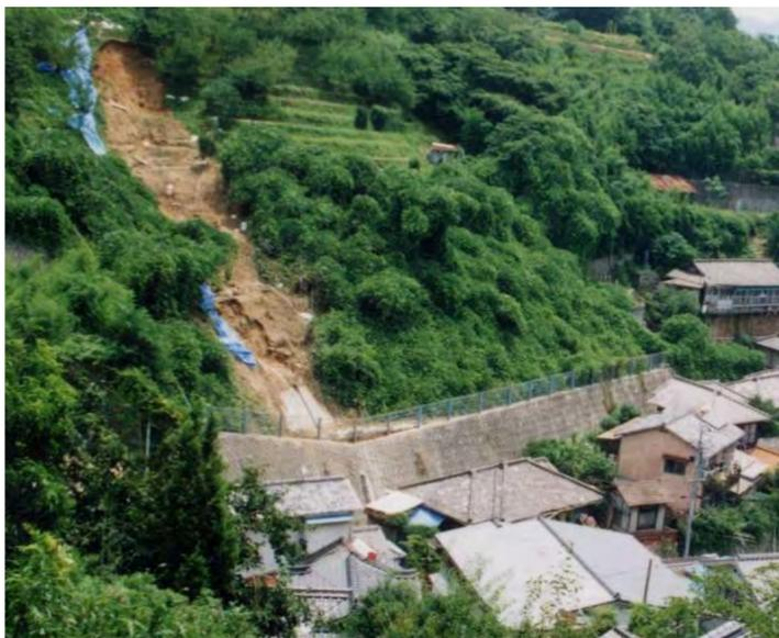
待受擁壁工の土砂災害捕捉事例
