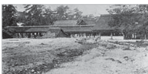
枕崎台風による被災状況 (昭和20年)
