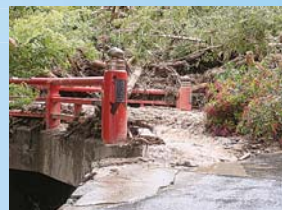
流下した土砂と流木で閉塞した滝橋 (平成17年台風第14号による)
