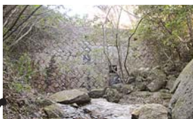
谷積 (たにづみ) の8号堰堤 (昭和33年施工)
