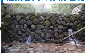
野面積 (のづらづみ) の1号堰堤 (昭和24年施工)
