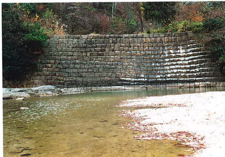
写真 5-1 オランダ堰堤 (滋賀県大津林業事務所 提供)
