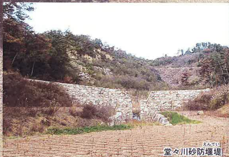
修復された鷹ヶ迫砂留
