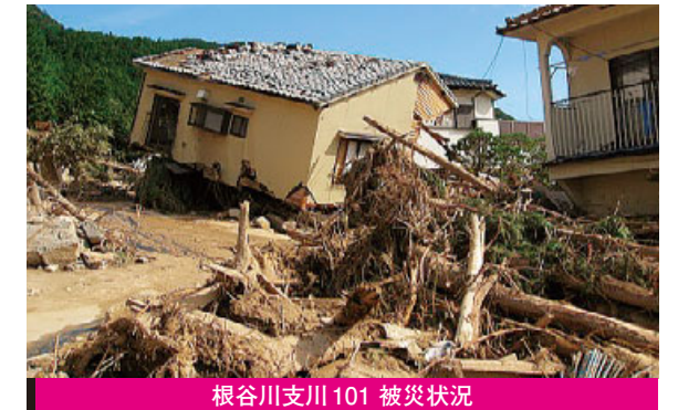
根谷川支川101 被災状況
