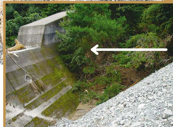
上原川(下流)砂防堰堤
