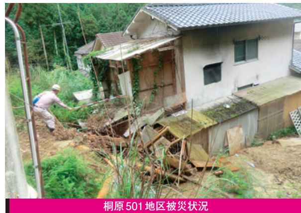
桐原501地区被災状況
