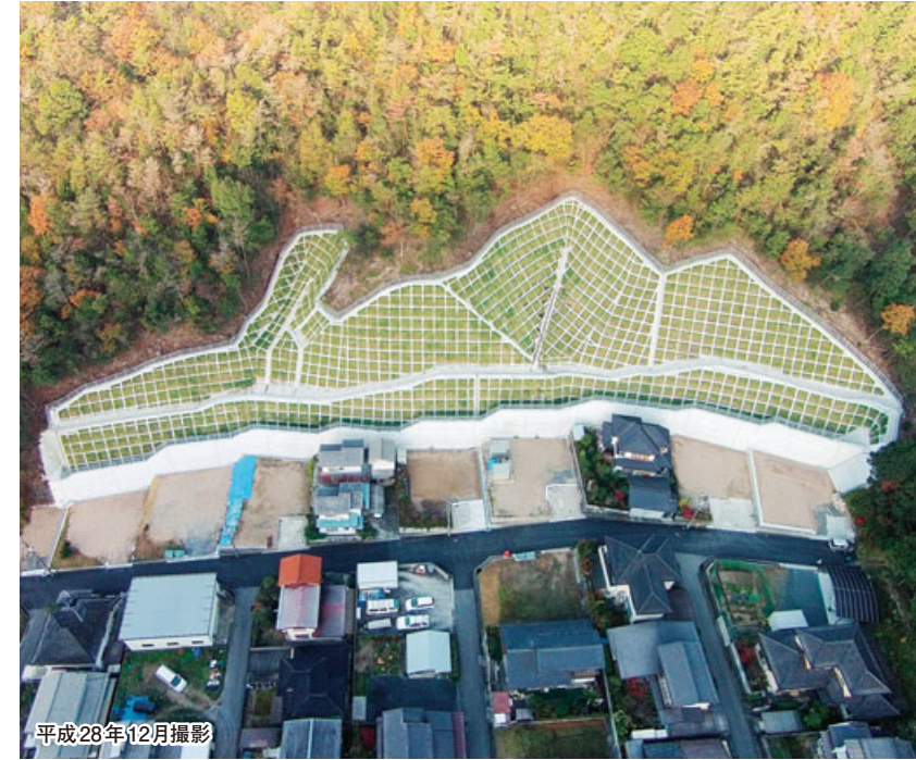
法枠工 (災害関連緊急急傾斜地崩壊対策事業) H28.2完成
