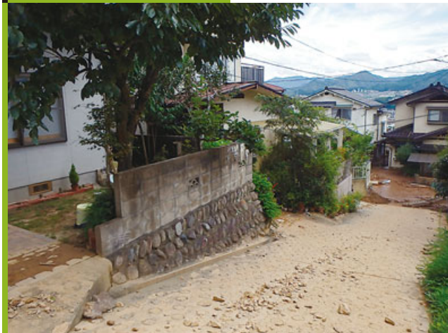
土砂の流出状況
