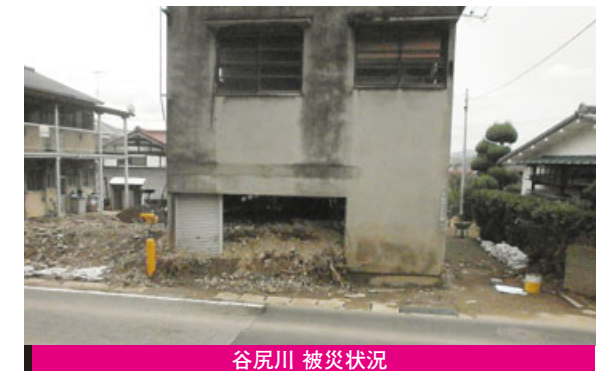
谷尻川 被災状況
