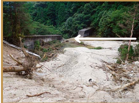
下の谷川砂防堰堤
