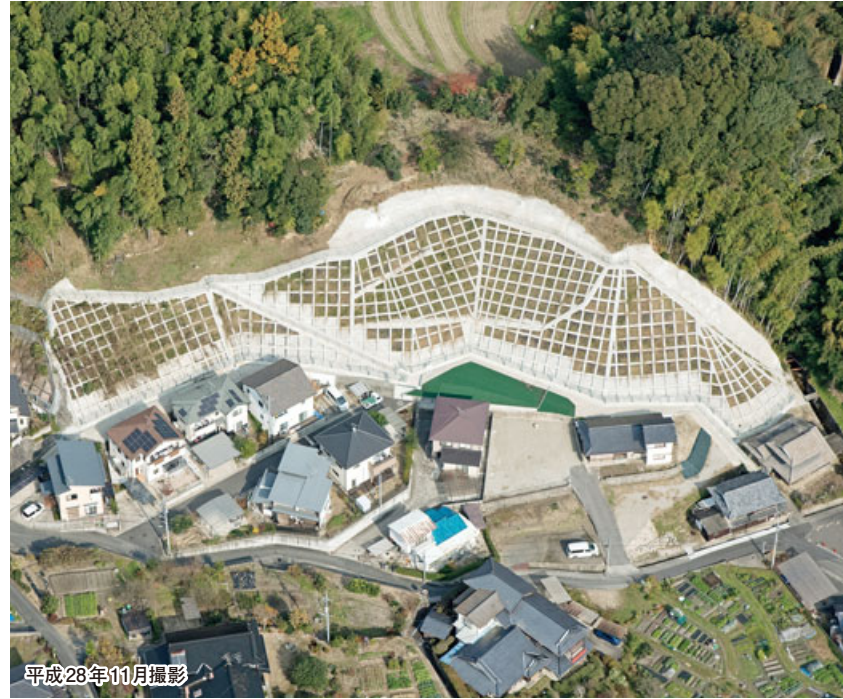
法枠工 (災害関連緊急急傾斜地崩壊対策事業) H27.9完成
