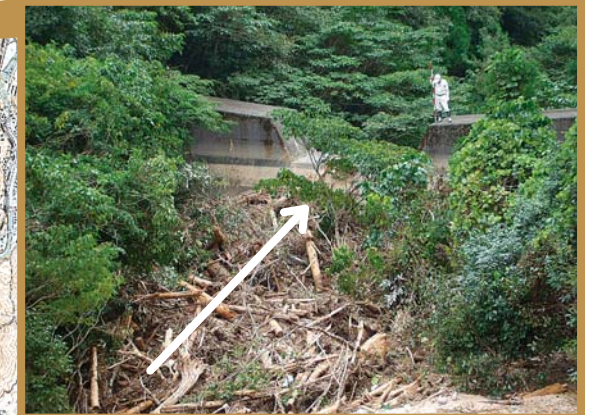
桧山川砂防堰堤
