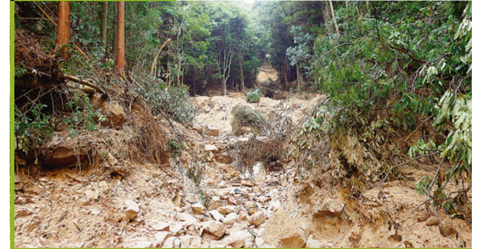
溪流の荒廃状況
