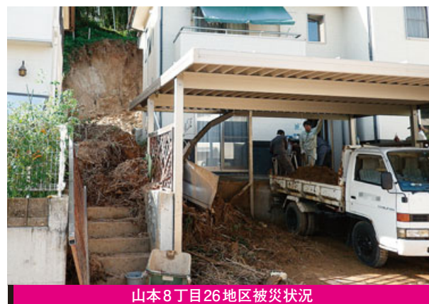
山本8丁目26地区被災状況
