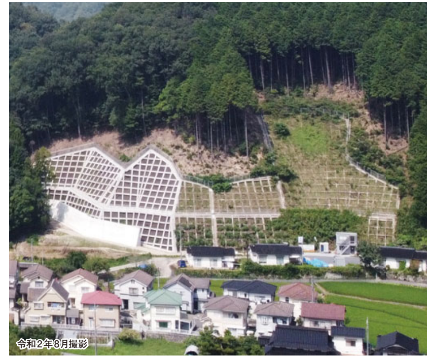
法枠工 (災害関連緊急急傾斜地崩壊対策事業) H27.11完成
