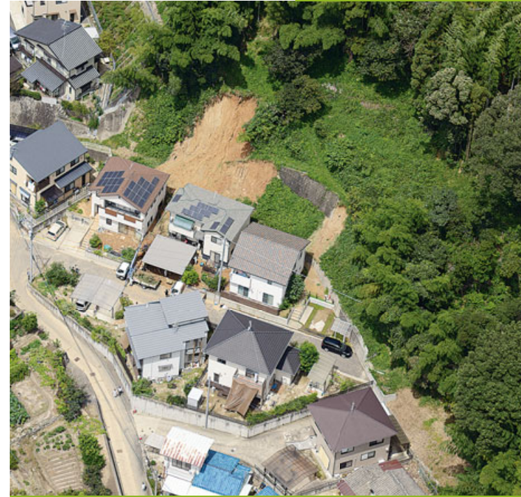
斜面崩壊状況
