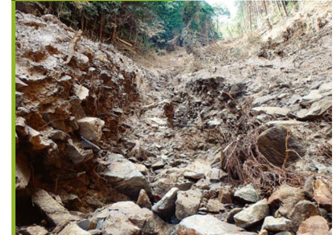
溪流の荒廃状況
