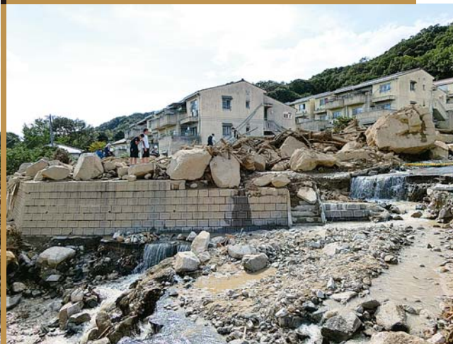
被災状況(安佐南区八木3丁目 県営緑丘住宅)
