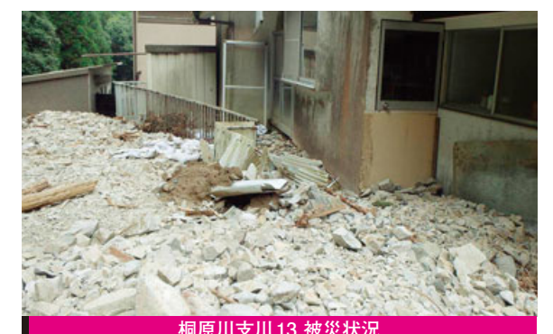
桐原川支川13 被災状況
