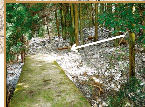
上原川(上流)砂防堰堤
