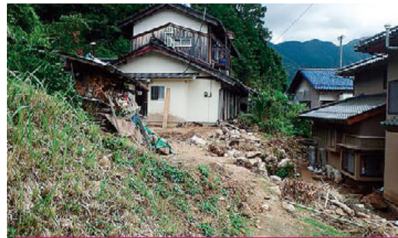
根谷川支川65 被災状況
