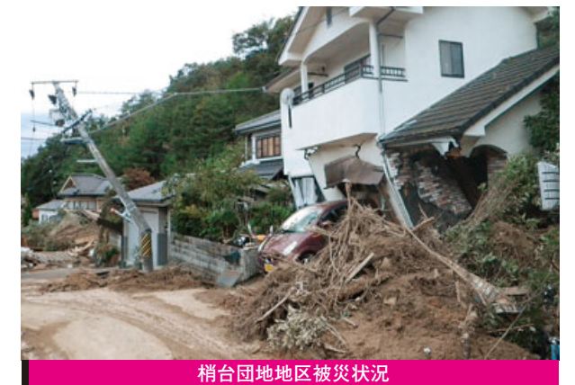
梢台団地地区被災状況
