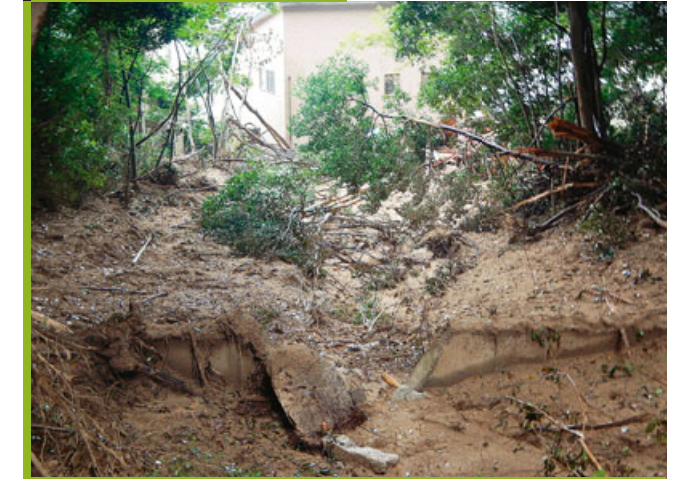
土砂の流出状況
