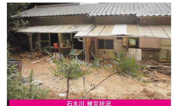
石丸川 被災状況
