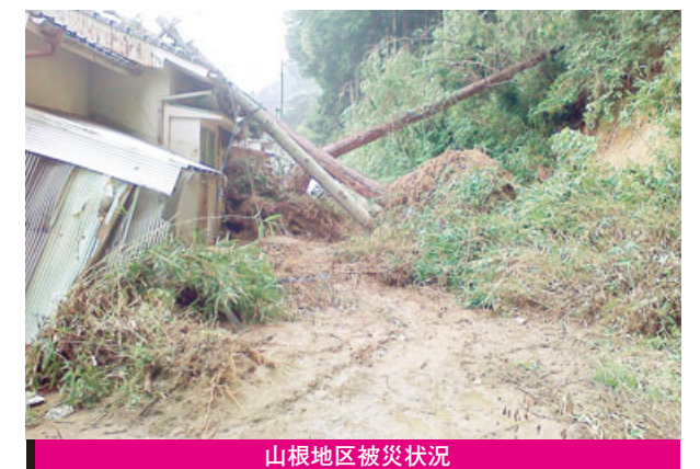
山根地区被災状況
