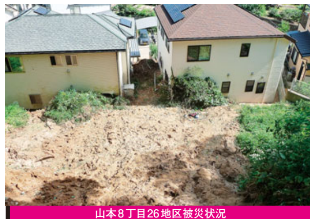
山本8丁目26地区被災状況
