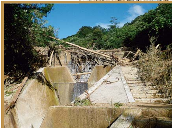
玖谷川砂防堰堤
