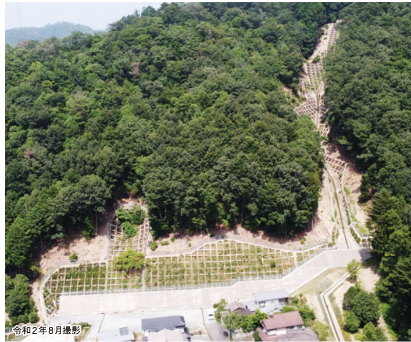
法枠工 (災害関連緊急急傾斜地崩壊対策事業) H27.12完成
