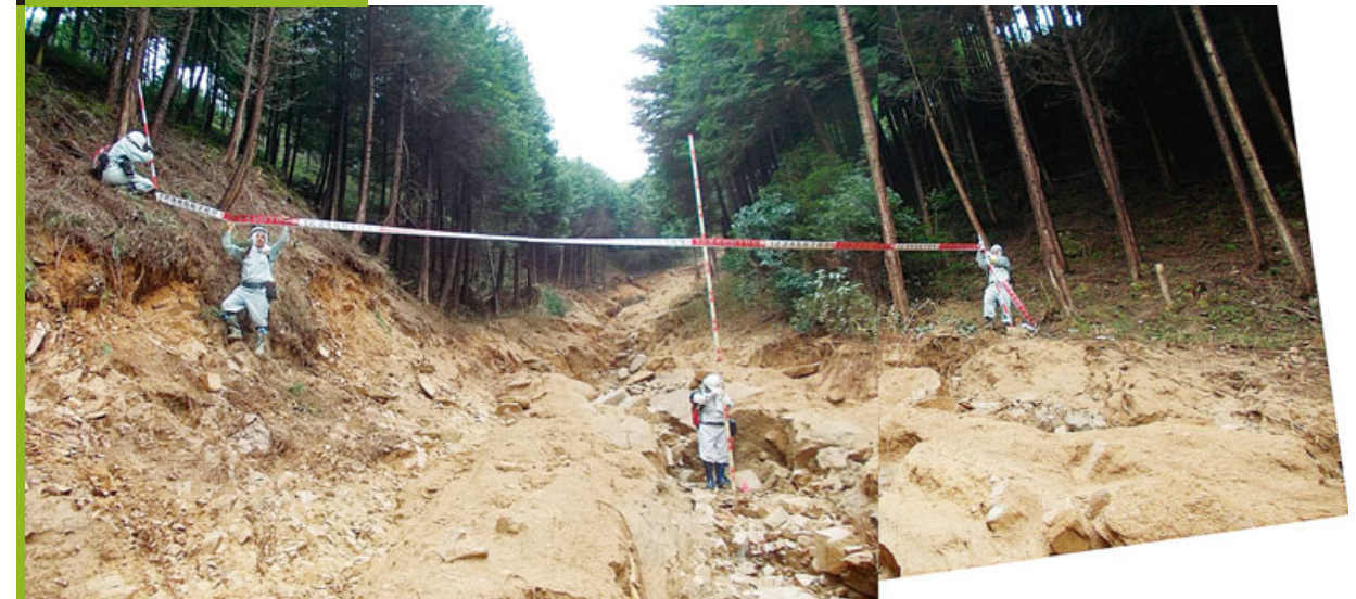
溪流の荒廃状況
