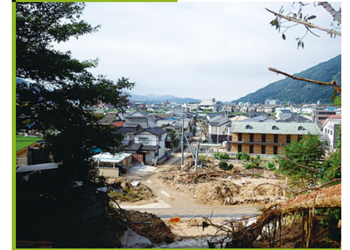
崩土の流出状況
