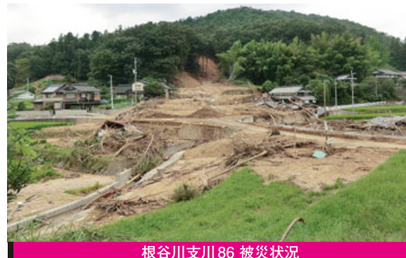
根谷川支川86 被災状況
