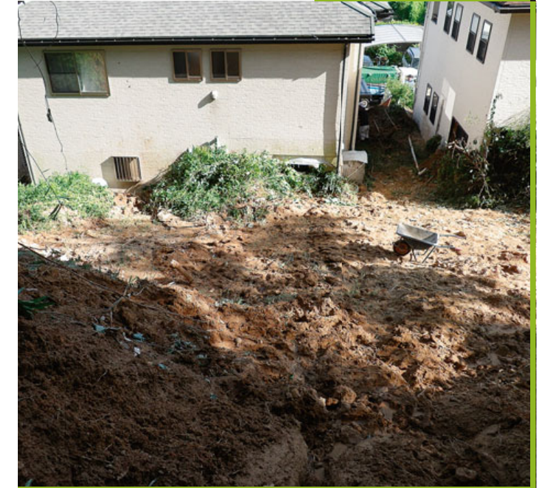
崩土の流出状況
