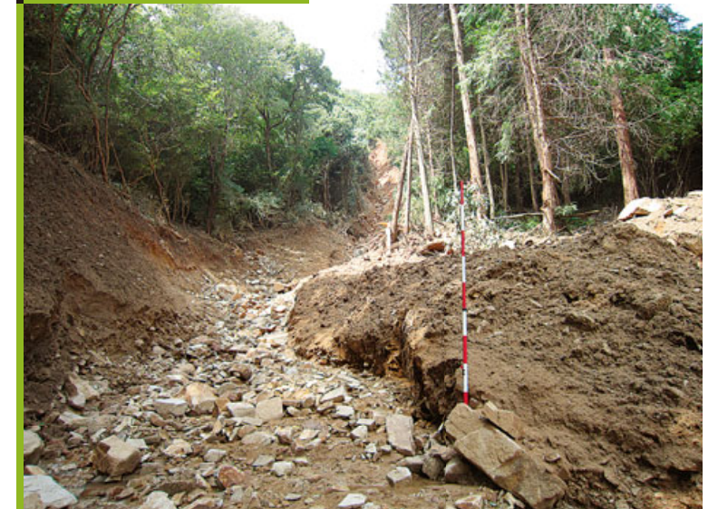
溪流の荒廃状況
