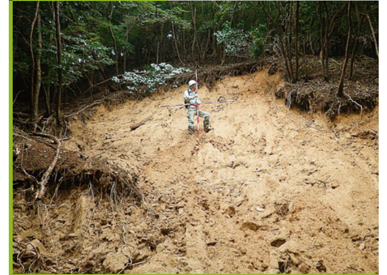
源頭部 (土砂発生源)
