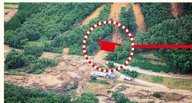
篠堂川上流の斜面崩壊
