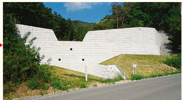
災害関連緊急砂防事業により整備した砂防えん堤(篠堂谷上)
