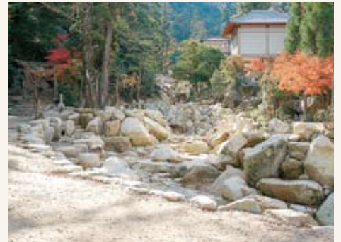
溪流保全工（下流側）
