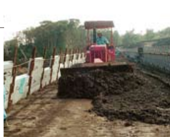
ブルドーザによる内部材の敷均し
