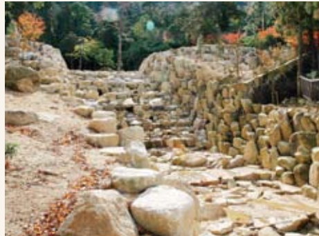
2号砂防えん堤
