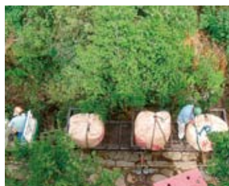
モノレールによる資材運搬状況
