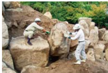
自然石据え付けの様子
