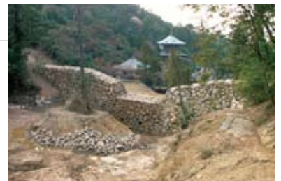
自然石積による修景（上流部・天端部）
