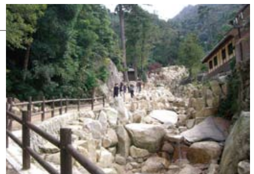
溪流保全工（上流側）
