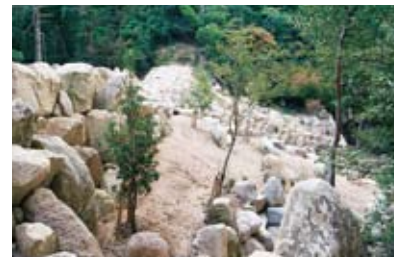
えん堤袖下流部の緑化植栽
