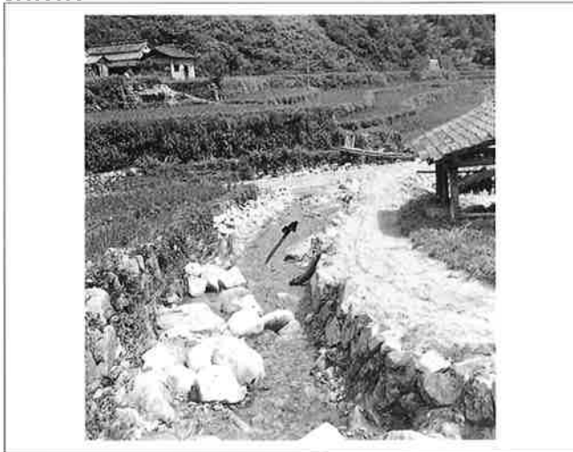
撮影日：S.27.7.20 撮影場所：賀茂郡荘野村 撮影者：佐久間 県道暗渠を堵塞し、県道に溢れた
