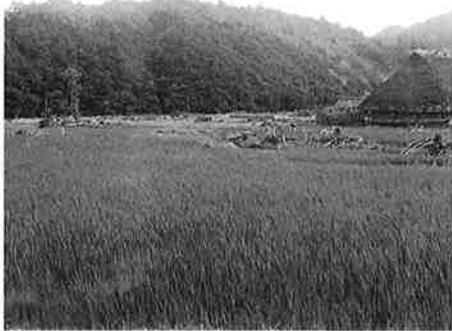
撮影日：S.27.8.2 撮影場所：比婆郡下高野山村 撮影者：高田 昭和27年7月29・30日の豪雨被害状況
