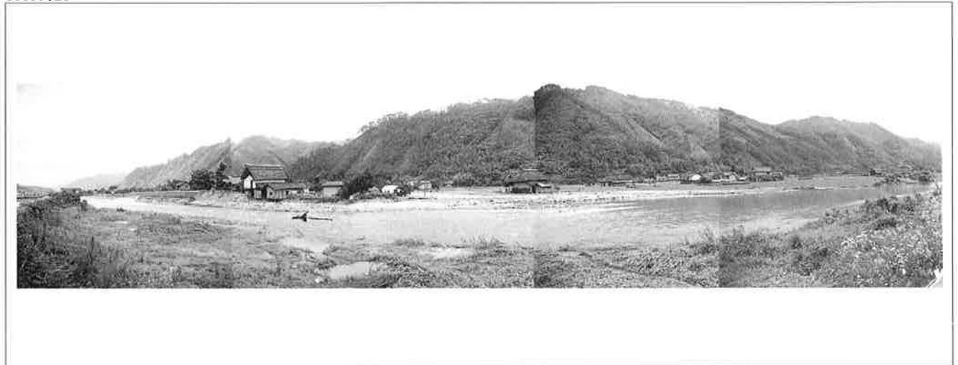
撮影日：S.27.7.12 撮影場所：御調郡河内村 撮影者：坂田 破堤ヶ所
