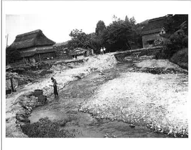
撮影日：S.27.7.16 撮影場所：芦品郡有磨村 撮影者：阿座上 被害状況
