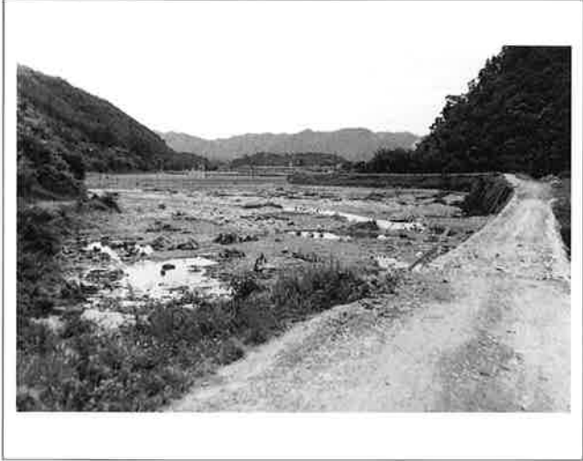
撮影日：S.27.7.19 撮影場所：豊田郡長谷村 撮影者：佐久間 下流左岸欠潰箇所 下流氾濫状況
