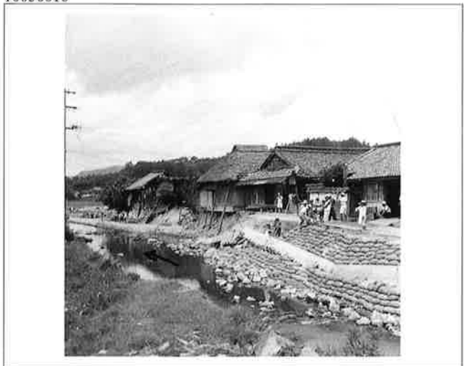
撮影日：S.27.7.19 撮影場所：豊田郡南方村 撮影者：佐久間 三田地内県道流失
