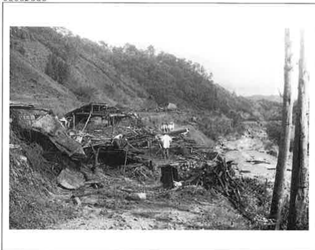
撮影日：S.27.8.2 撮影場所：比婆郡下高野山村 撮影者：高田 昭和27年7月29・30日の豪雨被害状況
