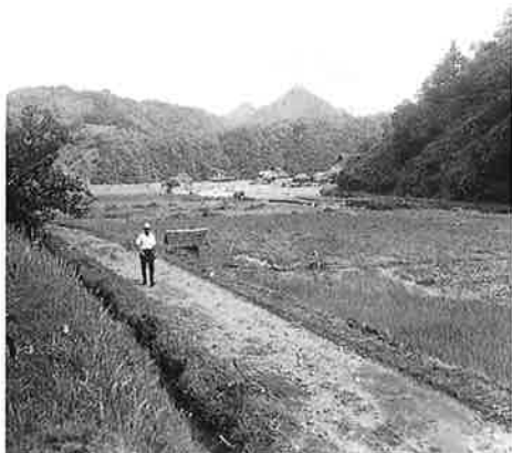
撮影日：S.27.8.2 撮影場所：比婆郡下高野山村 撮影者：高田 昭和27年7月29・30日の豪雨被害状況
