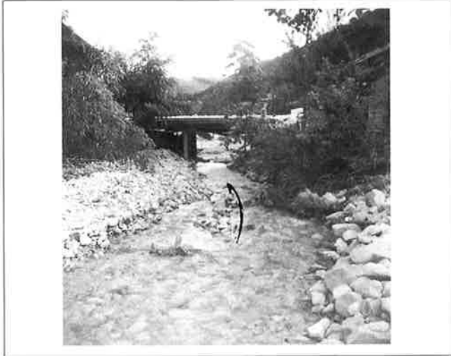
撮影日：S.27.7.16 撮影場所：沼隈郡本郷村 撮影者：阿座上 本郷川合流点前 本川へ次から次へと土砂を流送する ①
