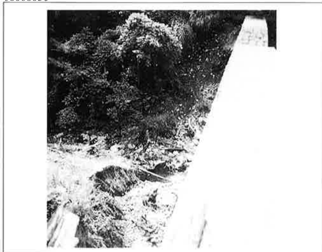
撮影日：S.27.8.28 撮影場所：比婆郡西城町 撮影者：阿座上 昭和21年度施工堰堤
