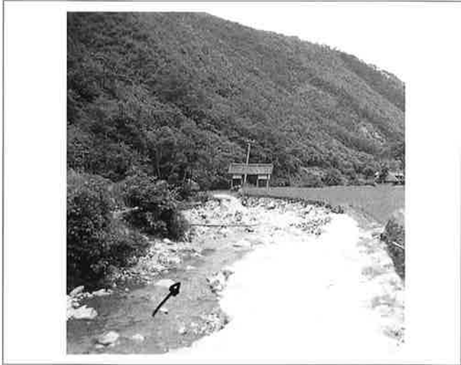
撮影日：S.27.7.18 撮影場所：豊田郡長谷村 撮影者：佐久間 上流庵寺付近道路流失箇所
