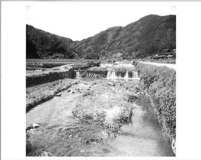
撮影日：S.27.7.16 撮影場所：芦品郡服部村 撮影者：阿座上 河床に井堰築造の為、断面狭小となっている 洪水時越水（道路上を）するのはあたりまえである
