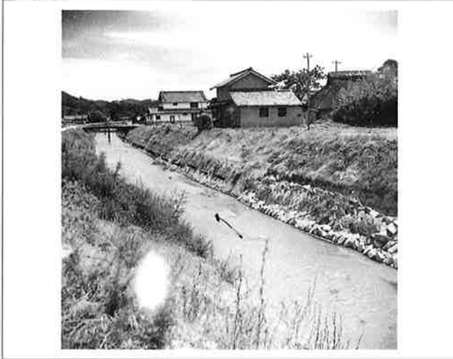
撮影日：S.27.7.16 撮影場所：不明 撮影者：阿座上 河床洗堀し、80cm～1m低下 …印が原河床
