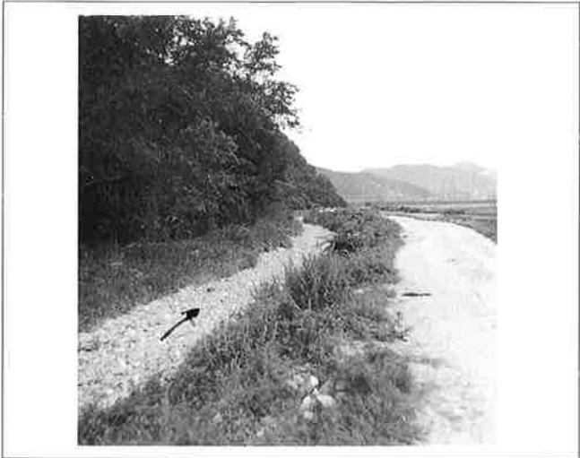
撮影日：S.27.7.18 撮影場所：豊田郡長谷村 撮影者：佐久間 下流天井川部分中流より河積小 洪水は道路上を溢流し、右岸耕地に流入した
