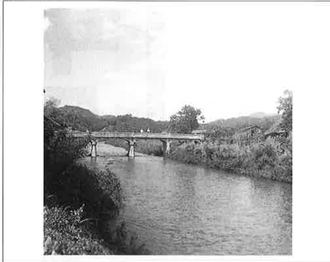
撮影日：S.27.8.2 撮影場所：比婆郡下高野山村 撮影者：高田 下門田橋における洪水位（ボールの位置）を示す
