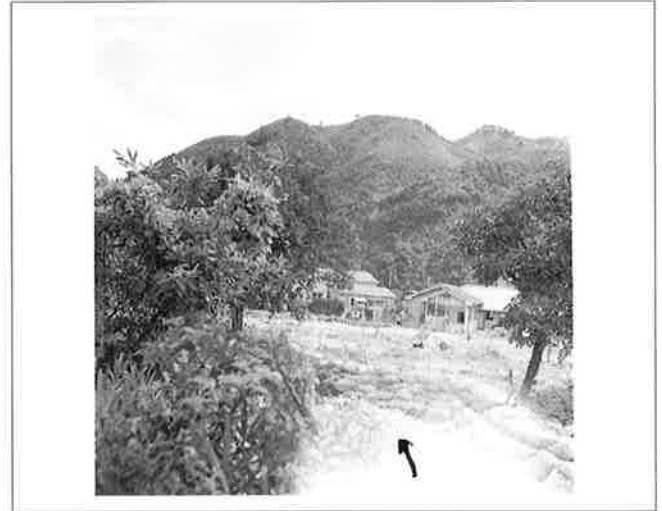
撮影日：S.27.7.18 撮影場所：三原市 撮影者：佐久間 下流堤防欠壊箇所より右岸紅梅園を望む
