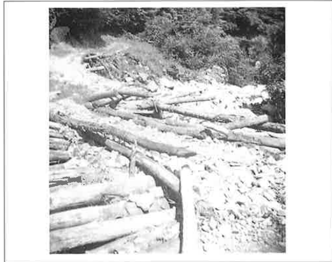
撮影日：S.27.8.28 撮影場所：比婆郡西城町 撮影者：阿座上 上流荒廃 3
