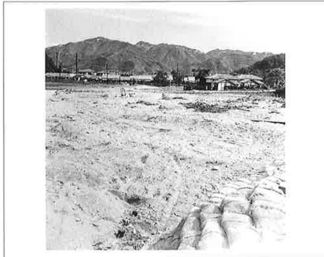
撮影日：S.27.7.18 撮影場所：三原市 撮影者：佐久間 下流堤防欠壊箇所左岸より下流市営住宅を望む
