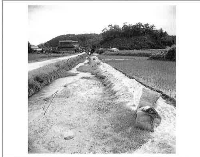
撮影日：S.27.7.16 撮影場所：芦品郡服部村 撮影者：阿座上 ○印合流点 土砂を出している
