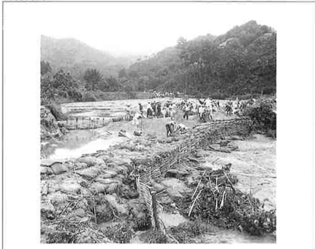
撮影日：S.27.7.14朝 撮影場所：豊田郡大乘村 撮影者：坂田 降雨中の作業（第二締切）
