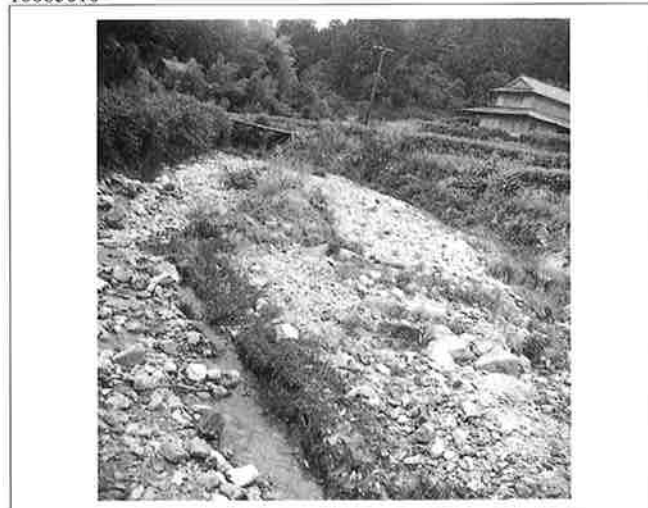
撮影日：S.27.7.18 撮影場所：御調郡八幡村 撮影者：阿座上 上流 石礫堆積
