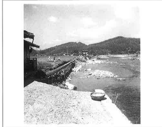
撮影日：S.27.8.3 撮影場所：比婆郡高村 撮影者：高田 昭和27年7月29・30日の豪雨に依り指定府県道の欠壊の状況 上より下へ
