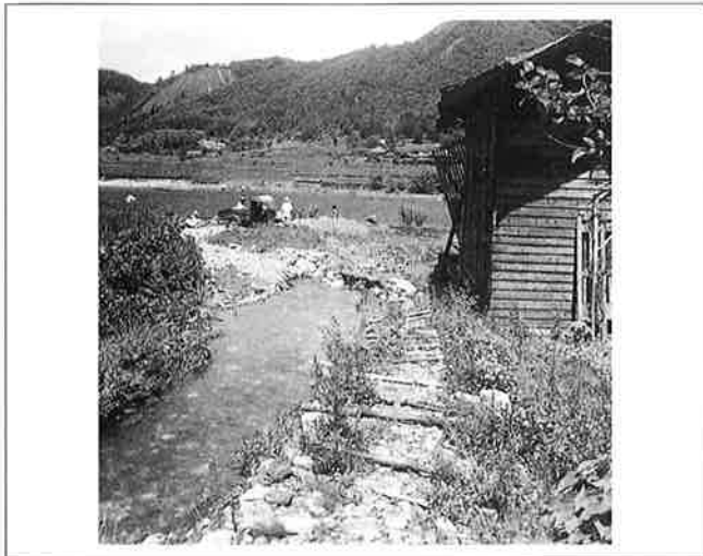
撮影日：S.27.8.3 撮影場所：比婆郡西城町 撮影者：高田 昭和27年7月29・30日豪雨に依る県道埋没状況 29日12時～30日3時まで3時間雨量217mm 上より下へ
