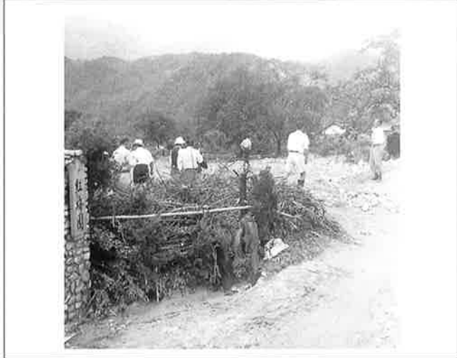
撮影日：S.27.7.11 撮影場所：三原市 撮影者：高田 右岸
