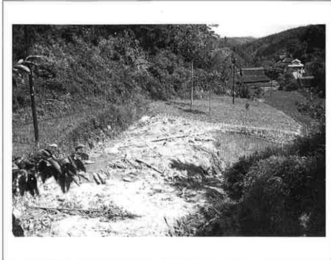
撮影日：S.27.7.16 撮影場所：芦品郡服部村 撮影者：阿座上 最上流崩壊
