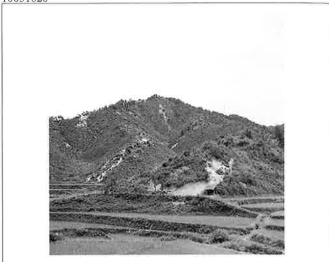
撮影日：S.27.7.19 撮影場所：不明 撮影者：佐久間 上流山腹 山腹工をなした傷跡がある 部落共有林であるため乱伐 谷が北東に向いているため耕地耕作者は樹木生育を好まない
