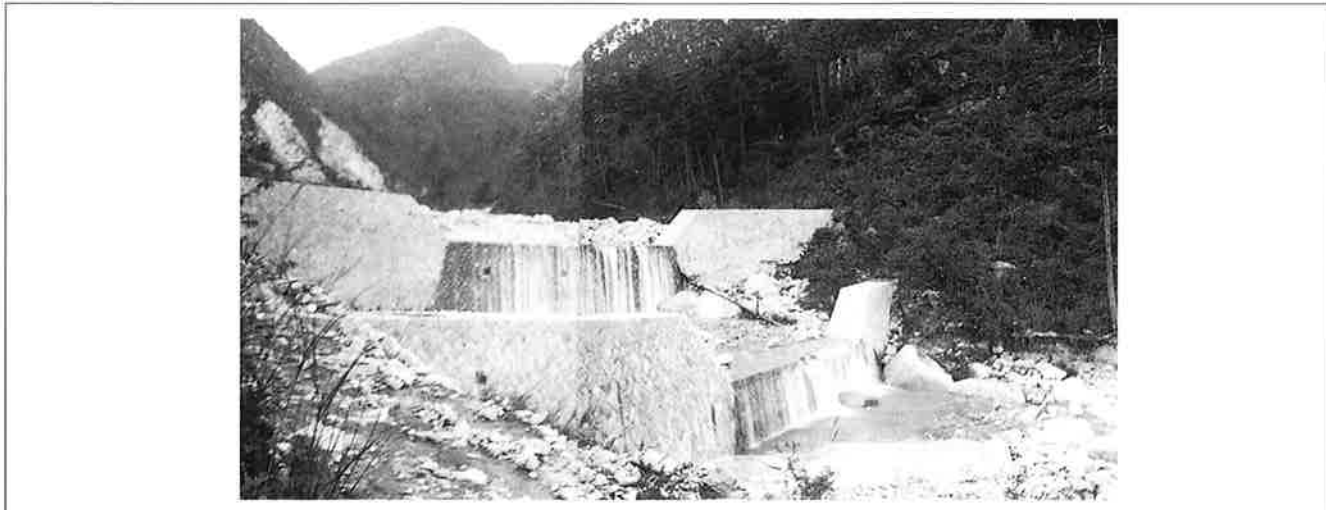
撮影日：S26.10.末 撮影場所：佐伯郡小方町 撮影者：高田技師 昭和24.25年度施工
