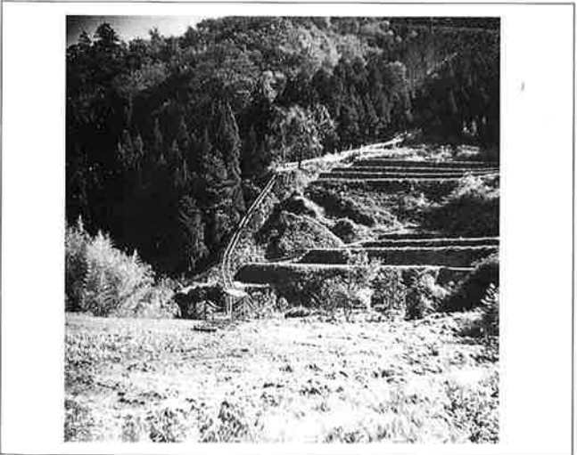
撮影日：S26.11.4 撮影場所：山県郡戸河内町 撮影者：坂田 （上流）木材を曳出す木馬道が川の上へ架かる
