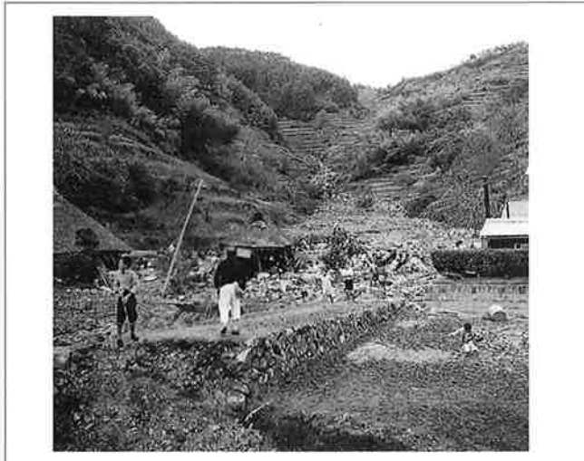
撮影日：S26.10.15 撮影場所：佐伯郡大竹町 撮影者：桜井技師 大竹町水源地のある薬師川の惨状（土石流）
