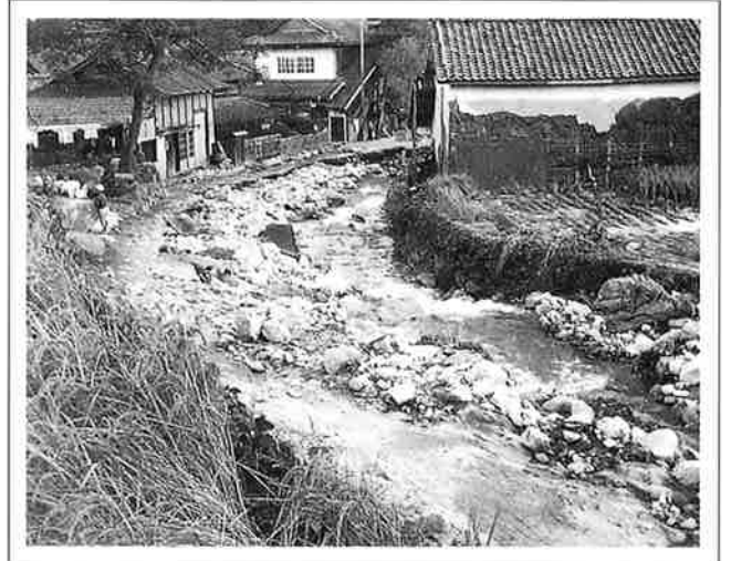
撮影日：S26.10.16 撮影場所：佐伯郡原村 撮影者：桜井技師 原村役場裏手の状況
