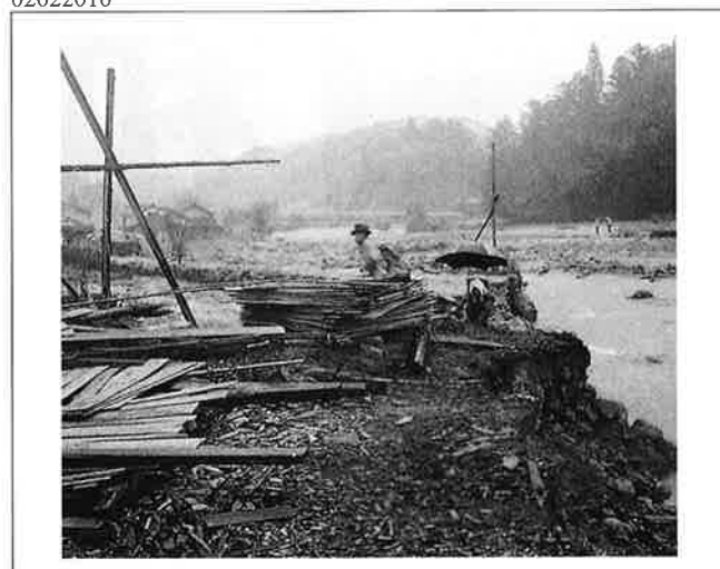
撮影日：S26.10.21 撮影場所：佐伯郡水内村 撮影者：川口技師 水内川大橋流失付近を上流より望む
