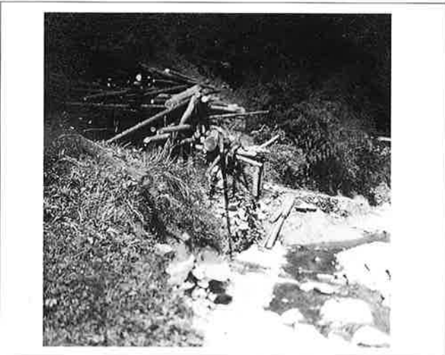
撮影日：S26.11.4 撮影場所：山県郡戸河内町 撮影者：坂田 （上流）左岸に積んだ木材 大部分は流失した
