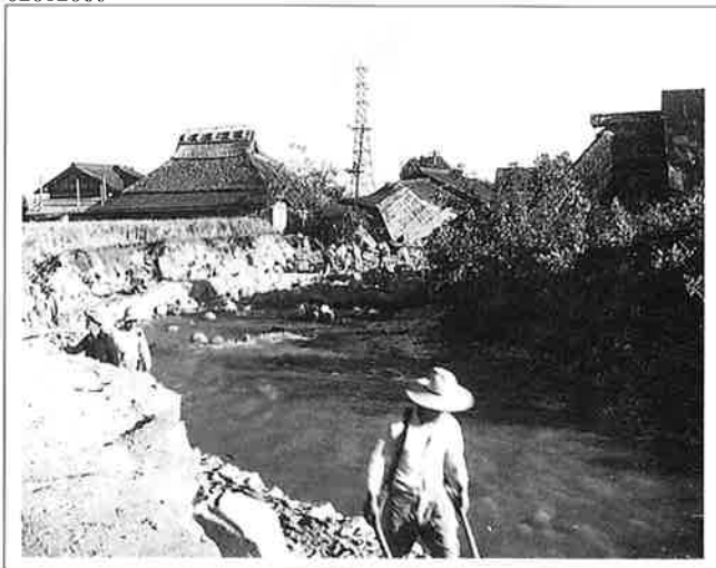
撮影日：S26.10.16 撮影場所：佐伯郡平良村 撮影者：桜井技師 速谷橋上付近
