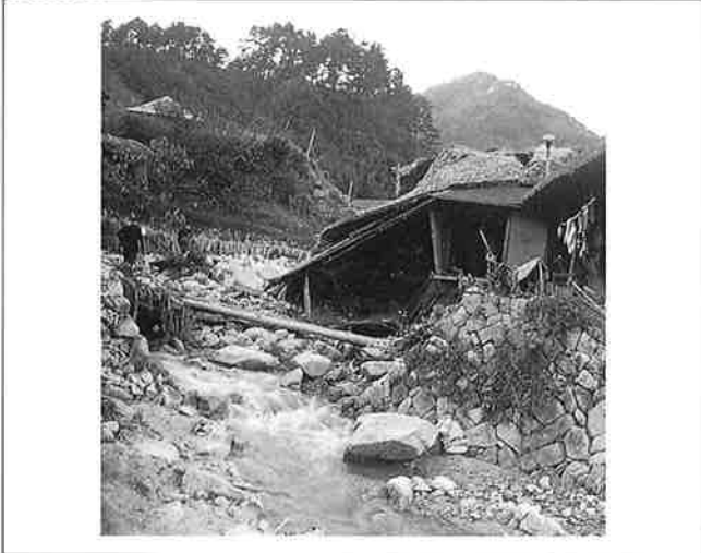
撮影日：S26.10.16 撮影場所：佐伯郡原村 撮影者：桜井技師 上流部の家屋倒壊状況
