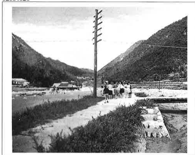
撮影日：不明 撮影場所：佐伯郡玖波町 撮影者：桜井技師 下流より上流に向う
