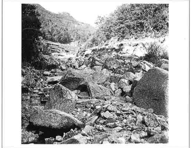
撮影日：S26.10 撮影場所：呉市 撮影者：高田技師 上流部の荒廃状況
