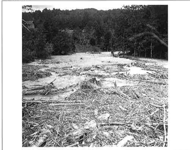
撮影日：S26.11.10 撮影場所：佐伯郡津田町 撮影者：高田技師 溜池に土砂、木材の流入堆積する状況（高等学校の横）
