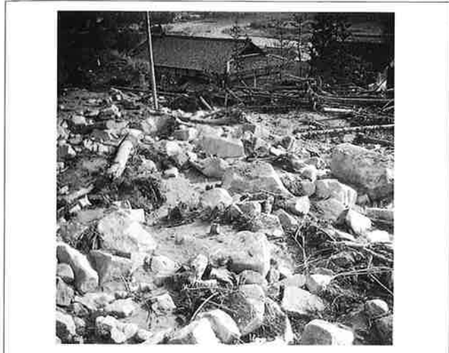
撮影日：S26.11.4 撮影場所：山県郡上殿村 撮影者：坂田 土石流や山崩が発生（地質は花崗岩） 上流は杉林のため木材の流出が多い 100m余隣りの地面谷川も同様の被害があった（青ヶ迫川上流に堰堤が2つあり、同様の条件の土地であったが被害はなかった）
