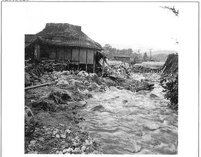
撮影日：S26.10.16 撮影場所：佐伯郡原村 撮影者：桜井技師 役場上付近の惨状（下流に向う）
