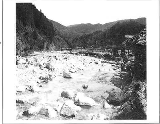
撮影日：S26.10.22 撮影場所：佐伯郡玖島村 撮影者：川口技師 中流部 家屋、護岸の被害状況を上流より望む 6
