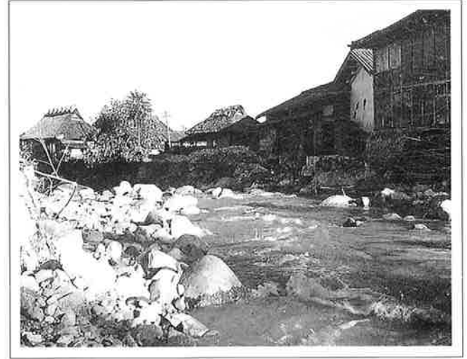
撮影日：S26.10.16 撮影場所：佐伯郡平良村 撮影者：桜井技師 小学校裏上流の護岸流失状況
