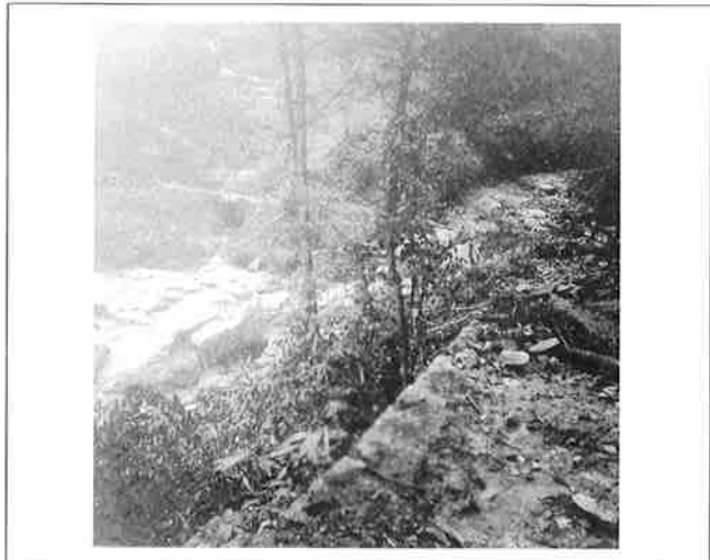
撮影日：S26.10.20 撮影場所：佐伯郡浅原村 撮影者：川口技師 市野川と市野谷川合流点付近にて堰堤予定ヶ所付近より上流を見る
