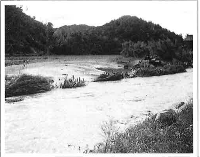
撮影日：S26.10.15 撮影場所：佐伯郡大野町 撮影者：桜井技師 中津岡川と永慶寺川本流との合流点上下流の欠壊
