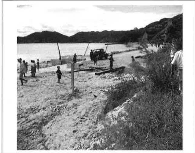
撮影日：不明 撮影場所：佐伯郡大野町 撮影者：桜井技師 国道二号線の洗堀状況
