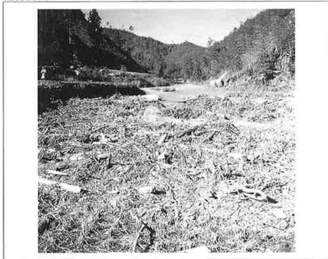
撮影日：S26.11 撮影場所：佐伯郡浅原村 撮影者：高田技師 下流 土砂流木流出状況
