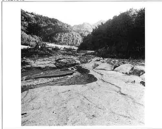
撮影日：S26.11.21 撮影場所：佐伯郡友和村 撮影者：高田技師 下より上へ
