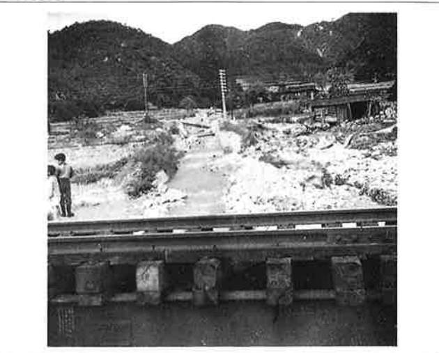
撮影日：不明 撮影場所：佐伯郡大野町 撮影者：桜井技師 山陽本線より上流被害状況を望む
