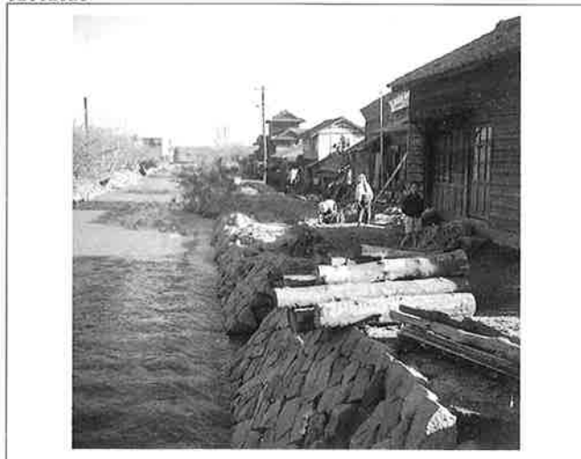
撮影日：S26.10.16 撮影場所：佐伯郡平良村 撮影者：桜井技師 役場下付近護岸崩壊状況
