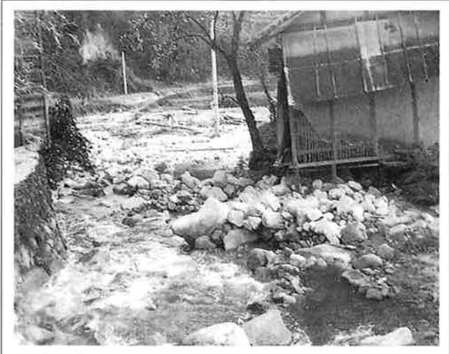
撮影日：S26.10.16 撮影場所：佐伯郡原村 撮影者：桜井技師 役場前下流の家屋倒壊
