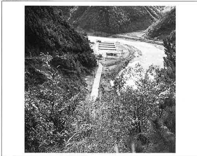
撮影日：S26.11.8 撮影場所：佐伯郡小方町防鹿 撮影者：高田技師 大竹・小方町の水源地の埋没状況
