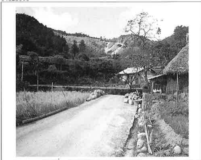
撮影日：S26.11.10 撮影場所：佐伯郡宮内村 撮影者：高田技師 崩壊状況
