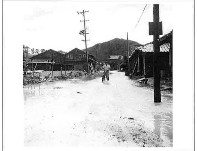
撮影日：S26.10.15 撮影場所：佐伯郡大竹町 撮影者：桜井技師 大竹町内の浸水状況
