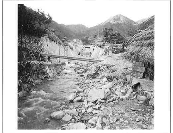
撮影日：S26.10.16 撮影場所：佐伯郡原村 撮影者：桜井技師 長野川中流部の被害状況
