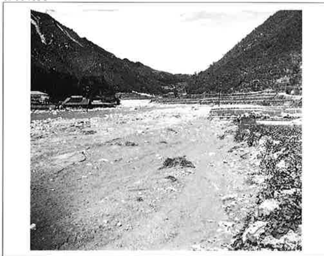
撮影日：不明 撮影場所：佐伯郡玖波町 撮影者：桜井技師 河原と化した下流部の状況
