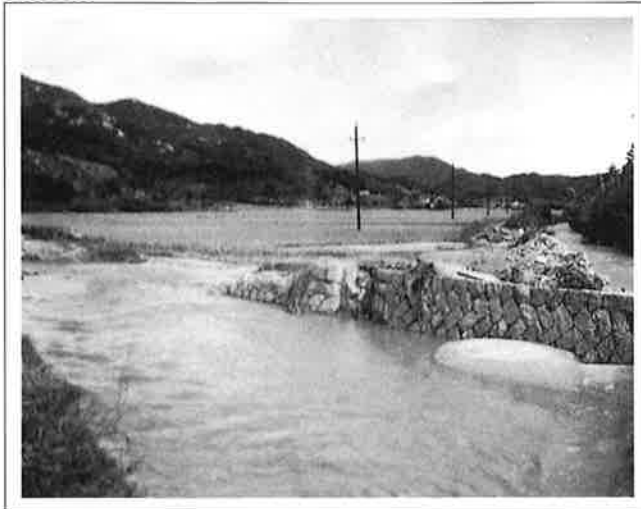
撮影日：S26.10.15 撮影場所：佐伯郡大野町 撮影者：桜井技師 中津岡川と永慶寺川本流との合流点上下流の欠壊
