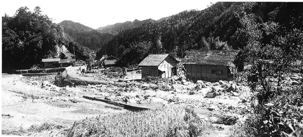
撮影日：S26.10.22 撮影場所：佐伯郡玖島村 撮影者：川口技師 岩川と大町川との合流点付近の惨状 A
