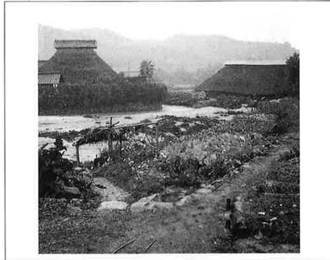
撮影日：S26.10.20 撮影場所：佐伯郡浅原村 撮影者：川口技師 下流部 土砂流出堆積状況 A
