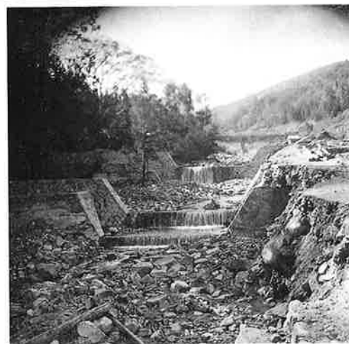
撮影日：S26.11.4 撮影場所：山県郡戸内町 撮影者：坂田 水管橋の下流 昭和26年施工災害復旧工事 垂壁下の護岸破損
