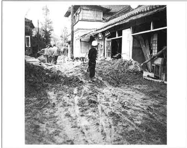
撮影日：S26.11 撮影場所：佐伯郡八幡村 撮影者：坂田 欠壊口上流の道路に堆積する土砂（寺田にて=地名） 手前は既に取除いている
