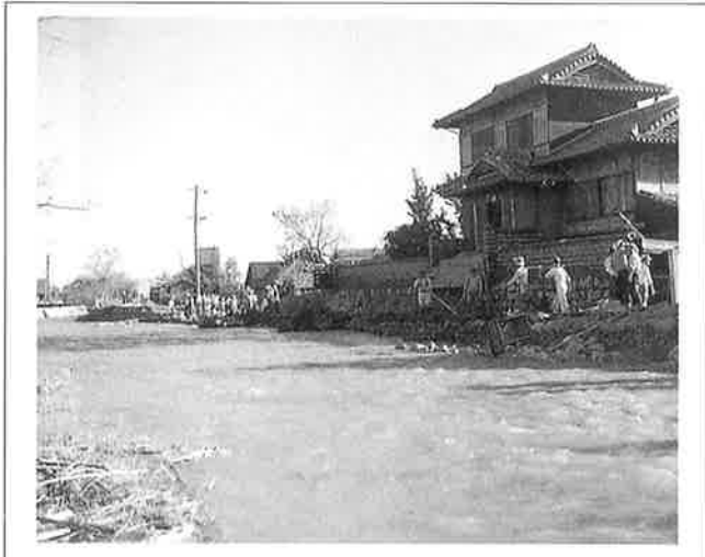
撮影日：S26.10.16 撮影場所：佐伯郡平良村 撮影者：桜井技師 役場下付近護岸崩壊 道路の応急復旧
