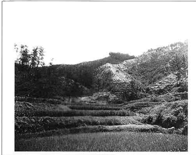
撮影日：不明 撮影場所：芦品郡中條村 撮影者：不明 昭和26年災害復旧工事 昭和26年度施工
