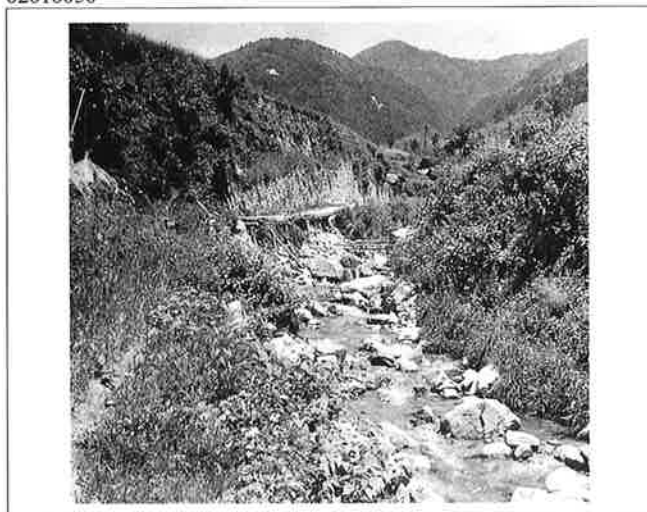
撮影日：S27.5 撮影場所：安佐郡亀山村 撮影者：高田技師
