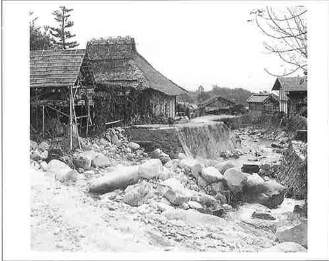
撮影日：S26.10.末 撮影場所：不明 撮影者：高田技師 被害状況
