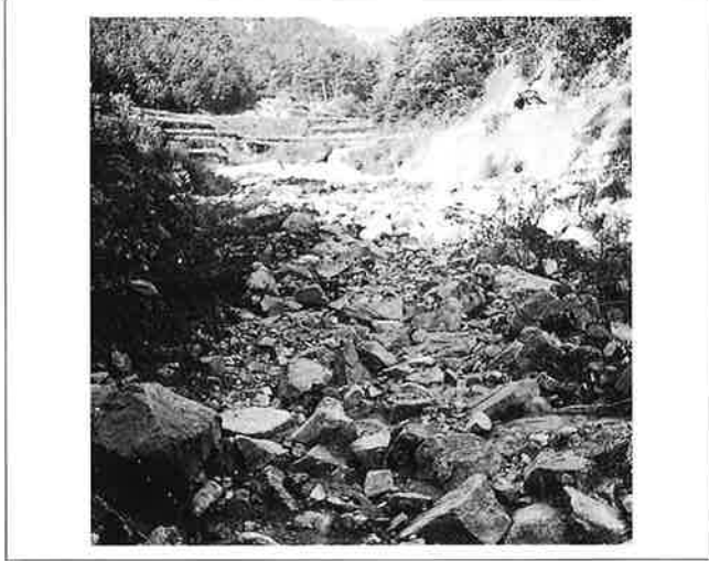
撮影日：S26.10 撮影場所：呉市 撮影者：高田技師 堰堤上流の荒廃状況
