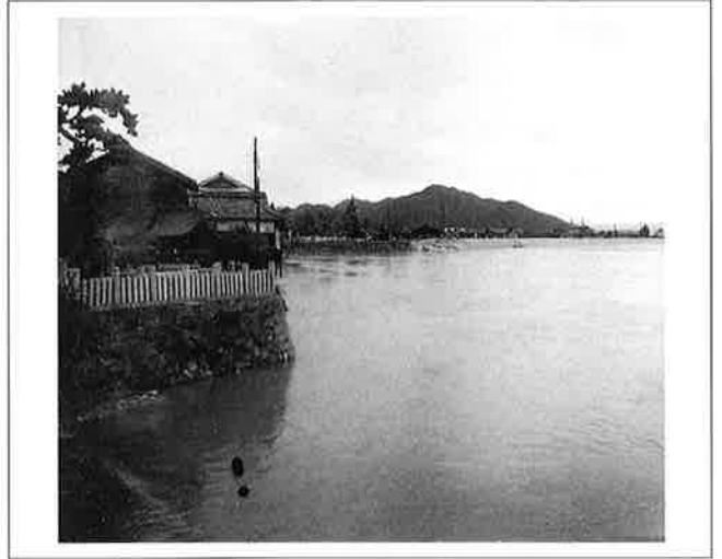
撮影日：S26.10.15 撮影場所：佐伯郡大竹町 撮影者：桜井技師 大和橋より下流堤の崩壊状況を望む
