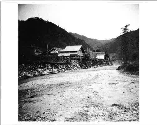
撮影日：S26.11.4 撮影場所：山県郡筒賀村 撮影者：坂田 上流に向って
