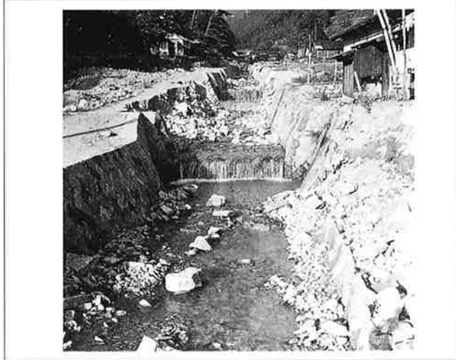
撮影日：S26.10 撮影場所：呉市 撮影者：高田技師 中流部 空積護岸欠壊状況
