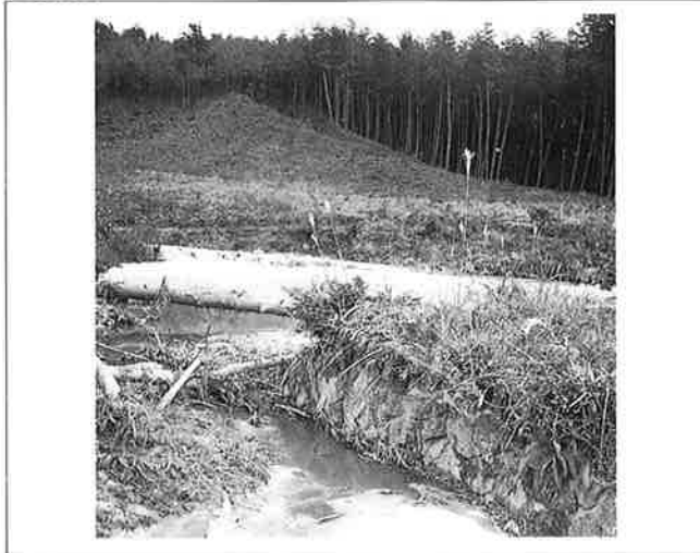
撮影日：S26.11.10 撮影場所：佐伯郡津田町 撮影者：高田技師 溜池に土砂堆積する状況
