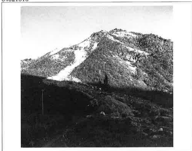
撮影日：S26.11.21 撮影場所：佐伯郡友和村 撮影者：高田技師 上流の崩壊状況
