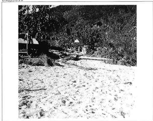
撮影日：S26.11.10 撮影場所：佐伯郡浅原村 撮影者：高田技師 大量の砂
