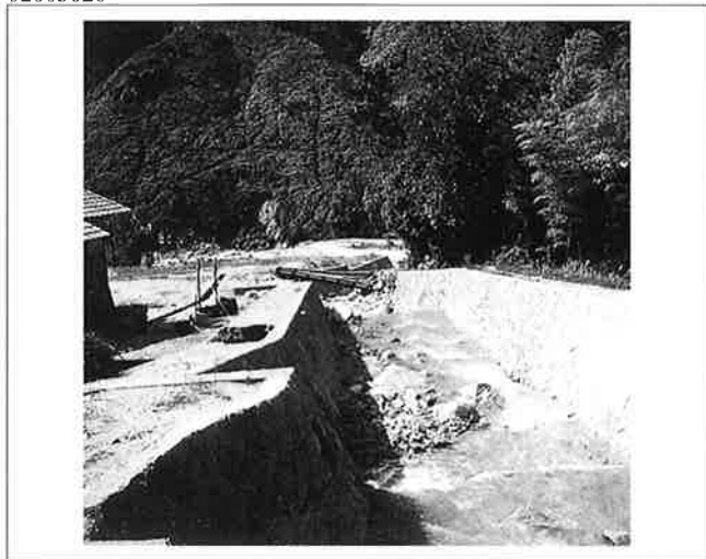
撮影日：不明 撮影場所：佐伯郡玖波町 撮影者：桜井技師 県道より下流に向う
