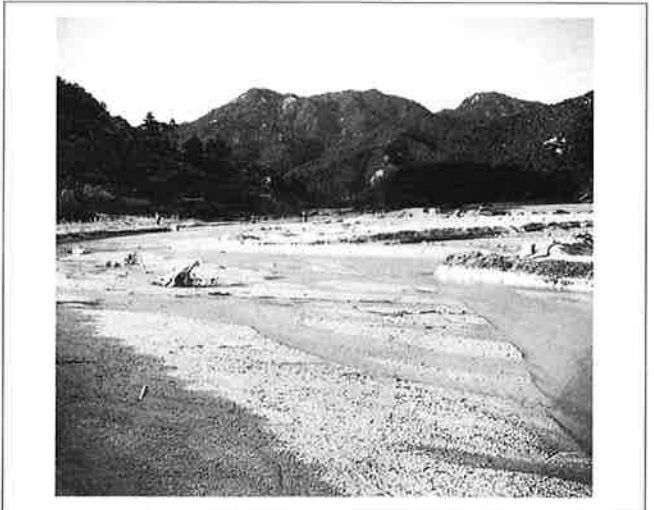
撮影日：S26.11 撮影場所：佐伯郡大野町 撮影者：坂口 中央に町営住宅（8戸）があったが今は流出しその形はない 下流より上流に向って
