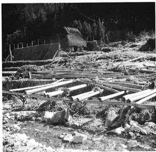
撮影日：S26.11.4 撮影場所：山県郡戸内町 撮影者：坂田 (上流) 河川上に出した木材 この上の木材は殆ど流失した 対岸(右岸)より土砂、木の根が流失している
