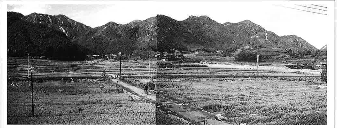
撮影日：不明 撮影場所：佐伯郡小方町 撮影者：桜井技師 大膳川被害地域の全景 山陽線の路床が洗い流され不通となる
