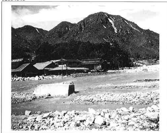
撮影日：不明 撮影場所：佐伯郡玖波町 撮影者：桜井技師 在来床止の一部を残し乱流の状況
