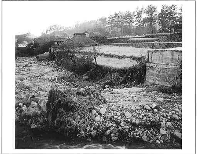
撮影日：S26.10.16 撮影場所：佐伯郡平良村 撮影者：桜井技師 平良村界神路橋の流失
