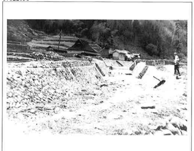
撮影日：S23年度 撮影場所：不明 撮影者：不明 田吹川砂防工事
