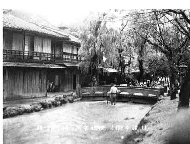
撮影日：S23.9.12 撮影場所：佐伯郡巖島町 撮影者：不明 水害状況
