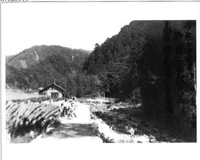
撮影日：S24年度 撮影場所：山県郡戸河内町字田吹 撮影者：不明 砂防工事施工ヶ所
