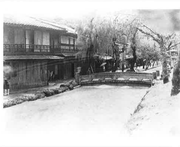
撮影日：S.23.9.12 撮影場所：佐伯郡巖島町 撮影者：不明 水害状況
