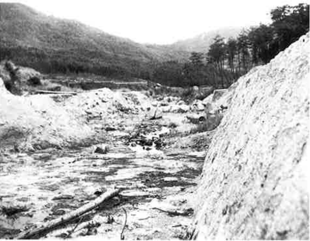
撮影日：不明 撮影場所：賀茂郡下黒瀬村大字津江字イラスケ 撮影者：不明
