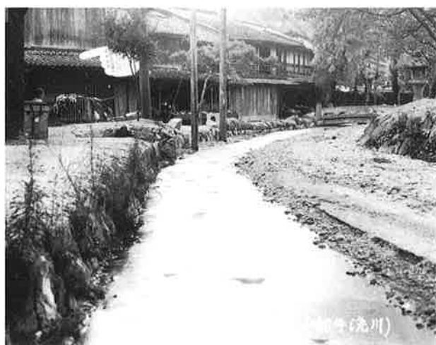
撮影日：S23.8.26 撮影場所：佐伯郡巖島町 撮影者：不明 災害状況（久保橋上流付近）
