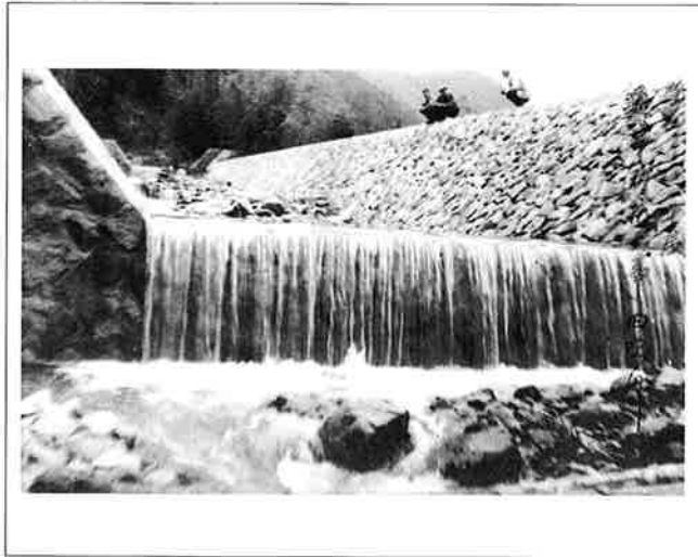
撮影日：S23年度 撮影場所：山県郡戸河内町 撮影者：不明 通常砂防工事
