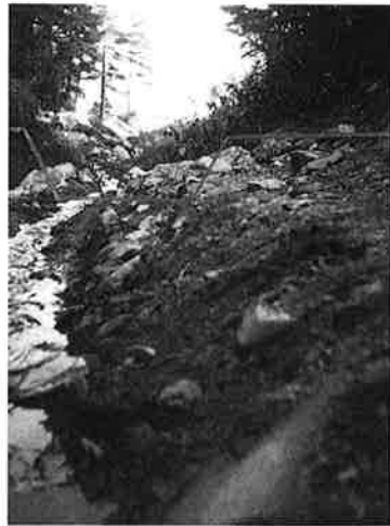
撮影日：不明 撮影場所：賀茂郡郷原村大字西長谷字一ノ松光山 撮影者：不明 堰堤施工箇所下流
