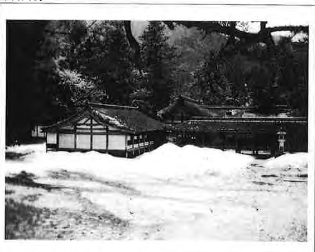
撮影日：不明 撮影場所：佐伯郡巖島町 撮影者：藤岡 勝 社務所付近の流入土砂
