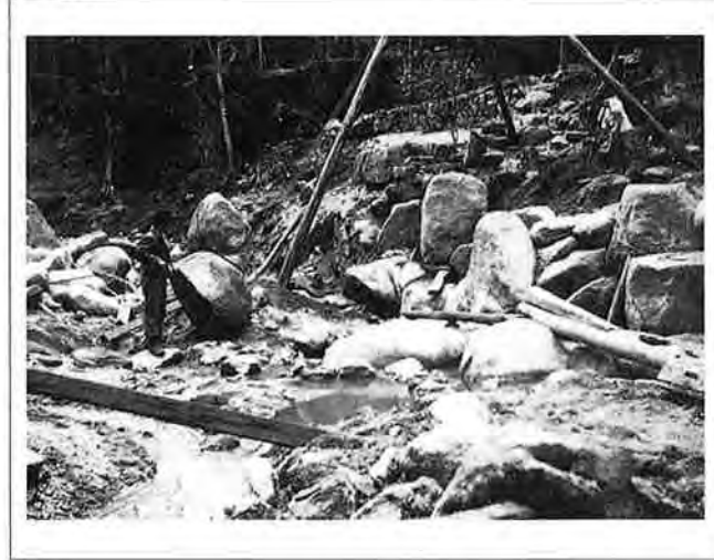
撮影日：S24.2.8 撮影場所：佐伯郡厳島町 撮影者：不明 紅葉橋上流護岸石組中
