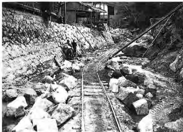
撮影日：S24.3.1 撮影場所：佐伯郡巖島町 撮影者：藤岡 勝 下流より上流を望む
