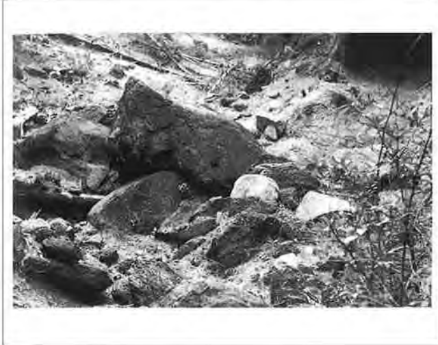
撮影日：不明 撮影場所：佐伯郡厳島町 撮影者：坂田静雄 区域内における山腹の崩壊状況（ケーブルカー建設工事の跡である）
