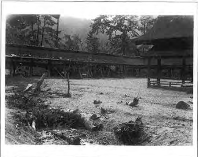
撮影日：不明 撮影場所：佐伯郡巖島町 撮影者：矢野 昭和20年9月17日の枕崎台風による被害
