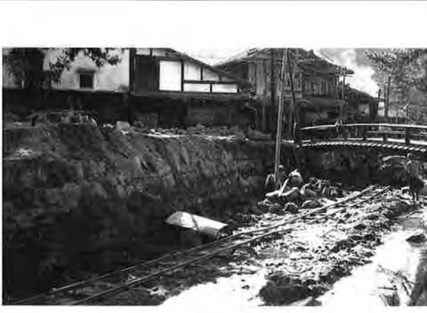
撮影日：S23.12 撮影場所：佐伯郡蔽島町 撮影者：藤岡 勝 校倉前護岸石積作業
