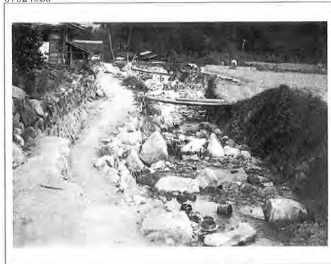
撮影日：S20年 撮影場所：安芸郡倉橋島村 撮影者：不明 昭和20年災害における被害状況 其の二
