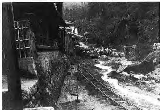
撮影日：S24.1 撮影場所：佐伯郡厳島町 撮影者：藤岡 勝 土砂搬出作業
