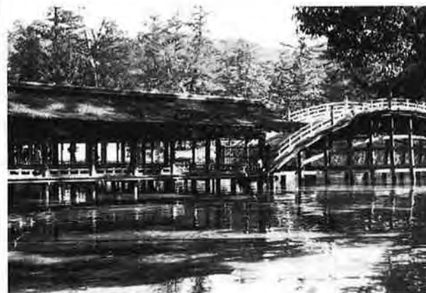
撮影日：S24.1 撮影場所：佐伯郡巖島町 撮影者：不明 完成した反橋西側付近
