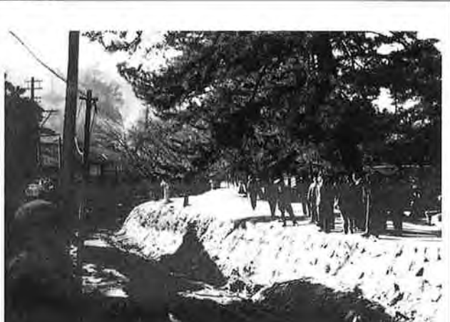
撮影日：S24.12 撮影場所：佐伯郡蔽島町 撮影者：藤岡 勝 掘進状況
