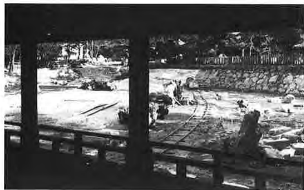
撮影日：S23.11 撮影場所：佐伯郡巖島町 撮影者：不明 反橋東側 旧天神社付近
