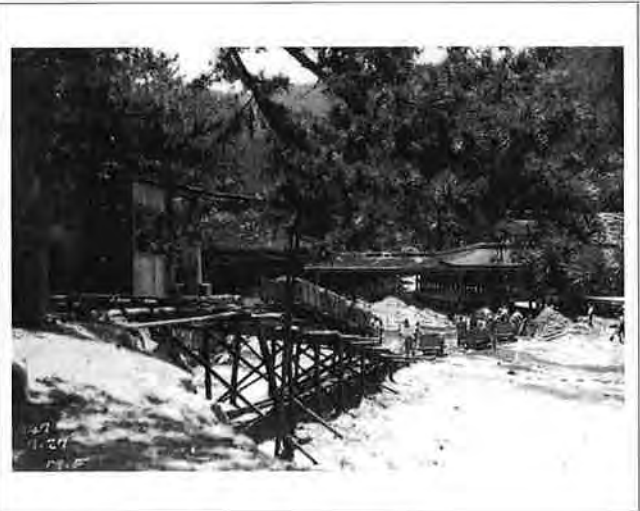
撮影日：S22.7.27 撮影場所：佐伯郡巖島町 撮影者：藤岡 勝 枱型よりトロッコ捲揚中 電動捲揚機15HP（第二期用足場）
