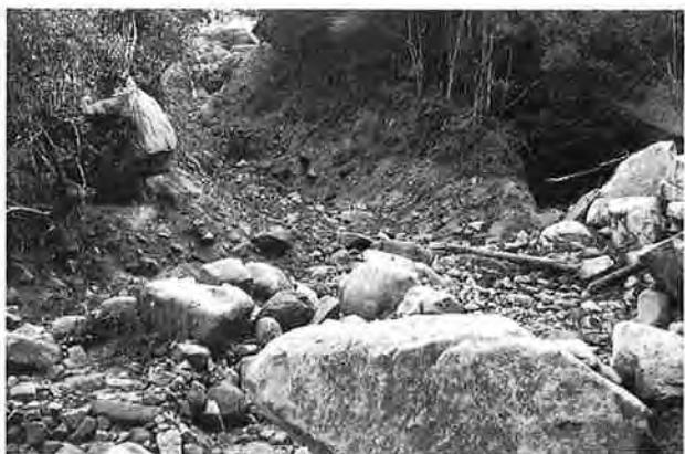
撮影日：不明 撮影場所：佐伯郡巖島町 撮影者：藤岡 勝 上流 左右両岸は良く茂った松樹林なるも崩壊は大きかった
