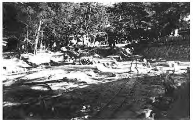
撮影日：S23.11 撮影場所：佐伯郡巖島町 撮影者：藤岡 勝 反橋東側 旧天神社付近
