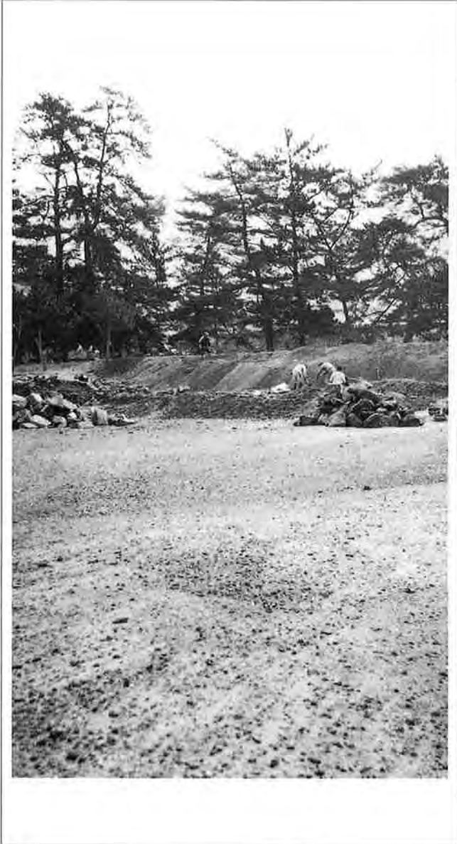
撮影日：S23.11 撮影場所：佐伯郡巖島町 撮影者：不明 防砂堤石積根石据付
