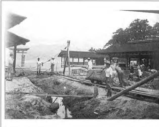
撮影日：不明 撮影場所：佐伯郡巖島町 撮影者：岩惣写真部 災害復旧工事（能舞台東側）
