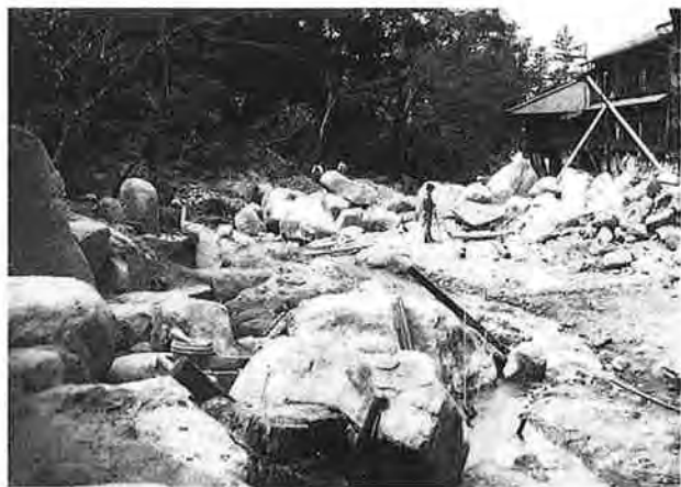
撮影日：S24.3.1 撮影場所：佐伯郡厳島町 撮影者：不明 上流より下流を望む 紅葉橋上より（石運搬）
