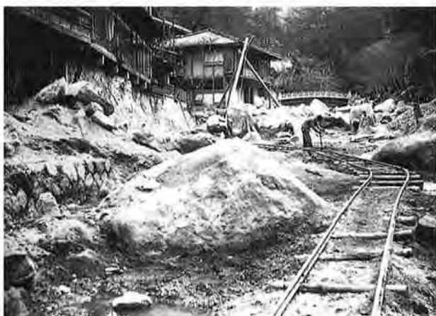
撮影日：S24.3.1 撮影場所：佐伯郡巖島町 撮影者：藤岡 勝 下流より上流を望む
