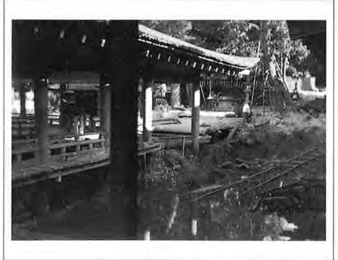
撮影日：S22.12 撮影場所：佐伯郡巖島町 撮影者：藤岡 勝 揚水橋付近の石整理作業
