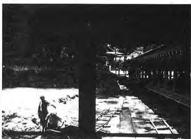
撮影日：S23.11 撮影場所：佐伯郡巖島町 撮影者：藤岡 勝 反橋西側 土砂搬出
