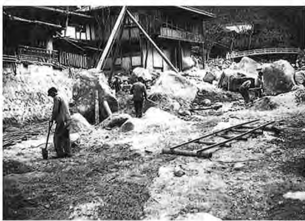
撮影日：S24.3.1 撮影場所：佐伯郡巖島町 撮影者：不明 下流より上流を望む（石運搬）
