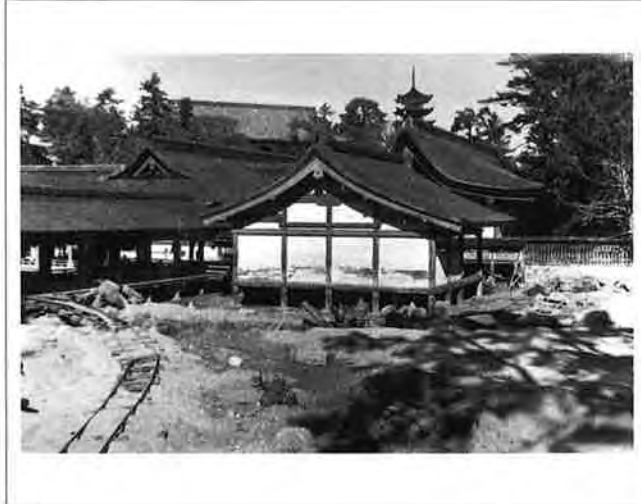
撮影日：S23 撮影場所：佐伯郡巖島町 撮影者：藤岡 勝 大黒社付近の進捗状況（軌道廻廊床板上より）
