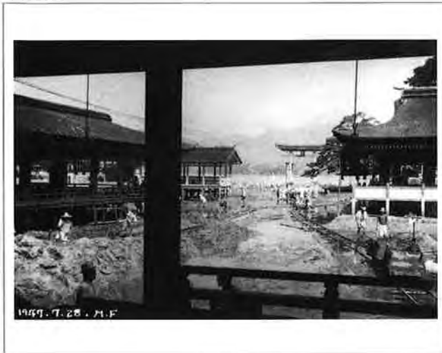
撮影日：S22.7.28 撮影場所：佐伯郡巖島町 撮影者：藤岡 勝 枱型掘削作業 はるのに御洲掘を望む
