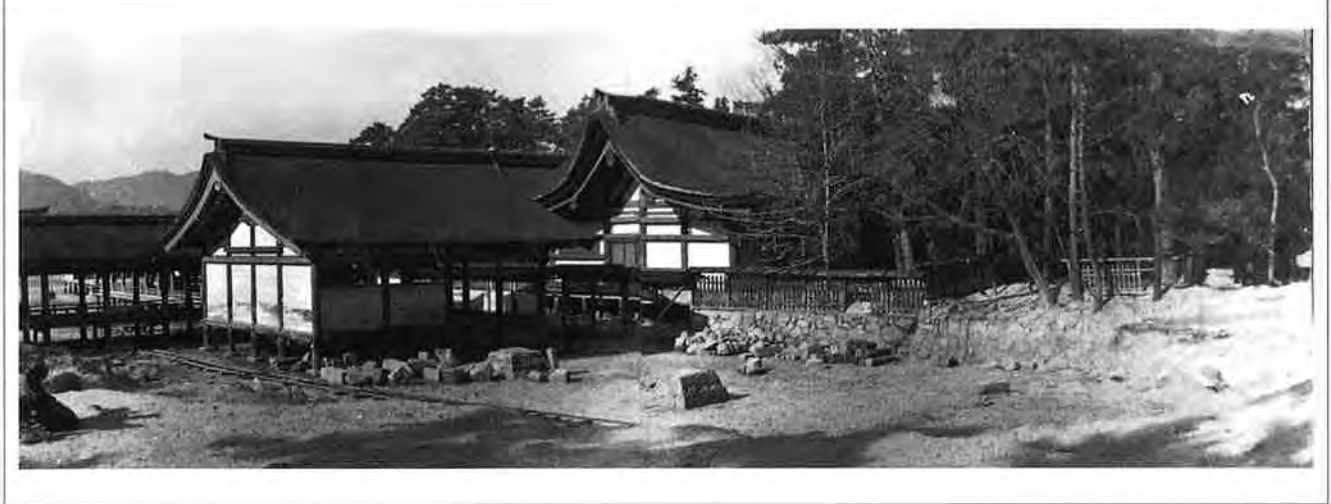
撮影日：S23.3 撮影場所：佐伯郡巖島町 撮影者：不明 大黒社付近 復旧進捗状況
