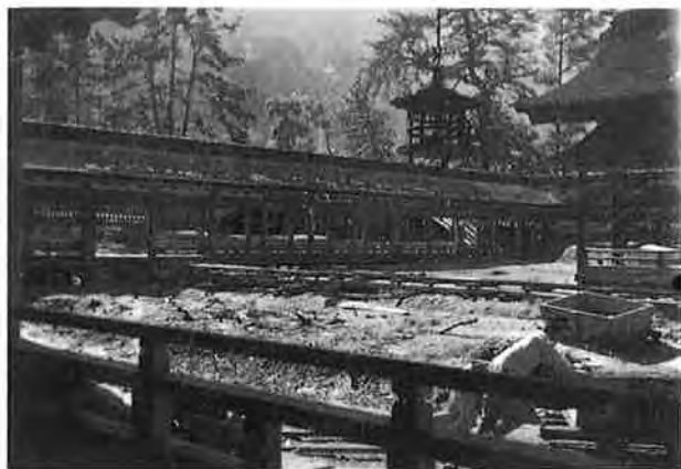
撮影日：S22.9.23 撮影場所：佐伯郡巖島町 撮影者：藤岡 勝 土砂運搬実況
