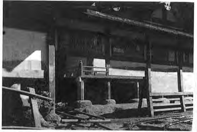
撮影日：S22.12 撮影場所：佐伯郡巖島町 撮影者：不明 完成した本殿西側
