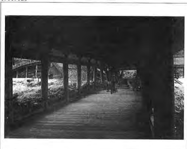
撮影日：不明 撮影場所：佐伯郡巖島町 撮影者：矢野 昭和20年9月17日の枕崎台風による被害
