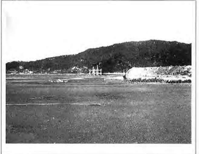
撮影日：S24.2.8 撮影場所：佐伯郡巖島町 撮影者：不明 防砂堤工事中
