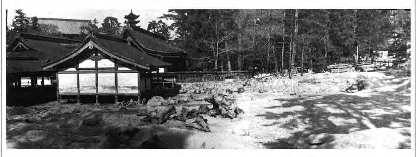
撮影日：S23.3 撮影場所：佐伯郡巖島町 撮影者：不明 大黒社付近 復旧進捗状況
