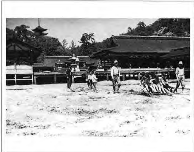
撮影日：不明 撮影場所：佐伯郡巖島町 撮影者：藤岡 勝 スクレパーによる土よせ作業
