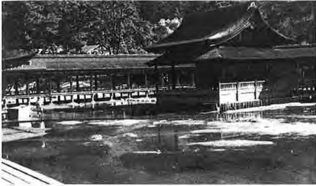
撮影日：S23.10 撮影場所：佐伯郡巖島町 撮影者：藤岡 勝 土砂搬出完了する能舞台付近
