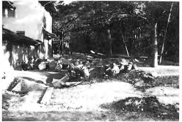
撮影日：S21.1 撮影場所：佐伯郡蔽島町 撮影者：藤岡 勝 災害状況（筋違橋上流）
