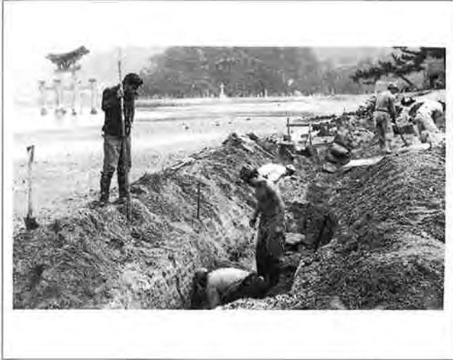
撮影日：S23.11 撮影場所：佐伯郡巖島町 撮影者：不明 防砂堤石積根石据付
