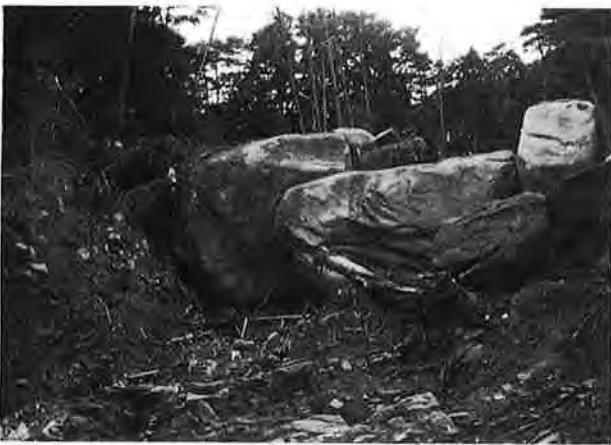
撮影日：S24.1.18 撮影場所：佐伯郡巖島町 撮影者：藤岡 勝 最上流大黒岩付近の災害
