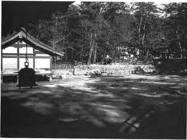
撮影日：S23 撮影場所：佐伯郡巖島町 撮影者：藤岡 勝 神社災害復旧工事（天神社・大黒社付近）
