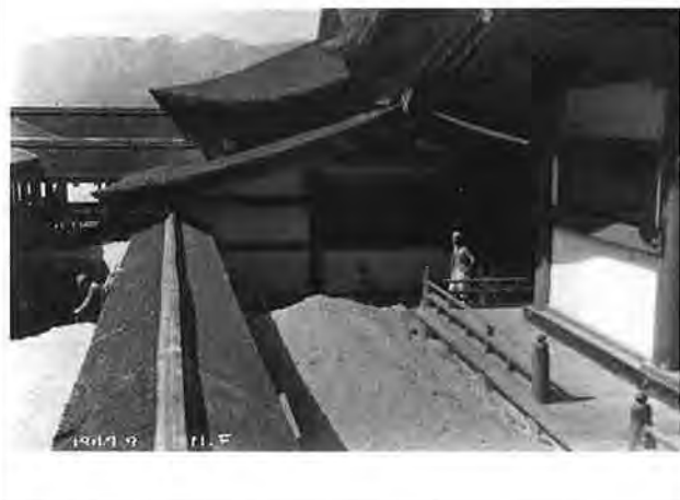
撮影日：S22.9.22 撮影場所：佐伯郡巖島町 撮影者：藤岡 勝 本殿及拜殿 掘進軌道敷設中（御本社西側）
