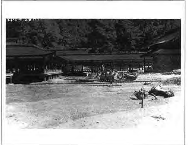
撮影日：S22,9,23 撮影場所：佐伯郡巖島町 撮影者：藤岡 勝
