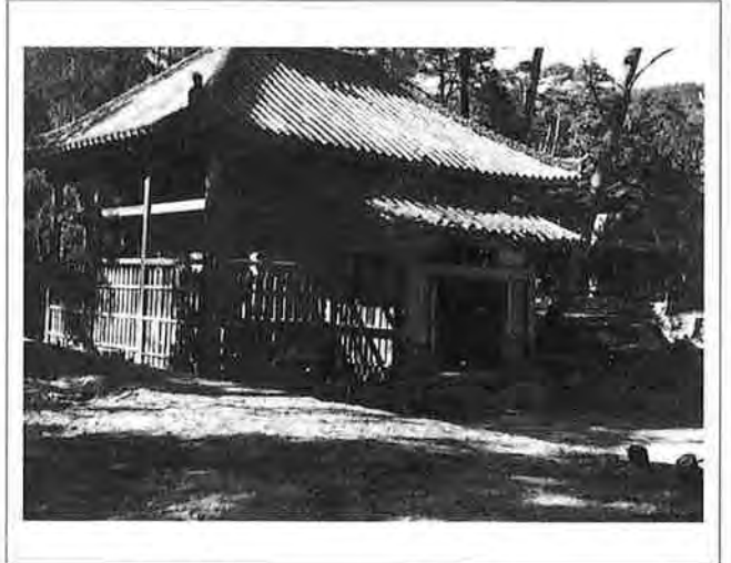
撮影日：不明 撮影場所：佐伯郡巖島町 撮影者：不明 校倉付近堀削完了
