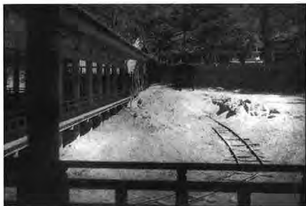
撮影日：S23.11 撮影場所：佐伯郡巖島町 撮影者：不明 反橋西側 土砂搬出
