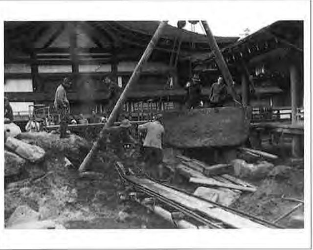
撮影日：不明 撮影場所：佐伯郡巖島町 撮影者：藤岡 勝 大鏡手洗鉢修復作業（天正廿年 [1592年] 製作）
