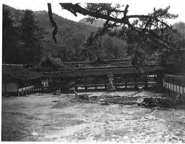
撮影日：不明 撮影場所：佐伯郡巖島町 撮影者：藤岡 勝 社務所付近 土砂搬出
