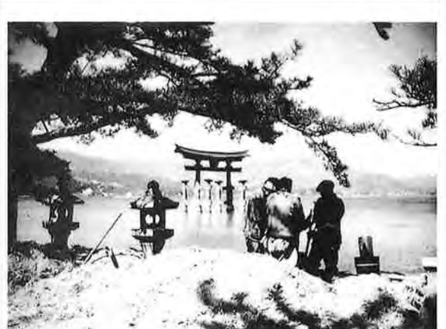
撮影日：不明 撮影場所：佐伯郡巖島町 撮影者：不明 西松原燈籠建立修理作業
