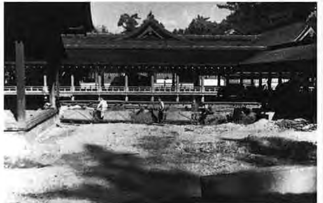
撮影日：S23.2 撮影場所：佐伯郡巖島町 撮影者：藤岡 勝 能舞台付近 土砂搬出作業
