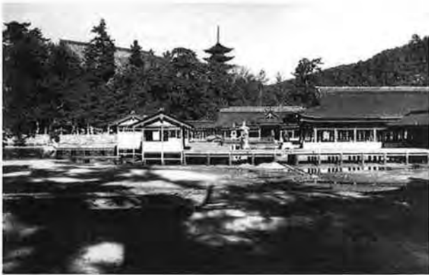
撮影日：S23.12 撮影場所：佐伯郡巖島町 撮影者：藤岡 勝 平舞台付近 土砂搬出
