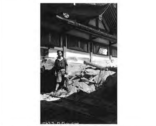
撮影日：S22.9.22 撮影場所：佐伯郡巖島町 撮影者：藤岡 勝 「トロッコ」の運行を見守る 本殿西側掘進線路に立てる己斐二郎
