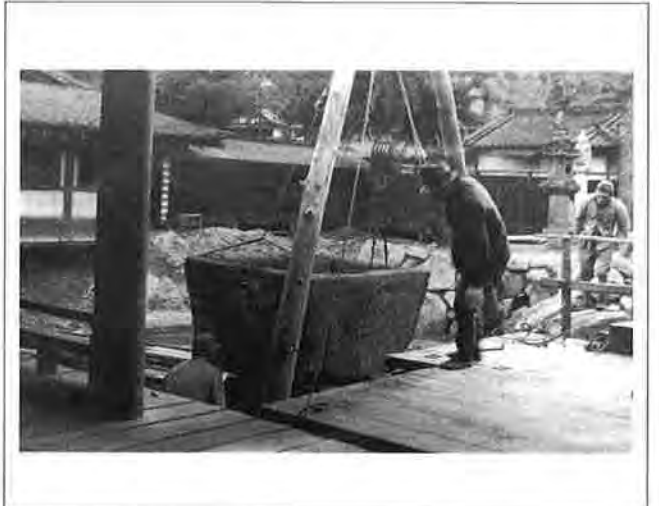
撮影日：不明 撮影場所：佐伯郡巖島町 撮影者：藤岡 勝 大鏡手洗鉢修復作業（天正廿年 [1592年] 製作）
