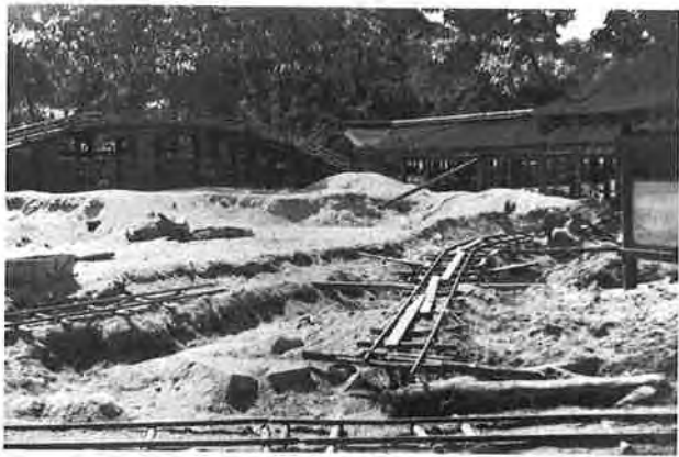
撮影日：S22.9.末 撮影場所：佐伯郡巖島町 撮影者：藤岡 勝 大黒社付近実況
