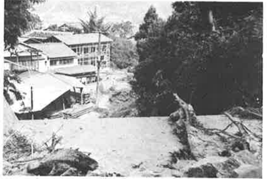
写2 和庄川(土石流のダム扞止)
