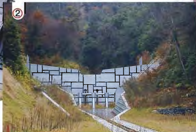
土石流による被害を防止するために、谷出口に砂防堰堤を建設した。
