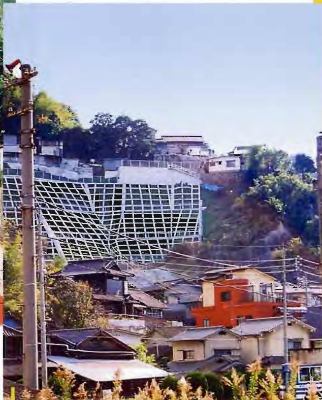
がけ崩れを防止するため、斜面に法枠を建設した。
