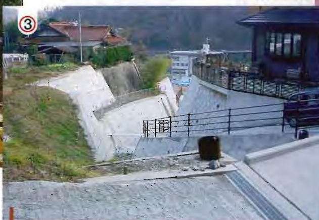
洪水を安全に流下させるため、護岸工を建設した。
