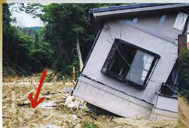
土石流の直撃をうけ、2階建ての家屋が倒壊した。
