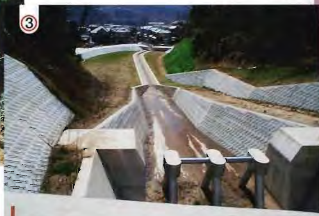
土砂の流下を防ぐために、砂防堰堤下流に沈砂地を建設した。
