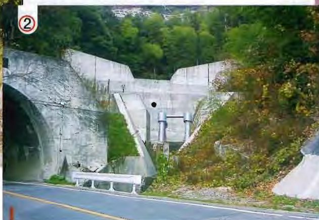
土石流による被害を防止するために、谷出口に砂防堰堤を建設した。
