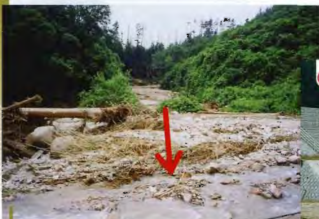
流下した土砂は巨礫よりも細粒土砂が多く含まれている。
