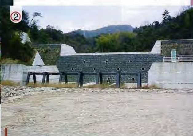
現地発生土を有効に活用し、ダブルウォール砂防堰堤を建設した。
