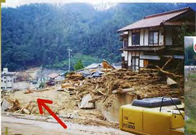
民家周辺には、土砂や流木が堆積している。
