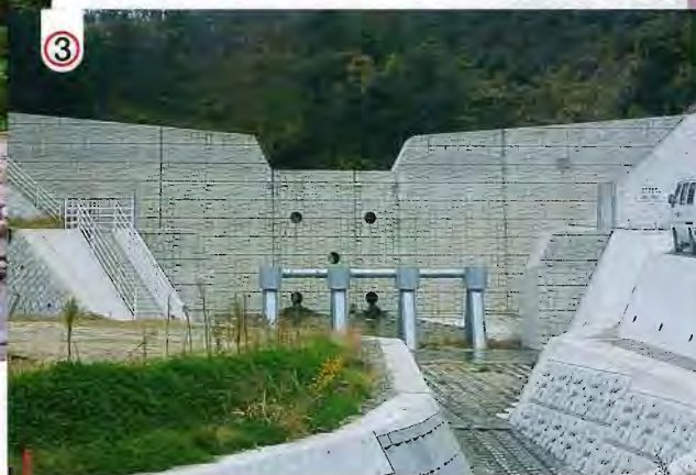
土石流による被害を防止するために、砂防堰堤を建設した。
