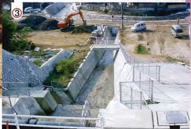
洪水を安全に流下させるため、護岸工を建設した。
