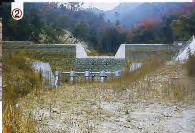
現地発生土を有効に活用し、ダブルウォール砂防堰堤を建設した。
