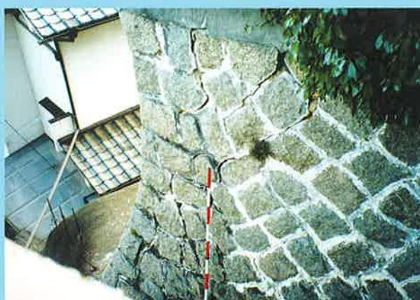
【写真2-3】擁壁変状事例（クラック）
