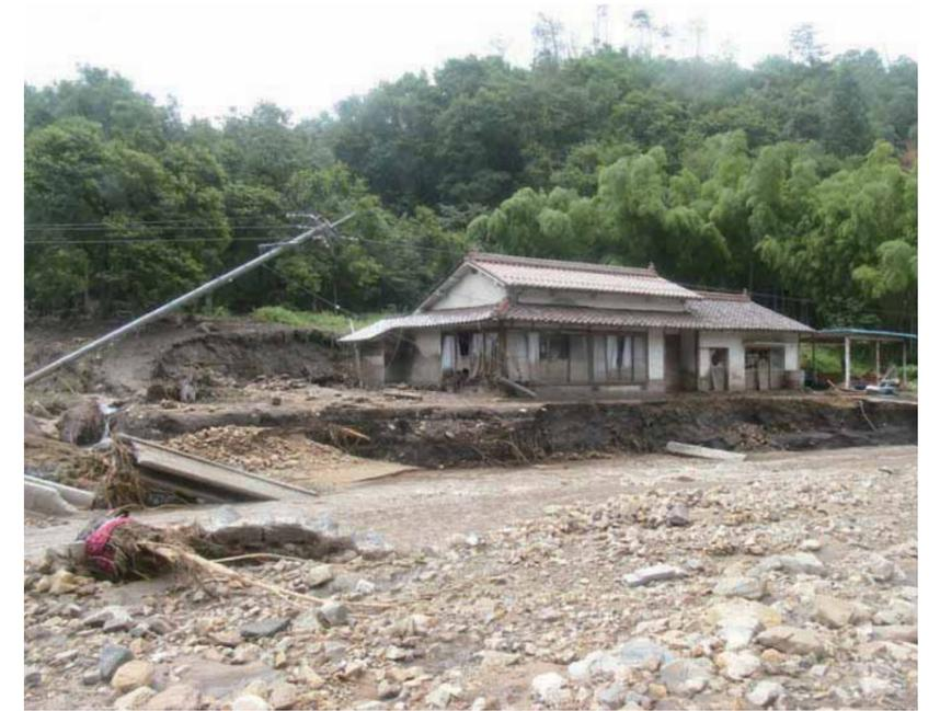
②土石流による護岸と家屋の被害
