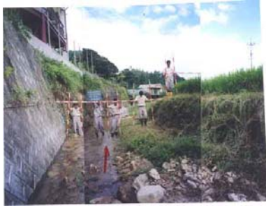
上流・下流方向写真
