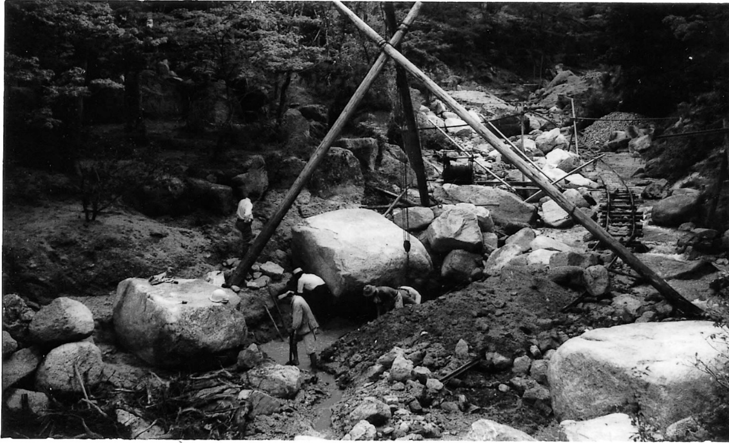
紅葉橋上流の流路工の工事状況（※1）
