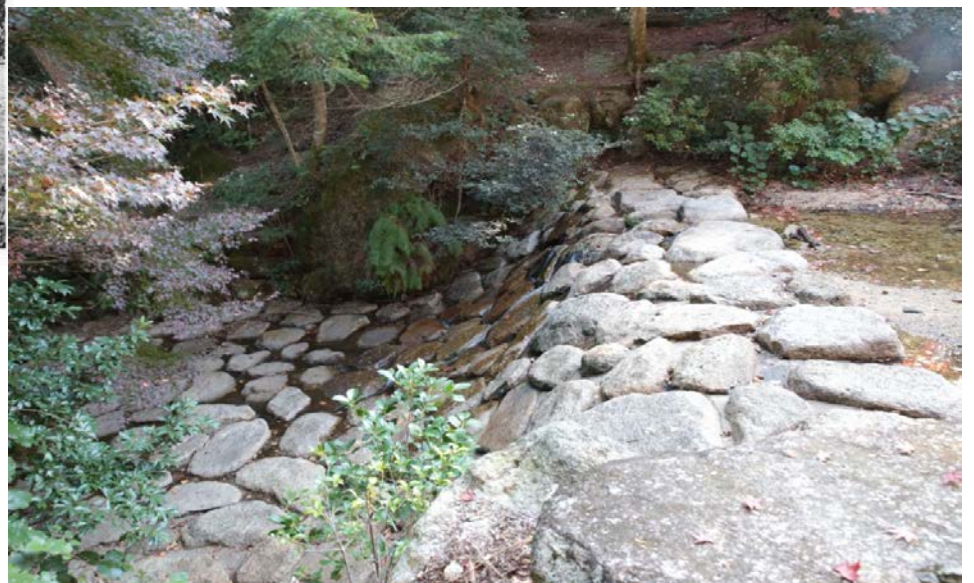
現在の第五号堰堤
