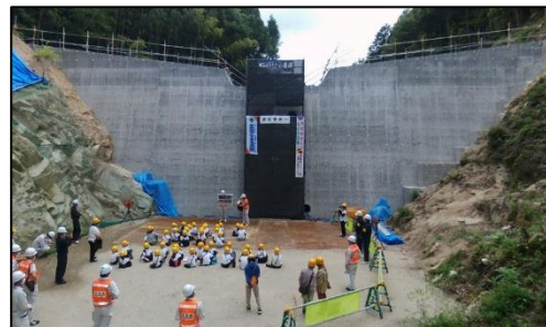
令和3年3月に完成した砂防堰堤の現場見学
