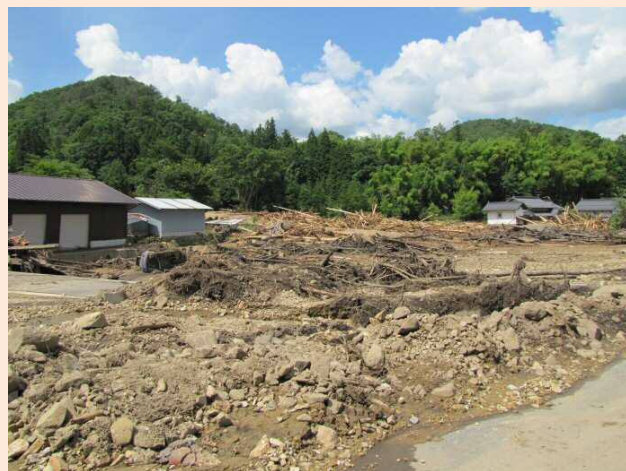
大戸地区被害の状況【1】 提供:庄原市北自治振興区
