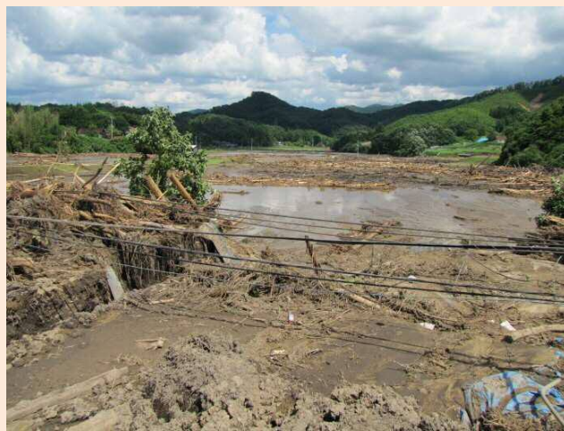
大戸地区被害の状況【3】 提供:庄原市北自治振興区
