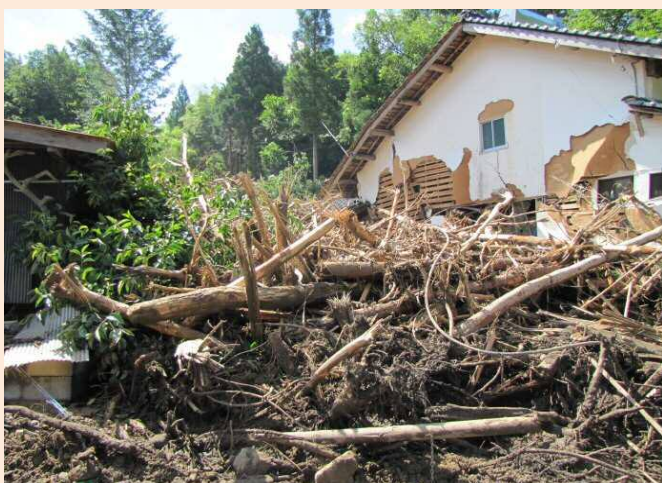
大津恵地区被害の状況【1】 提供:庄原市北自治振興区
