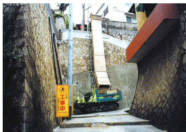
■簡易シュートによる土砂搬出
