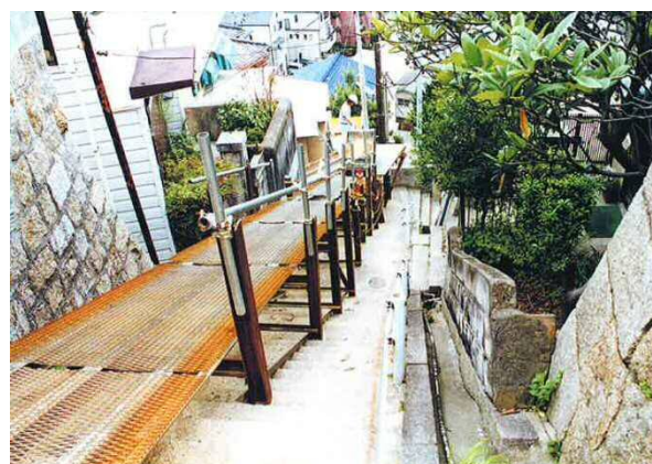
■簡易シュートによる土砂搬出
