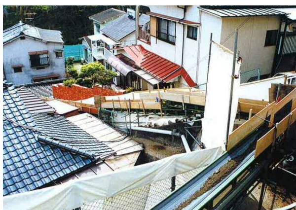
■ベルトコンベアによる土砂搬出
