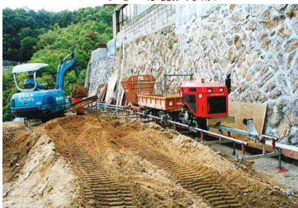
■ベルトコンベアによる土砂搬出
