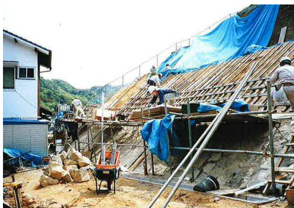
■モノレールによる土砂搬出状況
