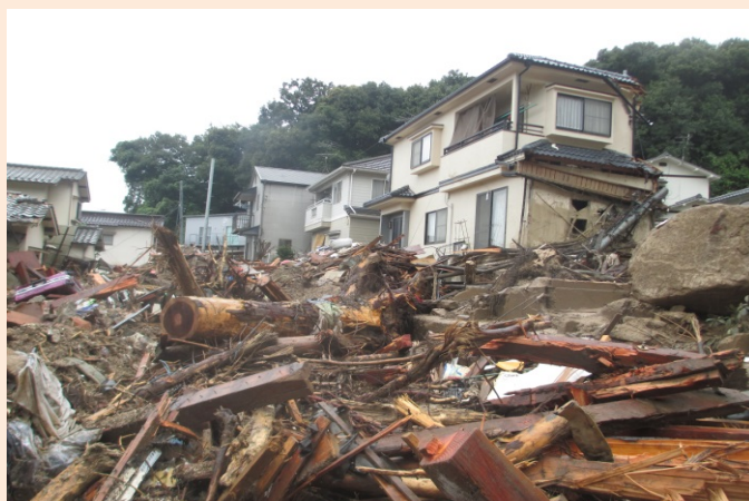
被害の状況【4】 提供:八敷福祉会
