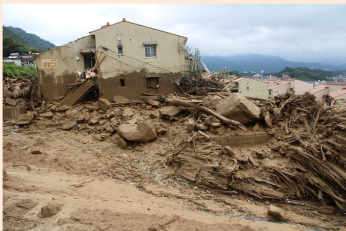
被害の状況【2】 提供:小原山町内会
