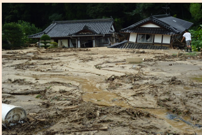
被害の状況【2】 提供:八敷福祉会
