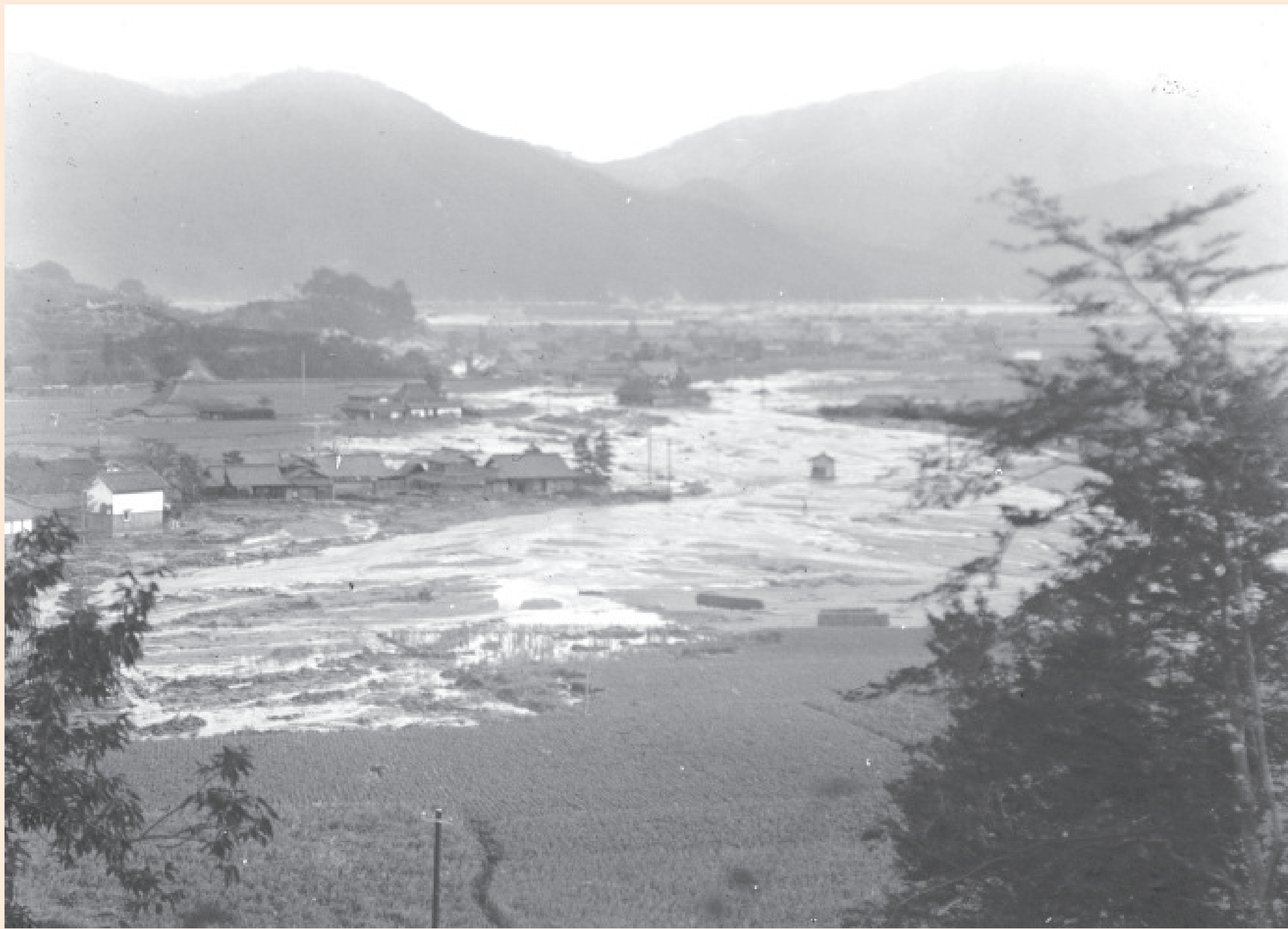
被害の状況【4】 提供: 廿日市市
