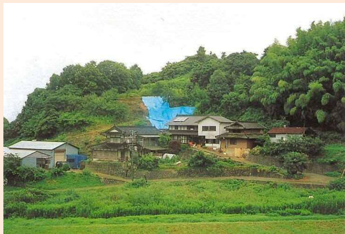
1. 崩壊発生斜面全景
