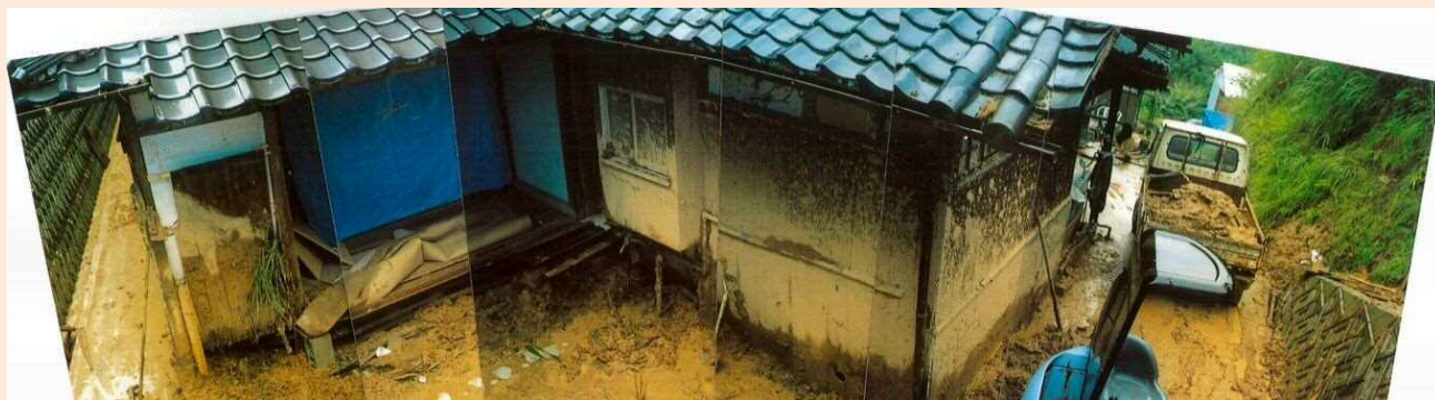
4. 土砂が流入した被災人家
