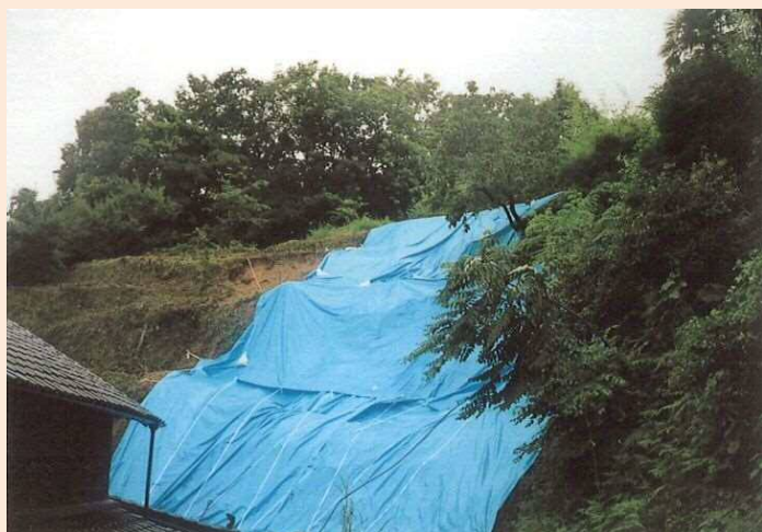
2. 崩壊斜面状況
