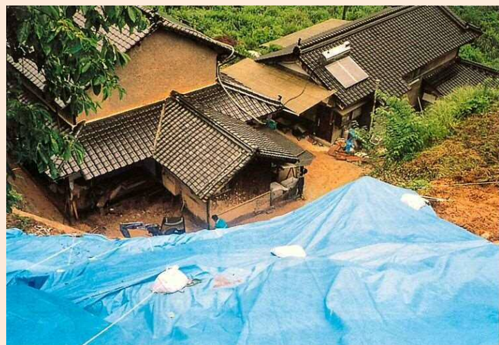
3. 崩壊斜面上部より見た被災状況
