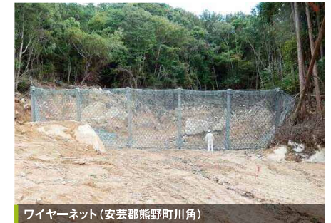
ワイヤーネット（安芸郡熊野町川角）
