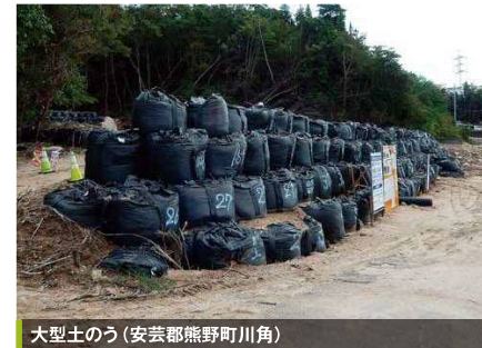
大型土のう（安芸郡熊野町川角）
