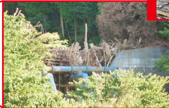
下流からみた流木の捕捉状況
