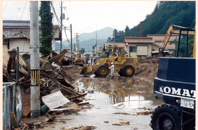
6. 被災時の国道186号線の様子
