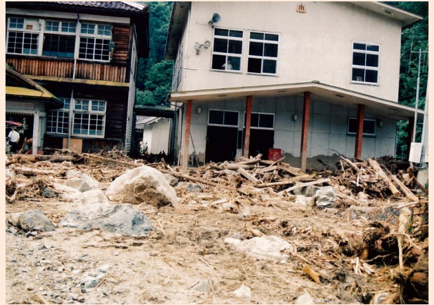
2. 被害の状況⑦(蛇の谷川)
