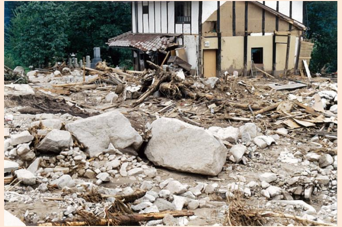
4. 土石流により被災した家屋
