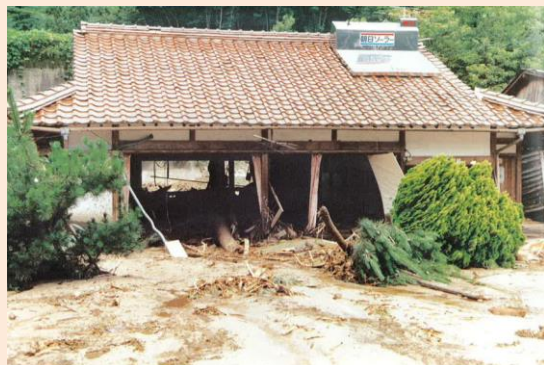
5. 土石流により被災した家屋
