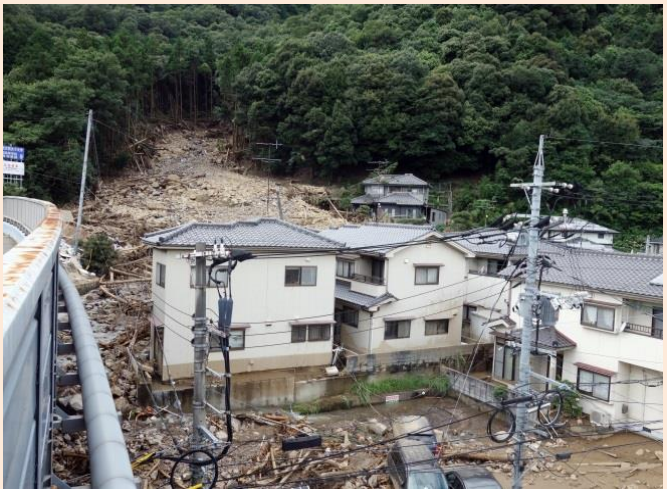
被害の状況【5】 提供:復興交流館 モンドラゴン
