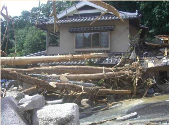
被害の状況【1】 提供:復興交流館 モンドラゴン
