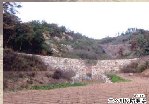
堂々川砂防堰堤
