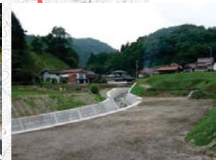
河川災害関連事業 一般河川大津恵川 L=1.38km
