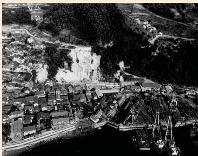
7. 被害の状況(警固屋5丁目)
