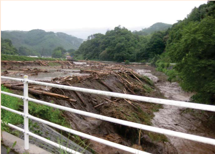
被害の状況【1】 提供:庄原市北自治振興区
