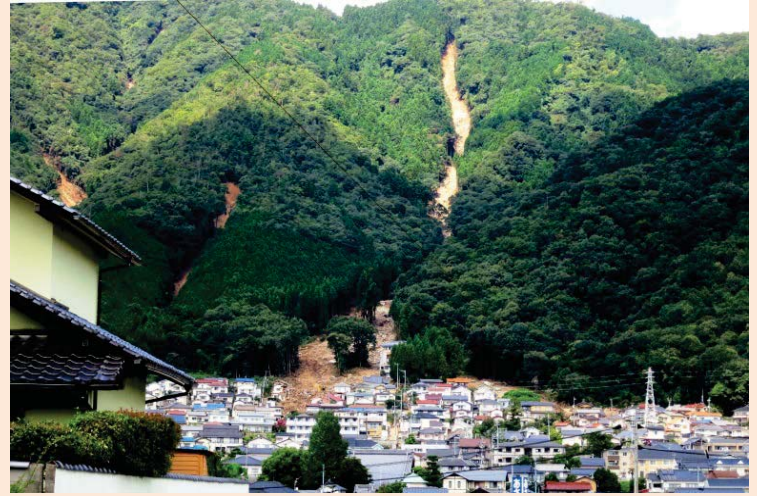
八木4丁目被害の状況 提供:八木自主防災会
