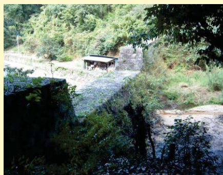
昭和25年建設: 堤高H=11.5m, 堤長L=50.0m
