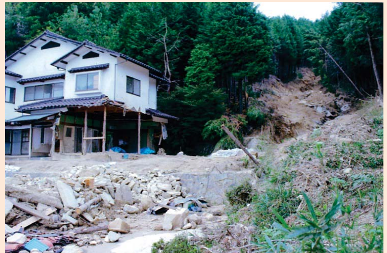
被害の状況【4】 提供:新建自治会
