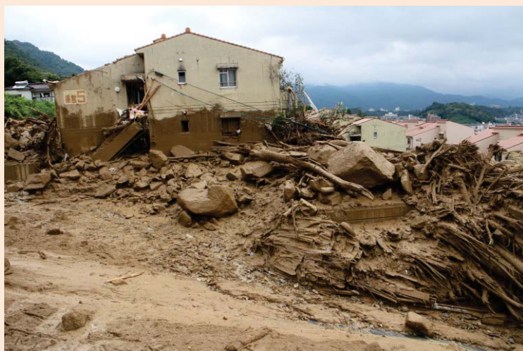
被害の状況【2】 提供:小原山町内会
