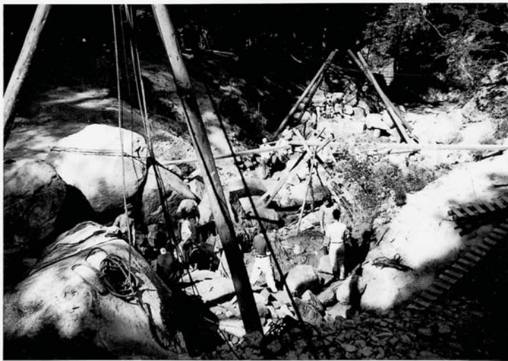
巨石をかぐらさんで動かした床止工の施工
