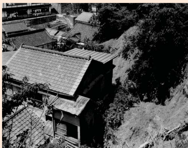
9. 被害の状況(宮原通1丁目)
