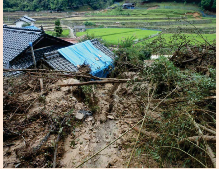
大林地区の被害の状況【2】
