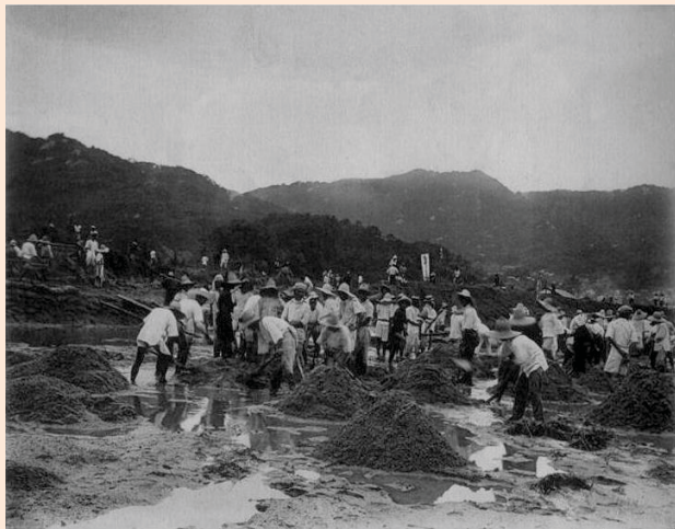
2. 茅原付近応急工事
