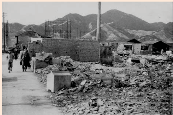
4. 呉駅前の通りより両城方面を望む
