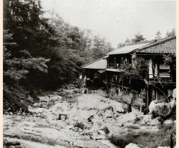
岩惣付近の被害状況
