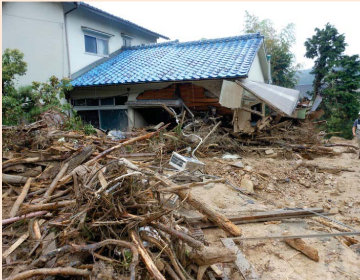
大林地区の被害の状況【3】
