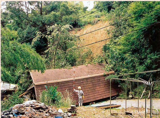
1. 崩壊斜面全体
