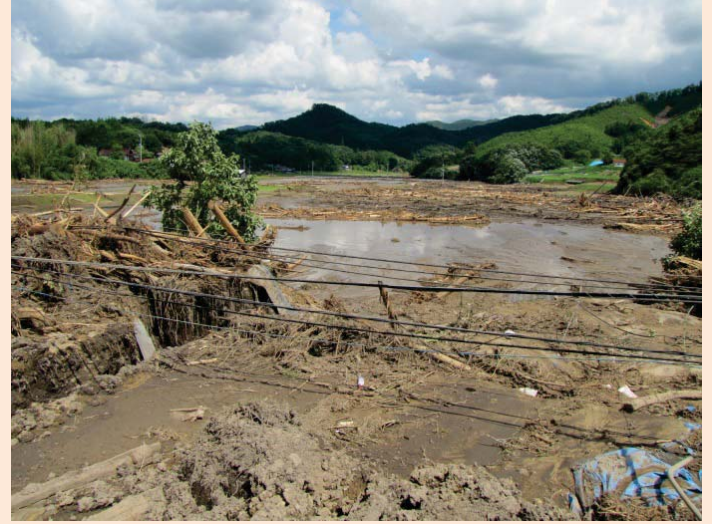
大戸地区被害の状況【3】 提供:庄原市北自治振興区
