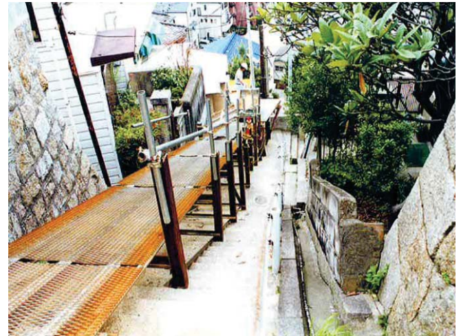
■簡易シュートによる土砂搬出
