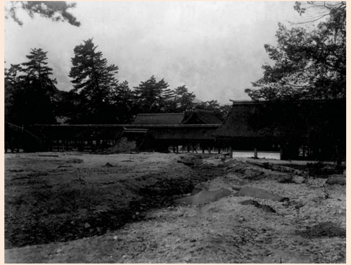
巖島神社の被災状況
