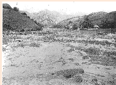
小屋浦の被害状況
