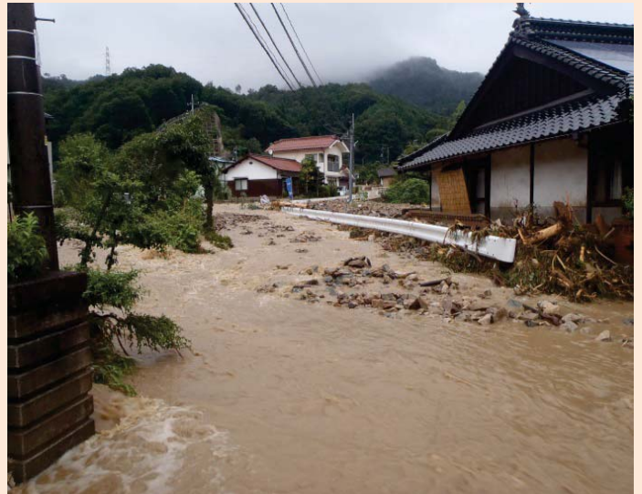
大林地区の被害の状況【4】
