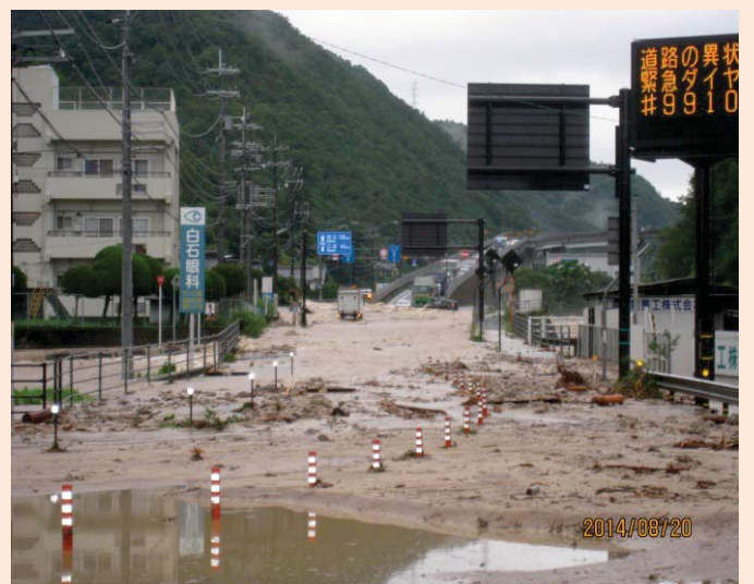
国道54号の被災状況
