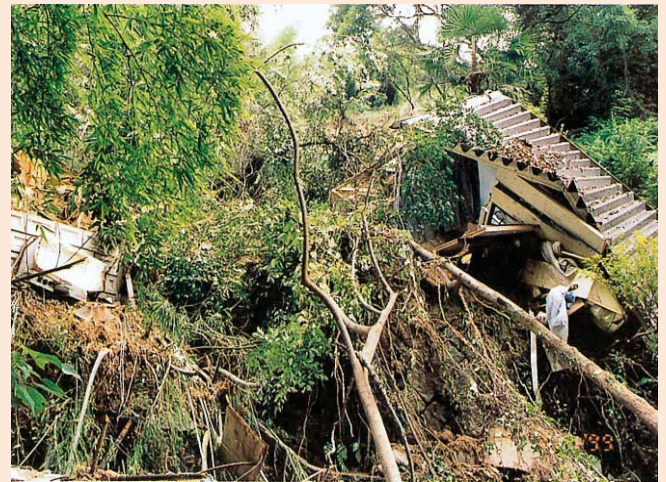
4. 土砂により押し潰された被災建物
