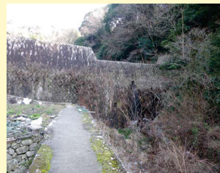
昭和25年建設: 堤高H=11.5m, 堤長L=50.0m
