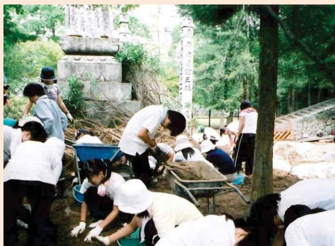
大聖院での復旧作業の様子 撮影: 亀井勝之氏
