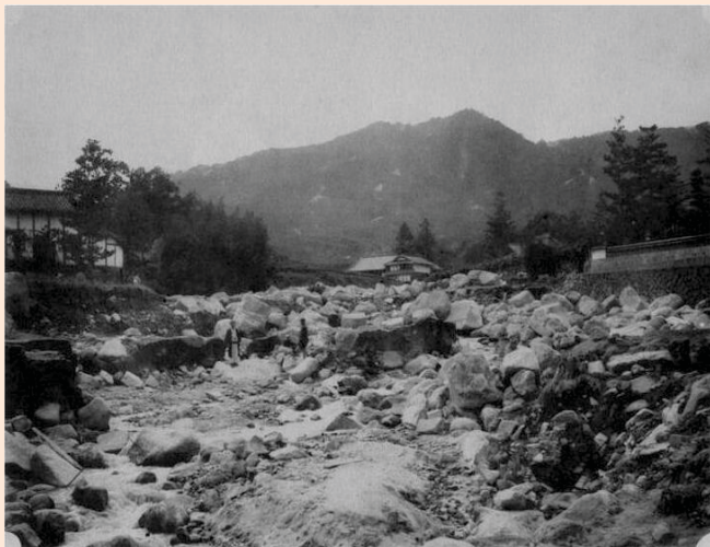
7. 被害の状況 ⑤(岡田橋付近)
