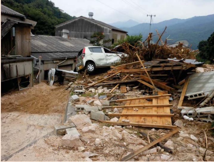
大林地区の被害の状況【1】
