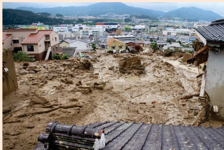
被害の状況【3】 提供:小原山町内会
