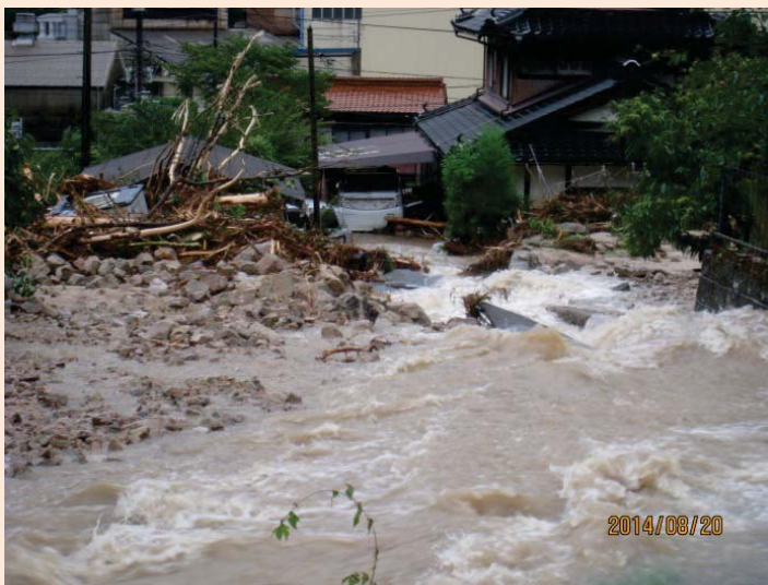
大林地区の被害の状況【5】
