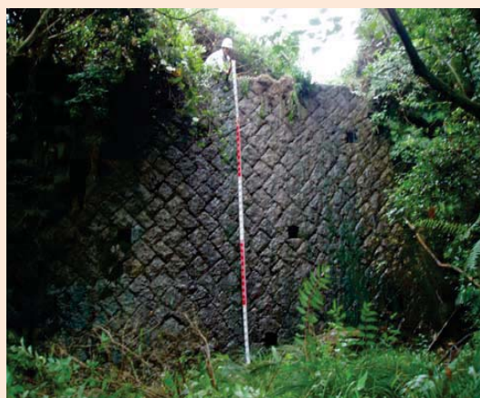
昭和12年頃建設 堤高H=6.5m, 堤長L=25.0m
