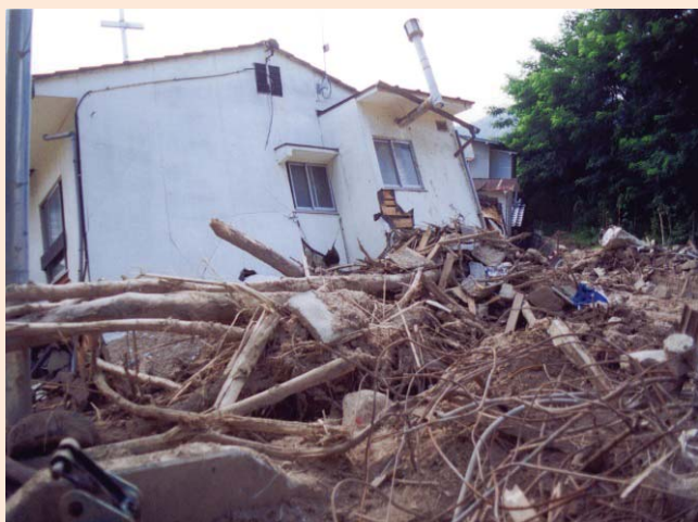
2. がけ崩れにより被災した家屋①
