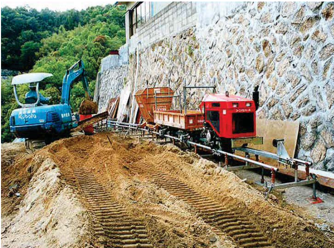
■ベルトコンベアによる土砂搬出
