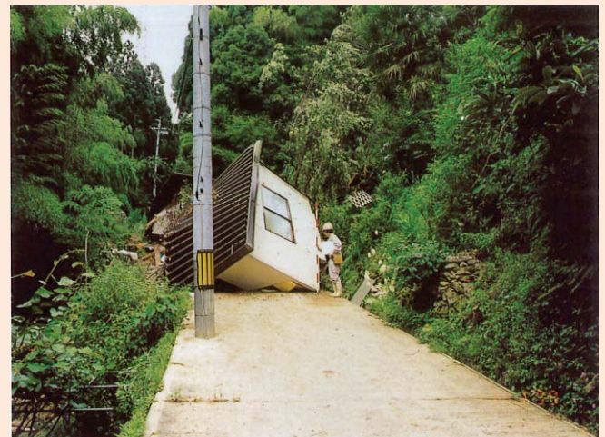
5. 道路に横たわった被災建物
