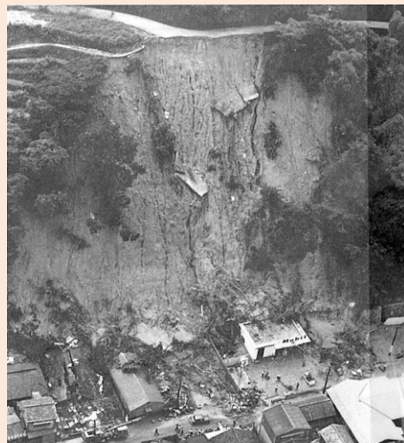
6. 被害の状況(警固屋5丁目)
