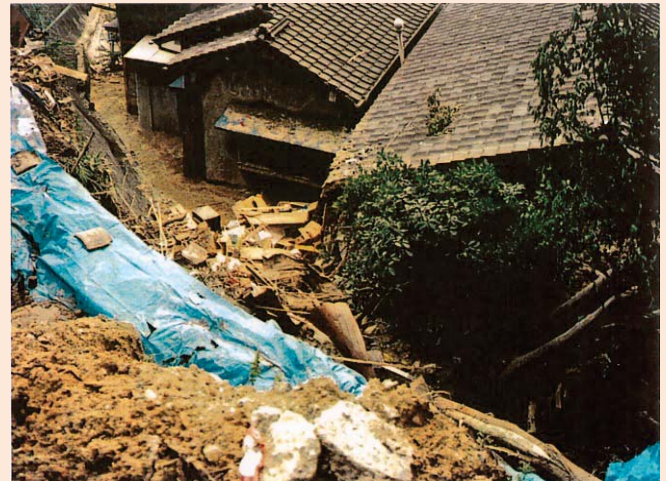
4. 土砂が流入した被災人家
