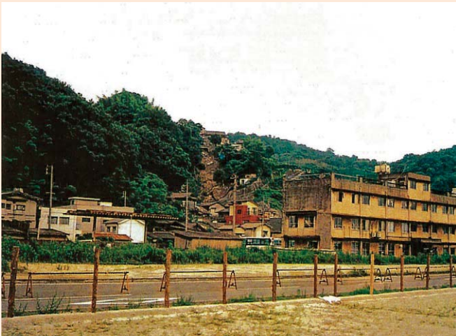
1. 災害発生斜面全体
