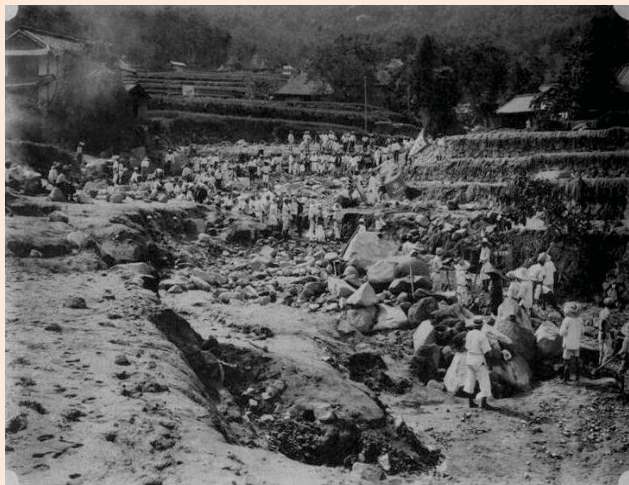
12. 復旧作業の様子 ②
