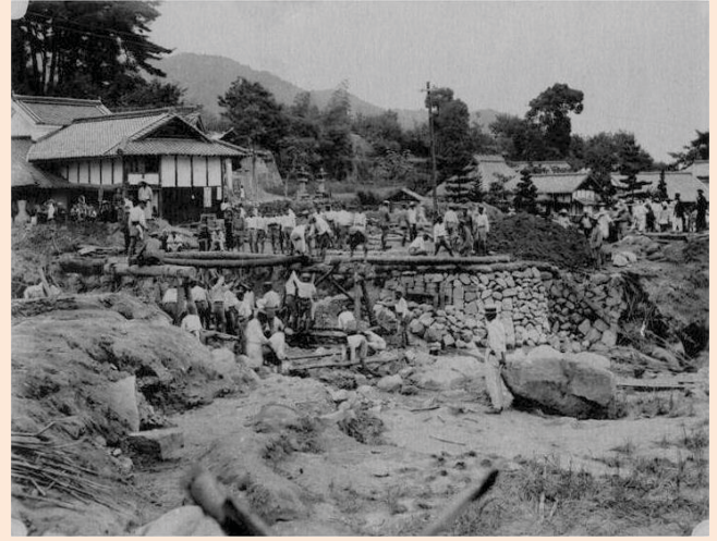
9. 復旧作業の様子 ①(工兵隊架橋工事)
