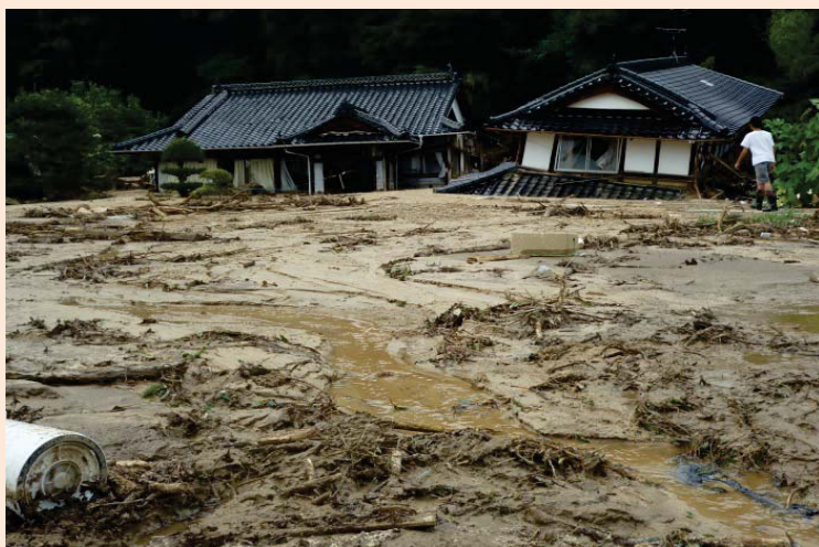
被害の状況【2】 提供:八敷福祉会
