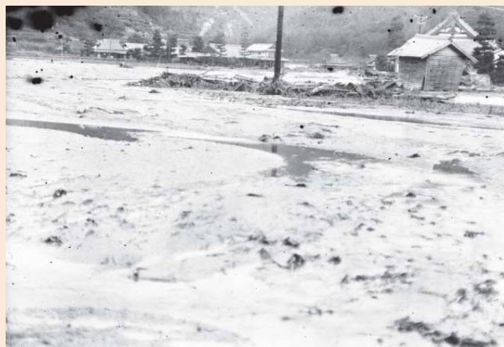
被害の状況【3】 提供: 廿日市市
