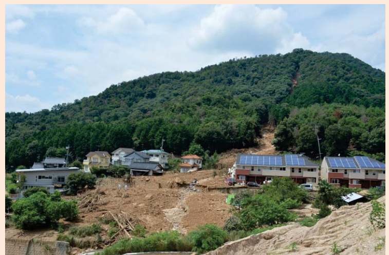
土石流の流下跡【5】 提供:新建自治会
