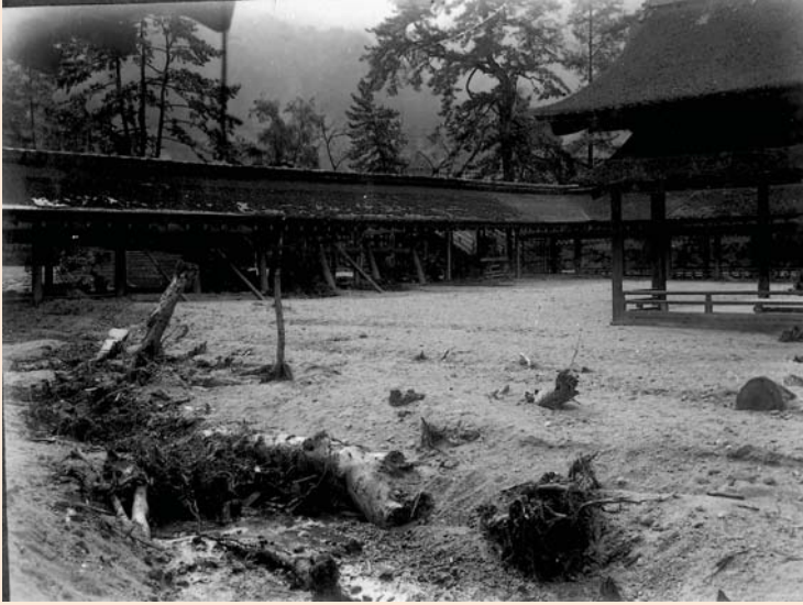
巖島神社の被災状況
