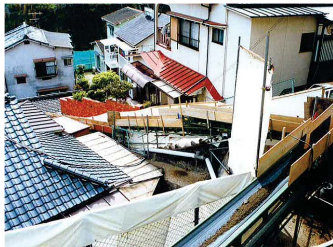
■ベルトコンベアによる土砂搬出
