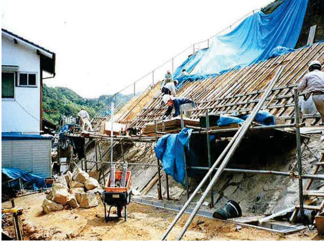
■モノレールによる土砂搬出状況
