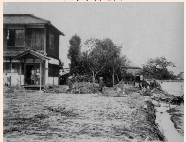
4. 被害の状況②(役場付近)
