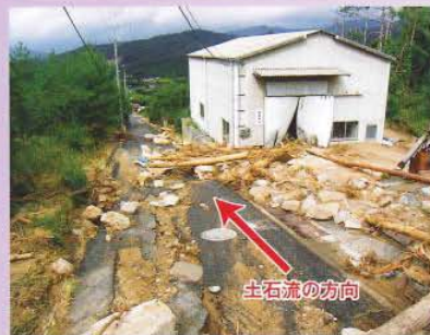
大久保川直下流の被災状況 (住宅団地を土石流が直撃しました。)
