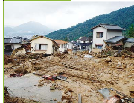
土砂の流出状況
