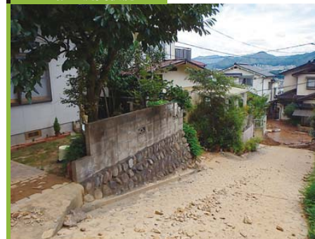
土砂の流出状況
