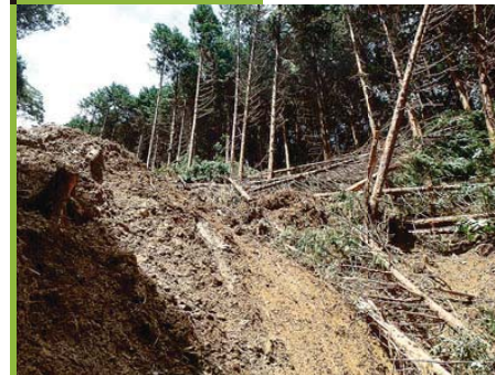
溪流の荒廃状況
