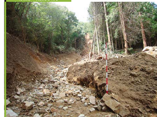
溪流の荒廃状況
