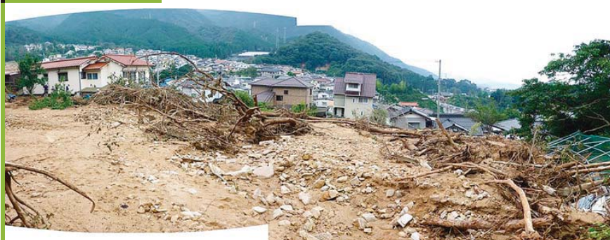
土砂の流出状況
