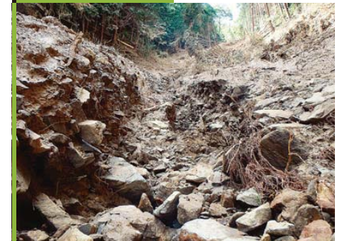
溪流の荒廃状況
