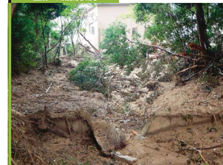
土砂の流出状況
