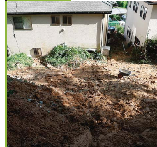
崩土の流出状況
