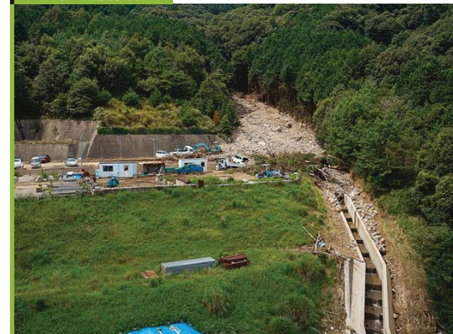
土砂の流出状況
