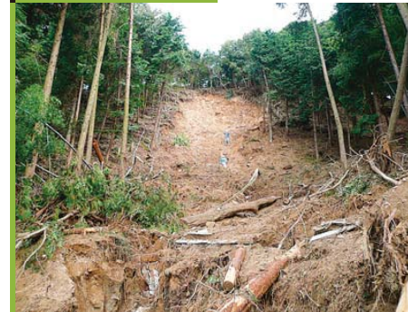
斜面崩壊状況
