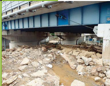
土砂の堆積状況
