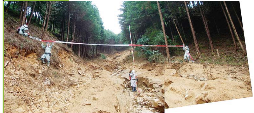
溪流の荒廃状況
