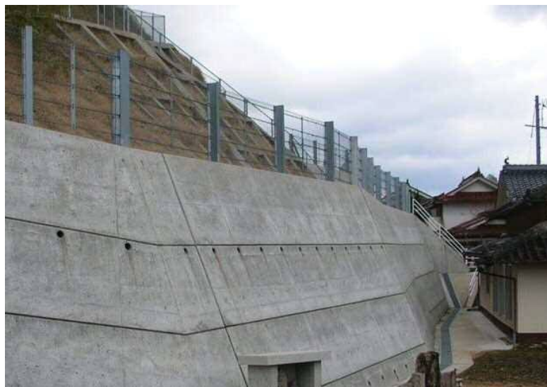
待受擁壁工施工事例（三次市）
