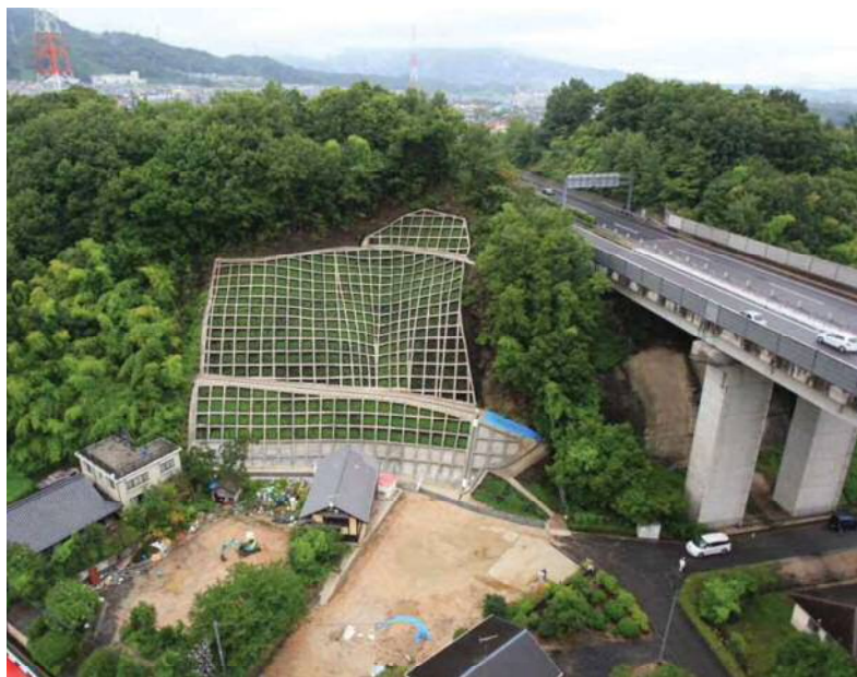
法枠工施工事例（廿日市市）
