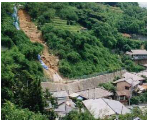
待受擁壁工の土砂災害捕捉事例 (平成11年 呉市)
