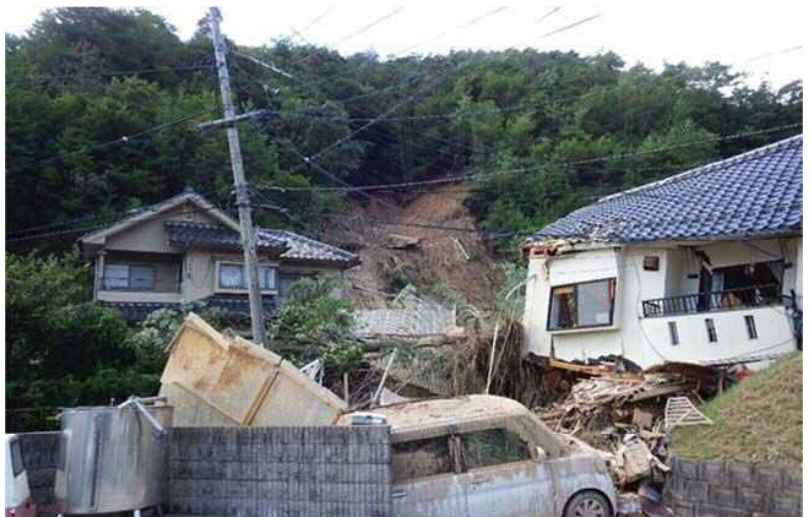
がけ崩れ被災状況（平成26年8月20日 広島市安佐北区）
