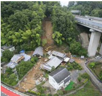
被災状況(平成25年 廿日市市)
