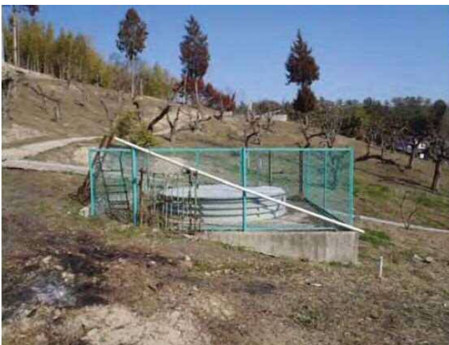
集水井工施工事例（福山市）
