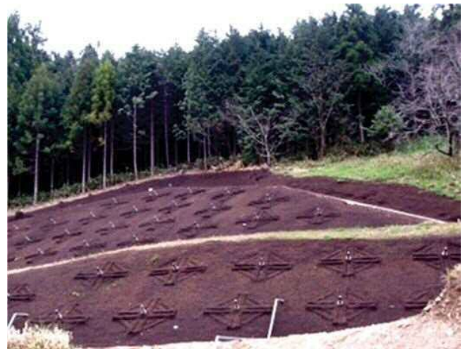
アンカー工施工事例（広島市佐伯区）
