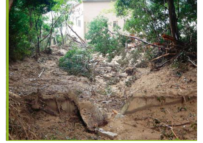
土砂の流出状況
