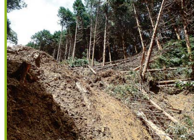
溪流の荒廃状況
