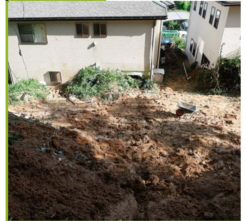
崩土の流出状況
