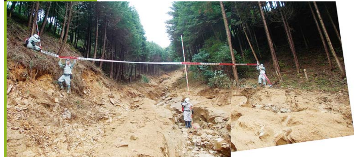
溪流の荒廃状況
