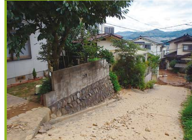
土砂の流出状況
