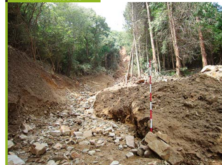
溪流の荒廃状況
