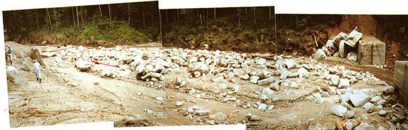
江河内谷川 施工中ダムの堆砂状況
