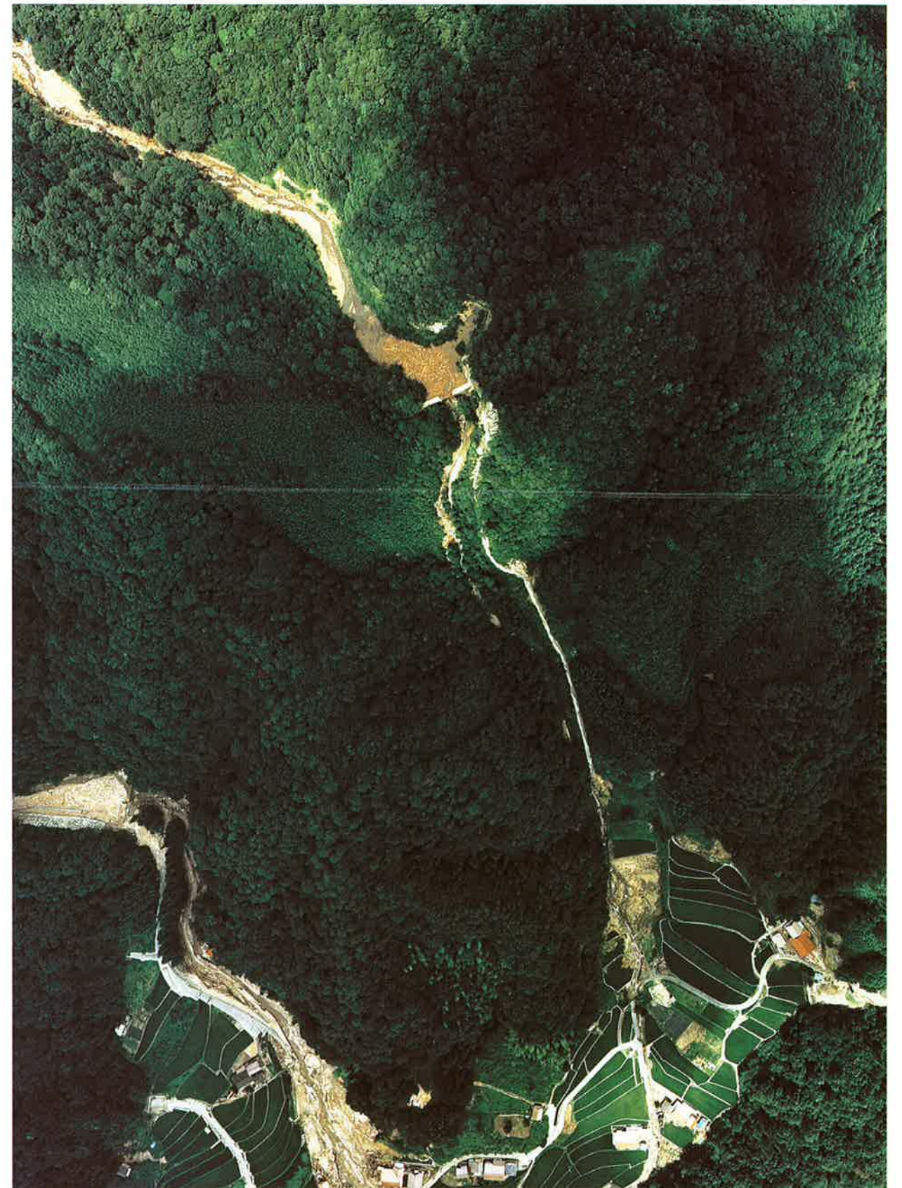
中央は土砂、流木を抑止した江河内谷川ダム、左下は建設中砂防ダムと氾濫状況
