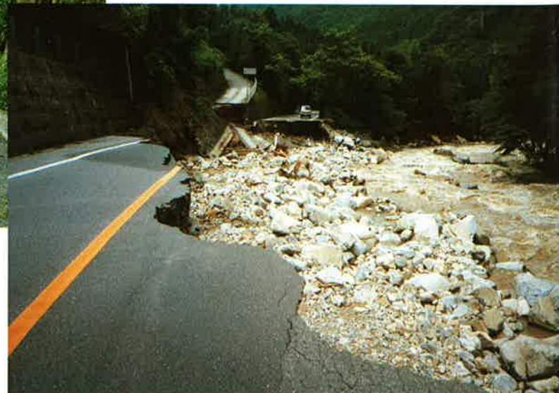
国道191号(戸河内町梶ノ木)
