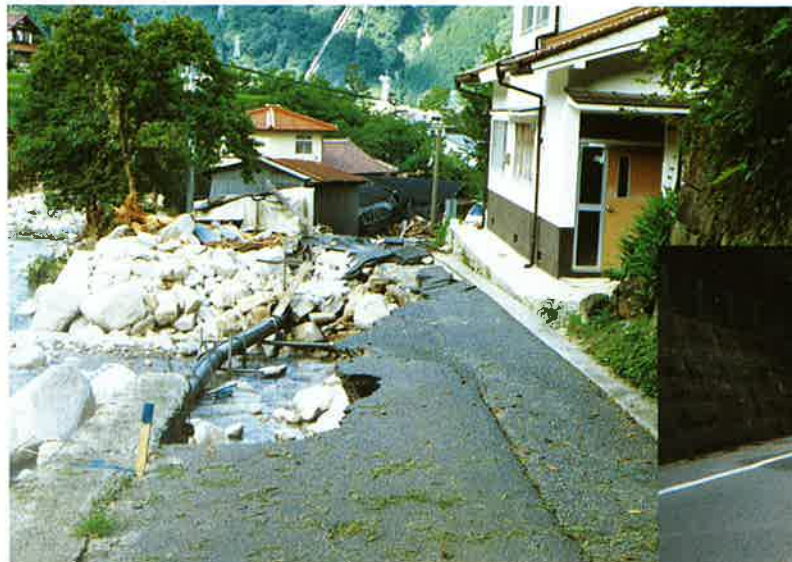
深山川の増水により流失した県道
