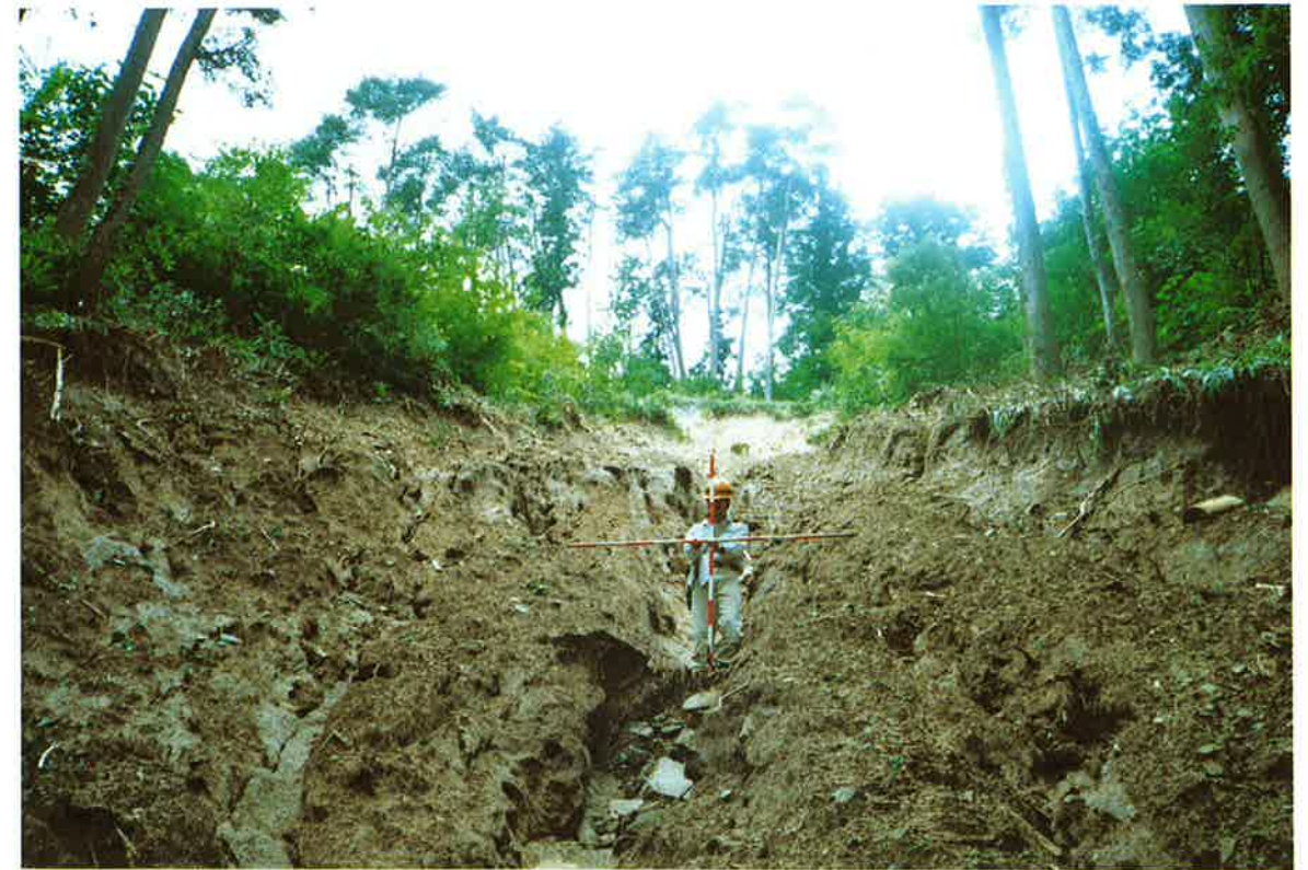
氾濫した中尾谷川最上流(土石流源頭部)
