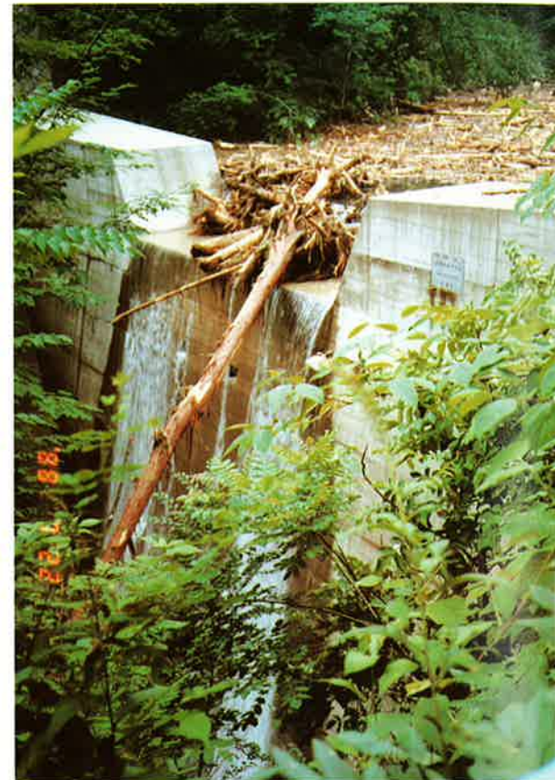
被害の拡大をくい止めた60年完成江河内谷川ダム
