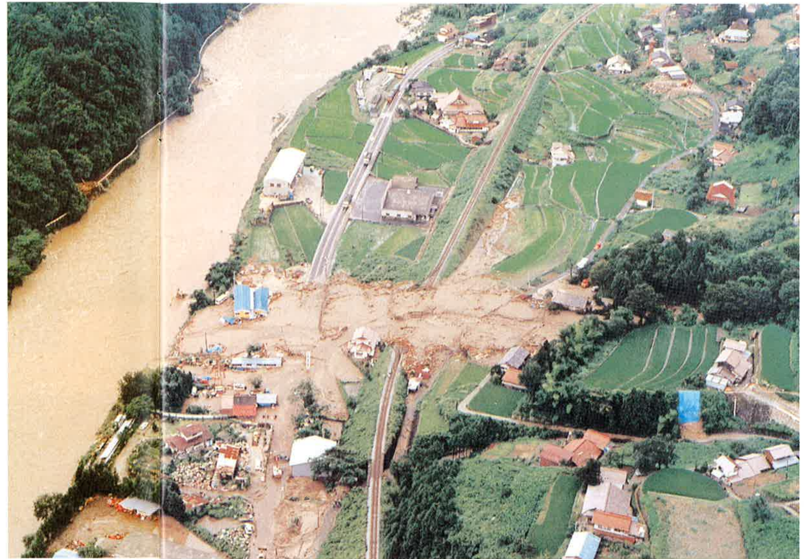
氾濫した上木坂川
