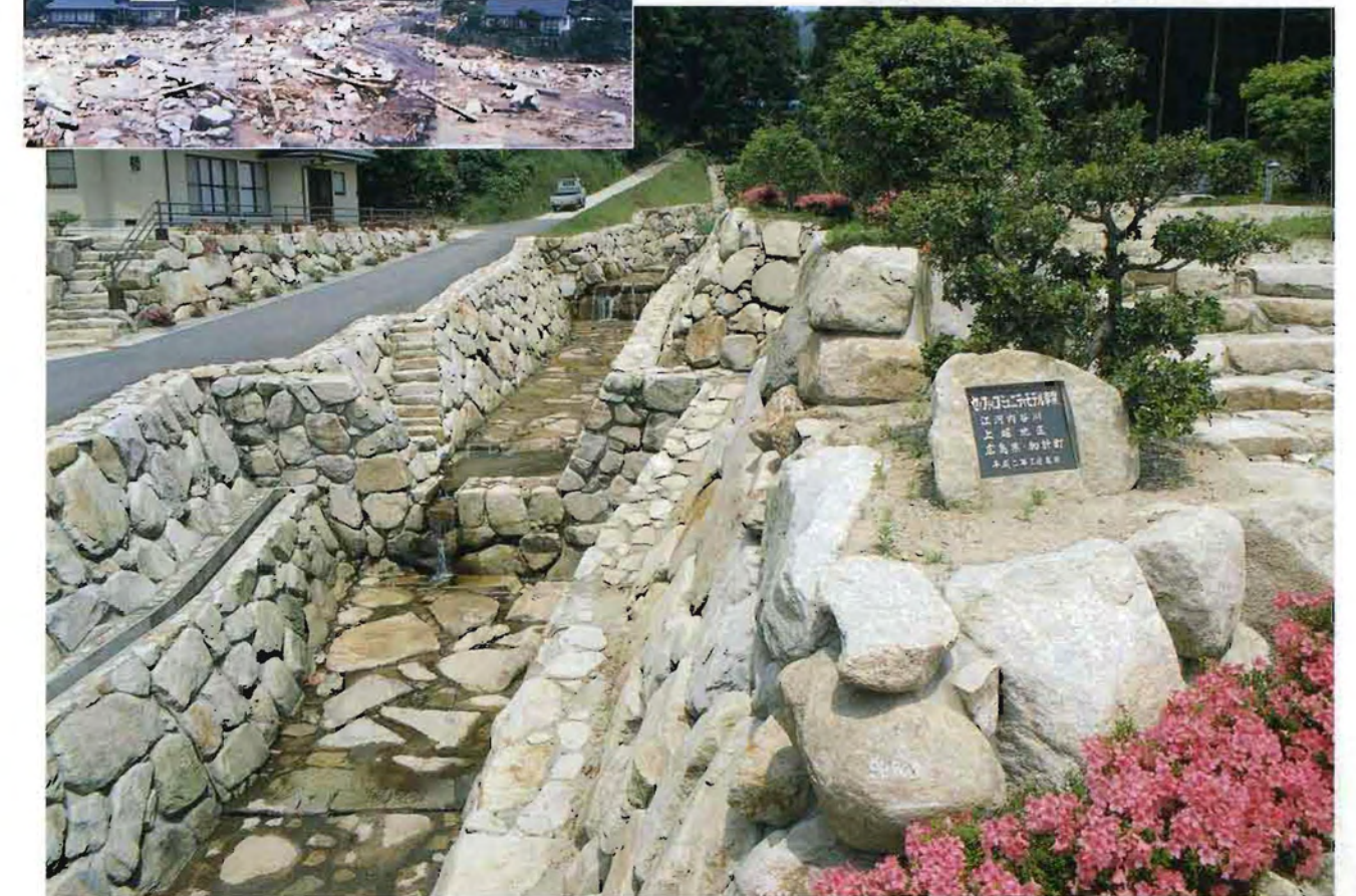
本川関連（流路工）修景護岸を下流より望む
