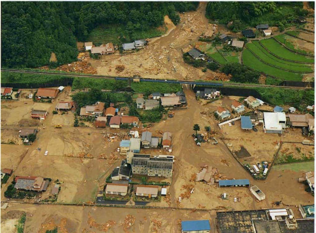
江河内谷川被災状況写真（下流上堀地区）
