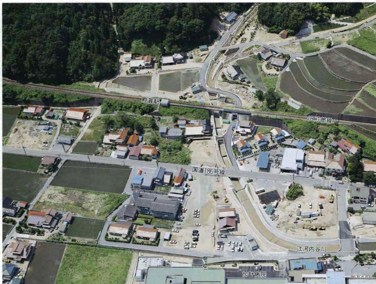
江河内谷川復旧状況写真（下流上堀地区）
