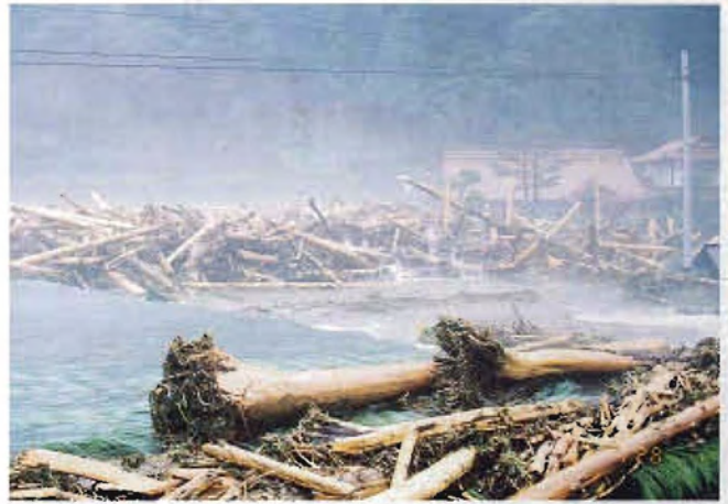
▲ 田吹川 流木堆積状況
