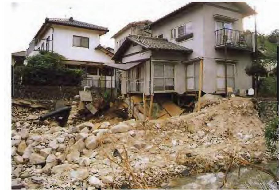
土石流による護岸・家屋被害状況
