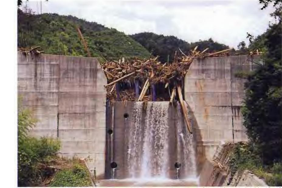
土石流を止めた砂防ダム（土石流・流木捕捉状況）
