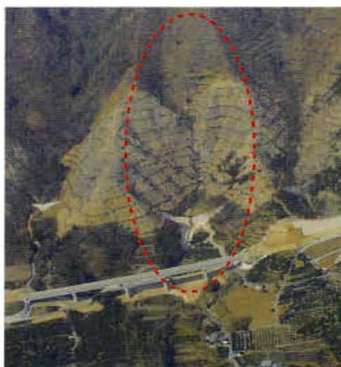
砂防施設設置
