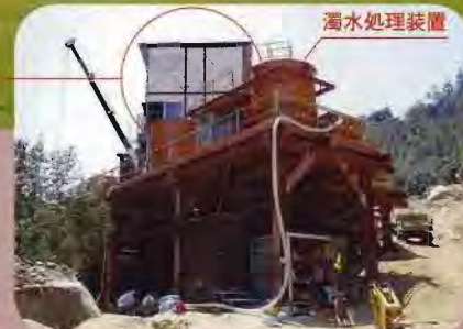
空輸により現地に設置された仮設プラント
