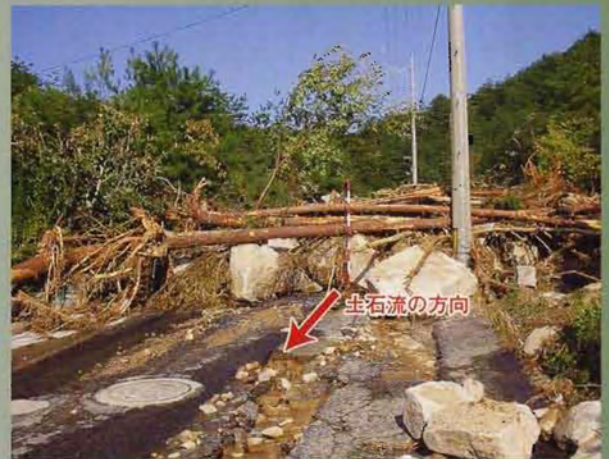
団地内道路の被災状況
