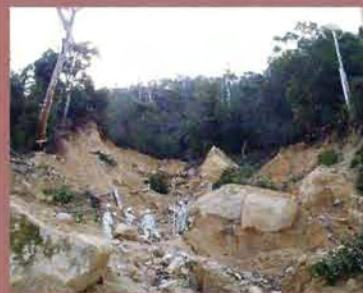
源頭部荒廃状況
