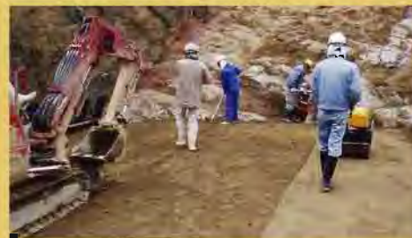
砂防ソイルセメント工法の施工状況 (現地土とセメントを混ぜて堤体を作るこの工法により、残土処分の軽減、コンクリート材料の使用量及び運搬費の軽減等によりコスト縮減、工期短縮を計りました。)
