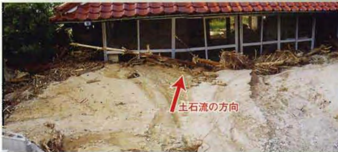
住宅の被災状況
