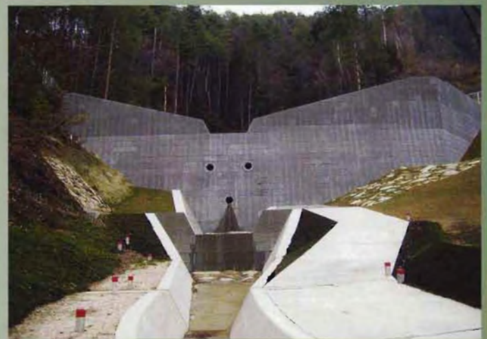
完成した大久保川砂防堰堤 堰堤高H=9.5m 堰堤長L=62m
