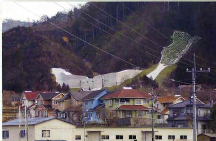
完成した泉水南谷川砂防堰堤 堰堤高H=8.5m 堰堤長L=76m
