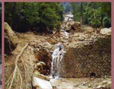
中流部荒廃状況(2号堰堤付近)
