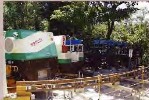
モノレールによる資材運搬は、登山道を利用し沿道の樹木を保護しながら行いました。
