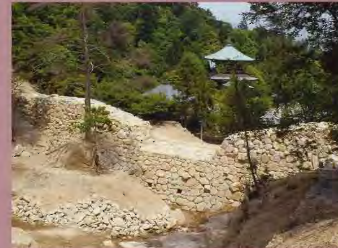
現地発生した石を堰堤表面に張って周辺景観に配慮しました。
