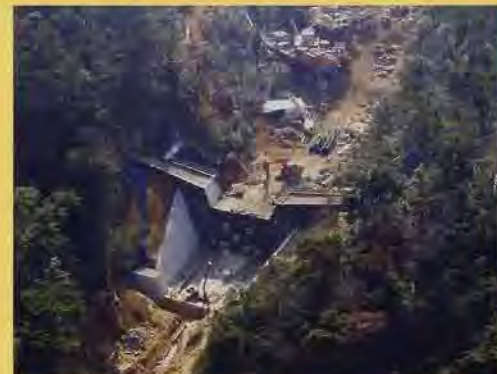
上空から見た施工中の1号堰堤
