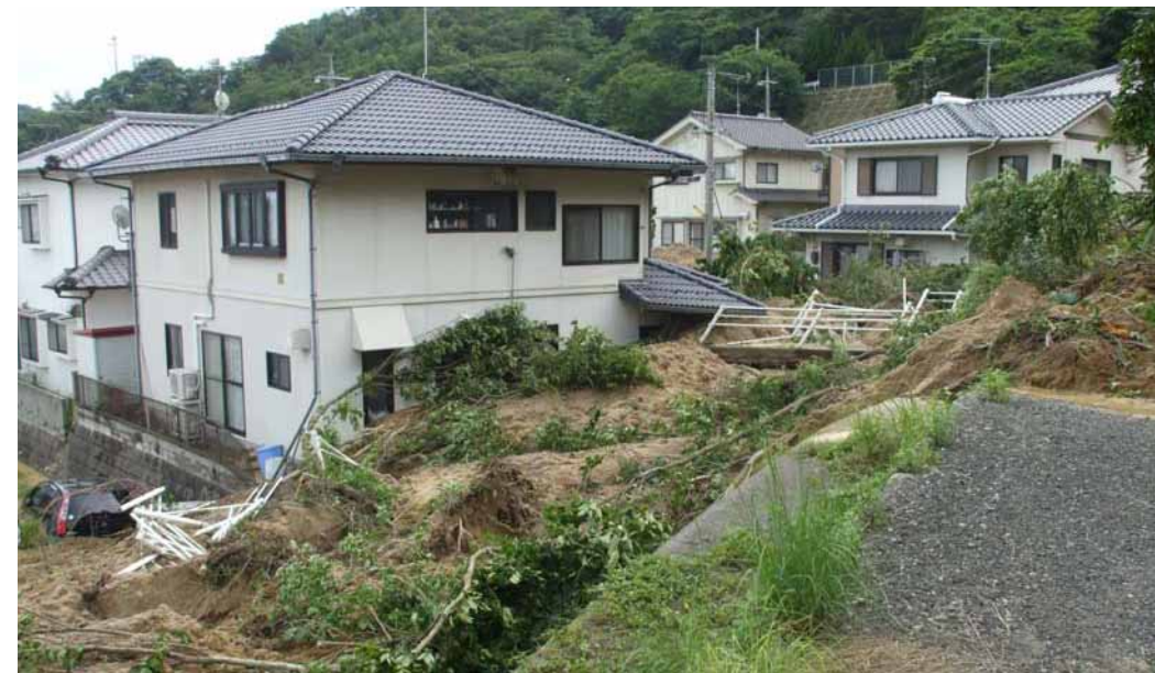
土石流が流入した家屋（安登中央川支川）
