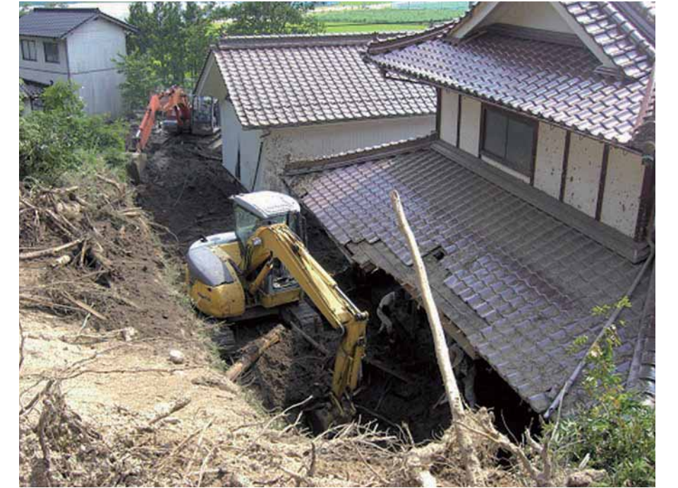
土砂による家屋の損壊
