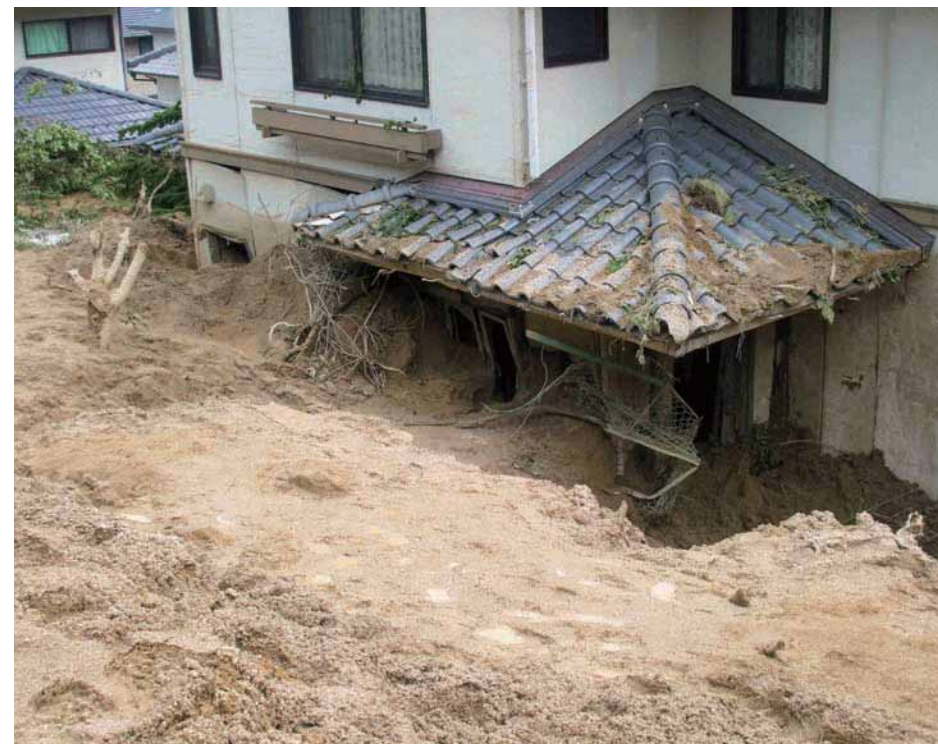
土石流による家屋の被害
