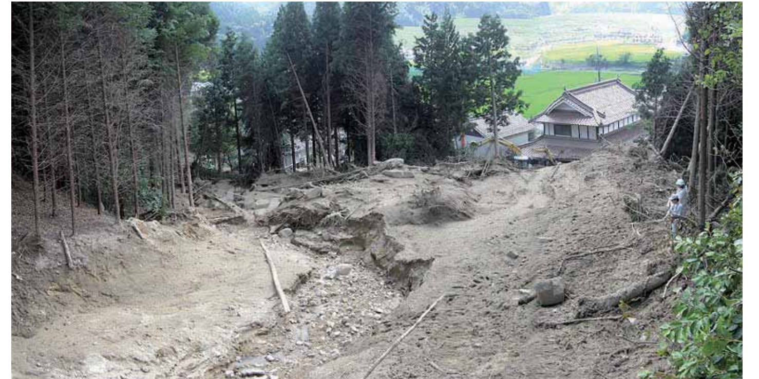
斜面上部より保全対象箇所を望む
