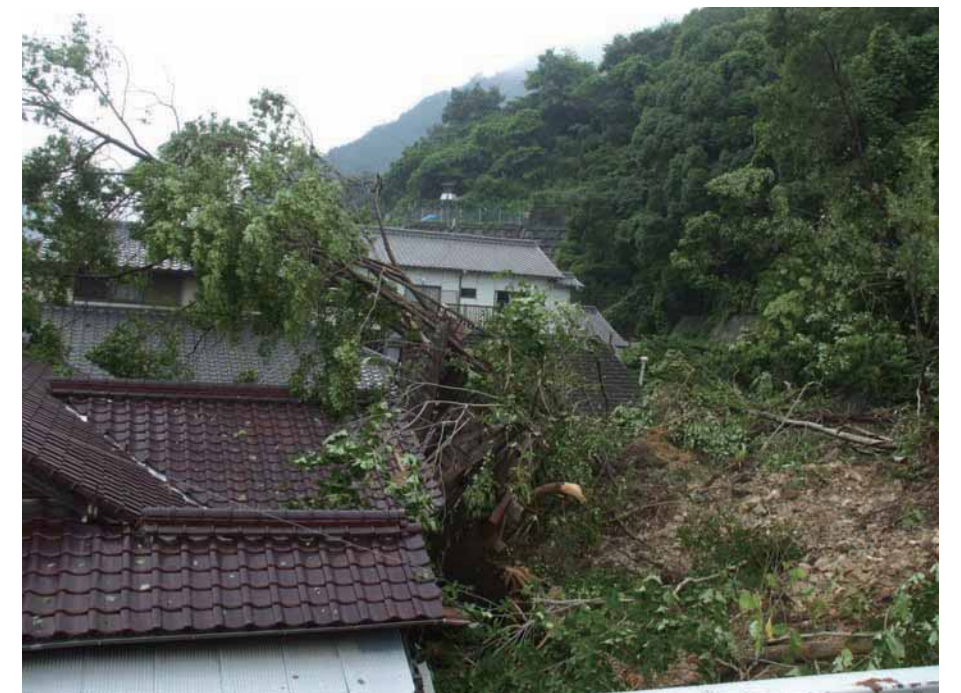
土砂による家屋の損壊
