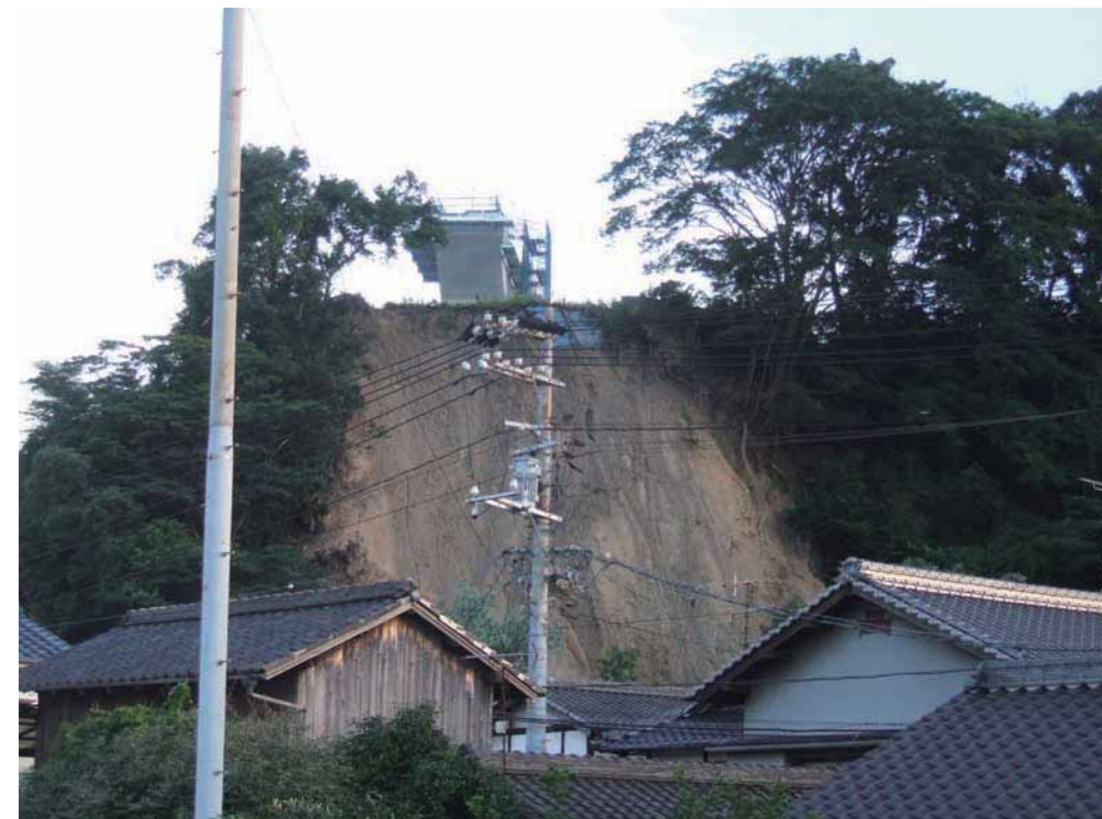
崩壊した斜面上部の状況
