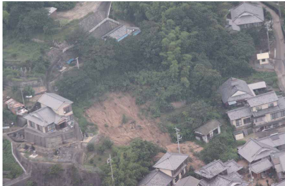
13 災害発生斜面の全景
