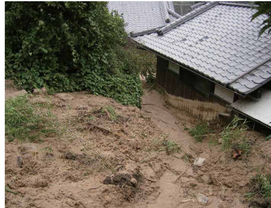
民家を埋めた崩壊した大量の土砂
