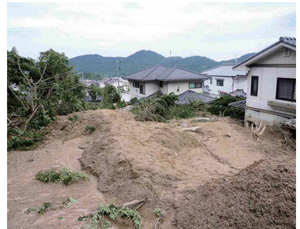
流出した大量の土砂による家屋軒下までの埋没
