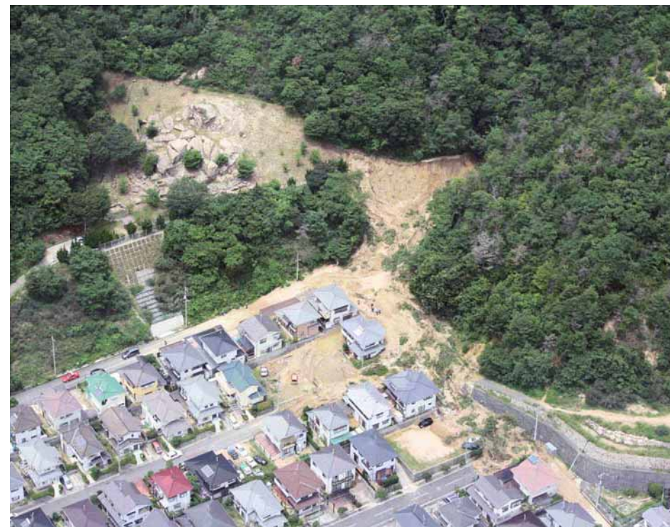
5 安登中央川支川の氾濫状況
