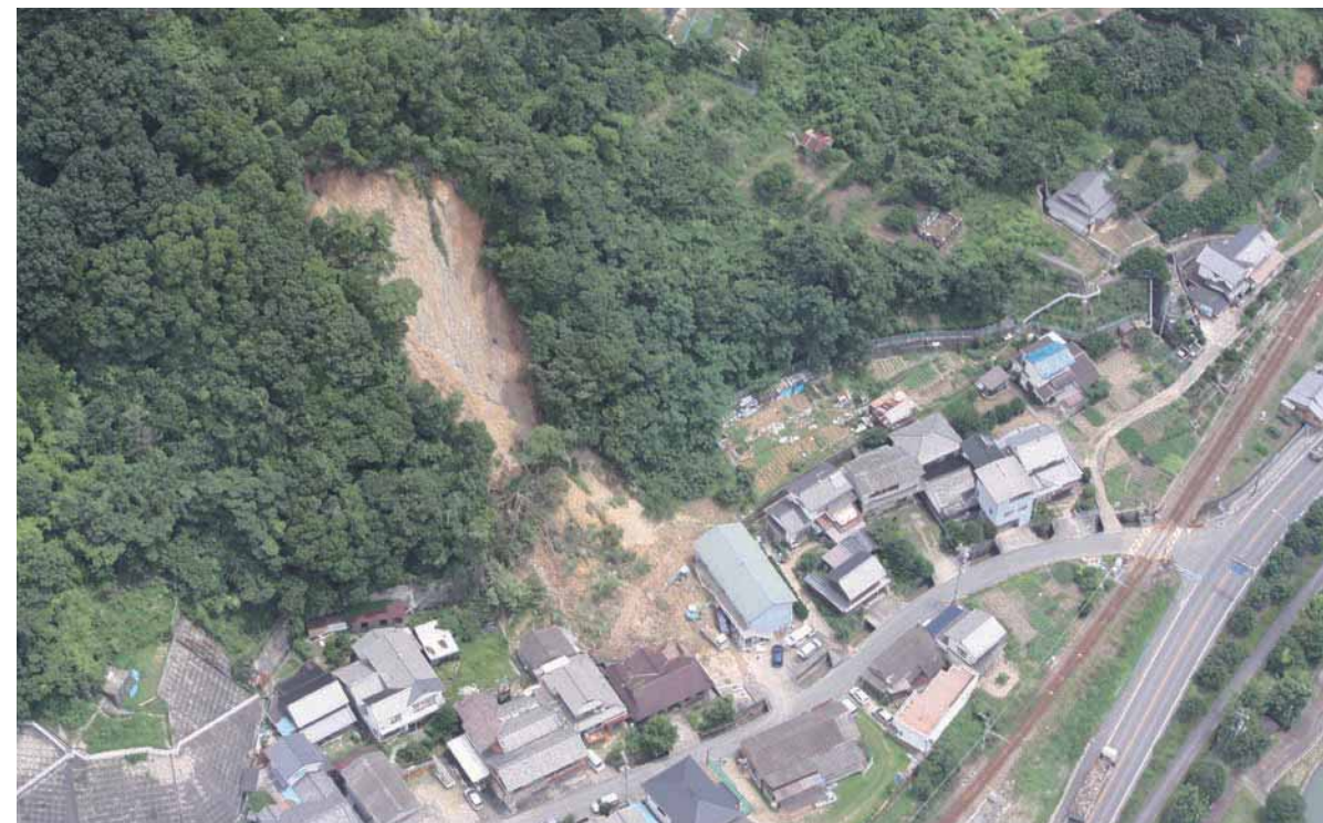
9 災害発生斜面の全景
