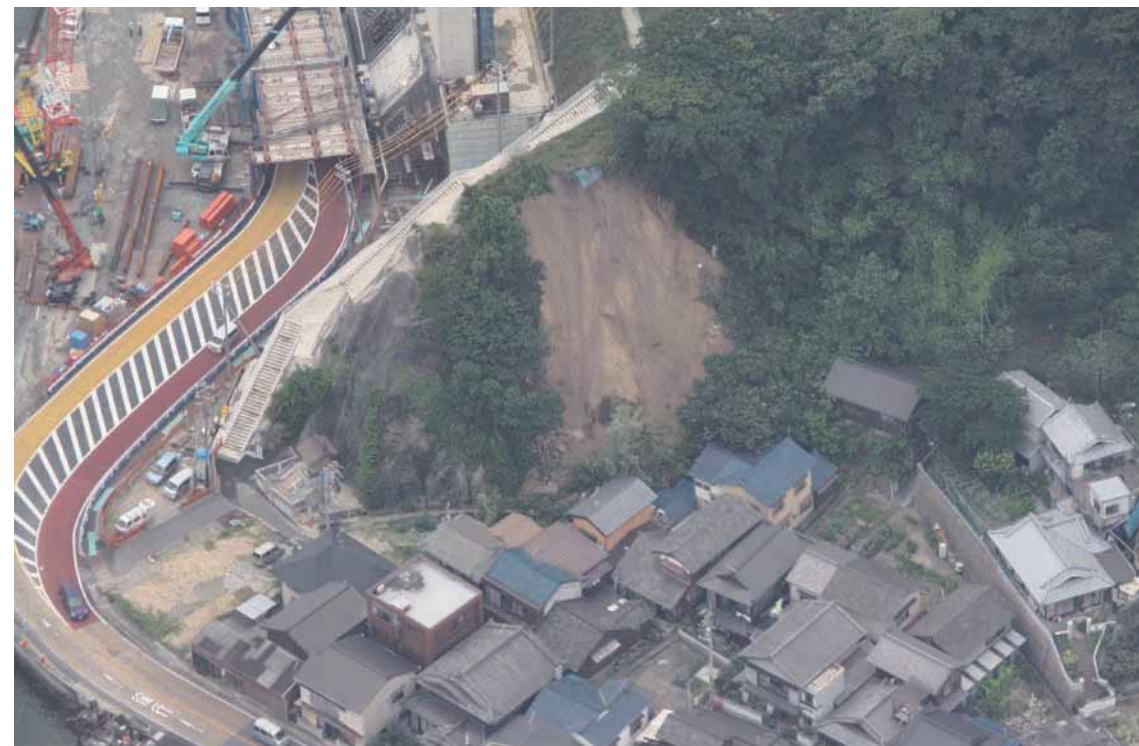
11 災害発生斜面の全景
