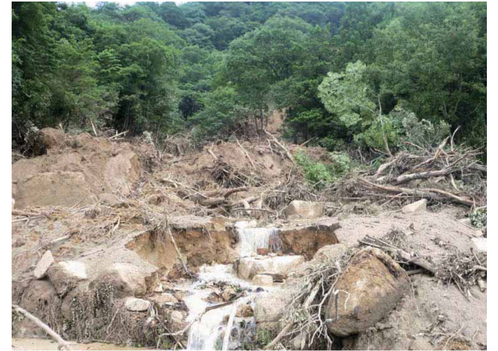
谷出口付近の土砂流出の状況
